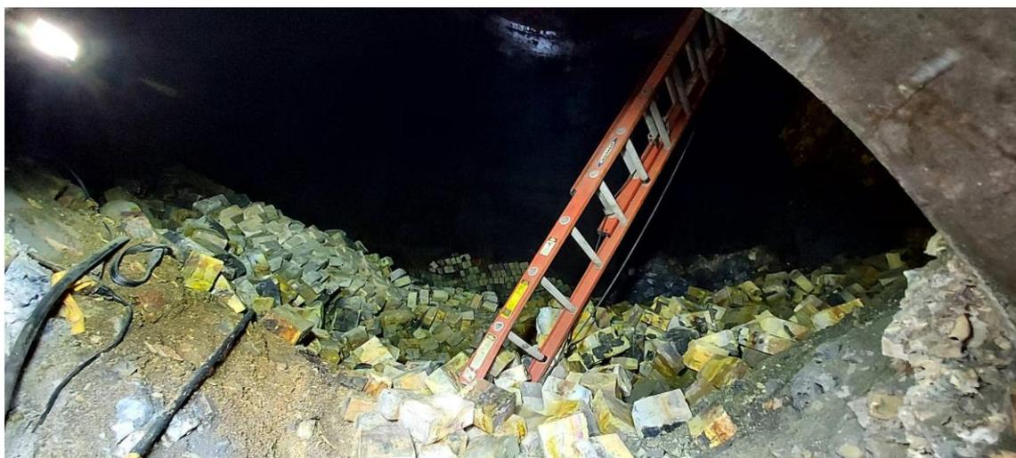
照片 3 反應爐內留有作業時使用之移動梯，地面散落大量耐火磚。
