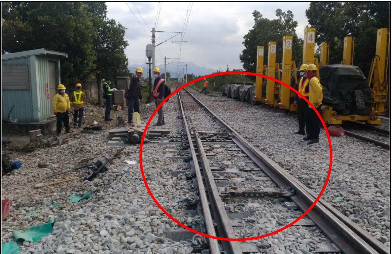
說明 照片一：災害發生於海端火車站主正線軌道上（花蓮起 118K+951.5m 處）。
