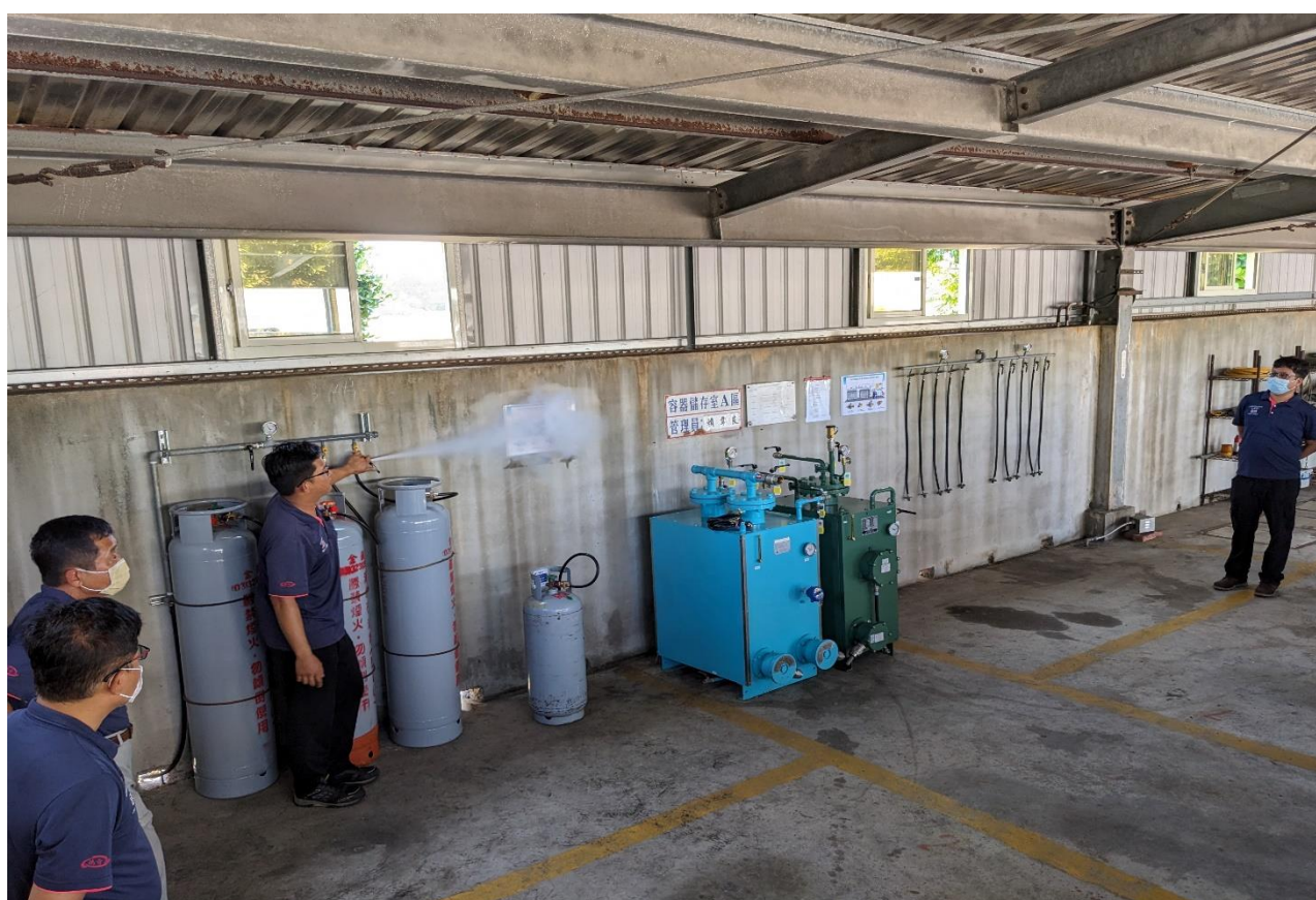
· 現場示範發生洩漏時逆止閥作動實務
