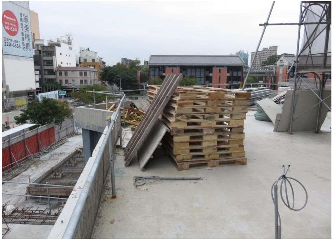
照片 7：施工架上方堆置鋼筋。
