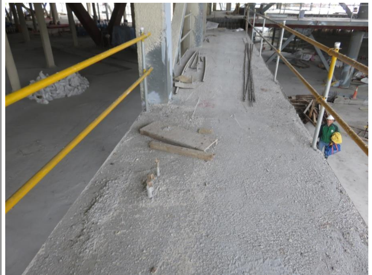
照片 3：走道鋼筋外露未設保護套或彎折
