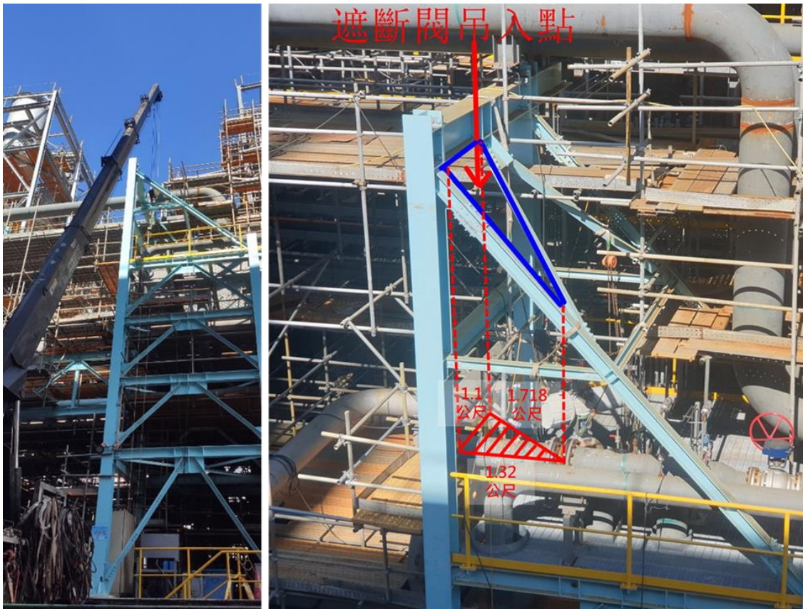
照片 1 吊掛之遮斷閥舉升後由鋼構斜撐之上方開口降下。
