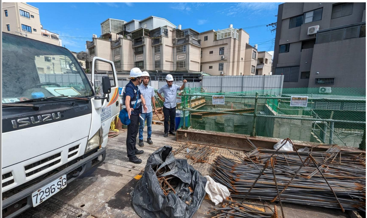
臺中市政府勞動檢查處許瀚丞副處長率檢查員前往臺中市某建築工程實施勞動檢查。
