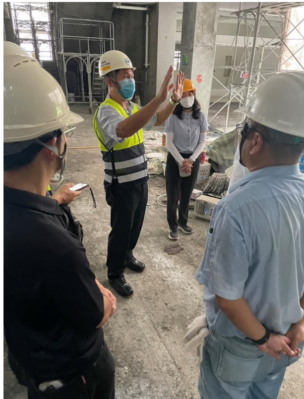
本署南區職業安全衛生中心林梧司副主任率檢查員前往臺南市某建築工程實施勞動檢查。
