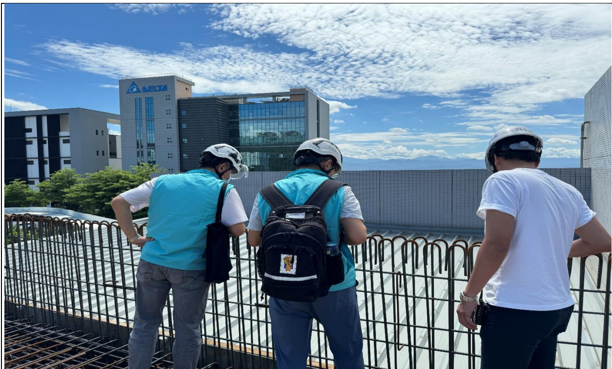
中科管理局莊志峰組長率檢查員針對彰化縣二林園區某廠房工程實施勞動檢查。
