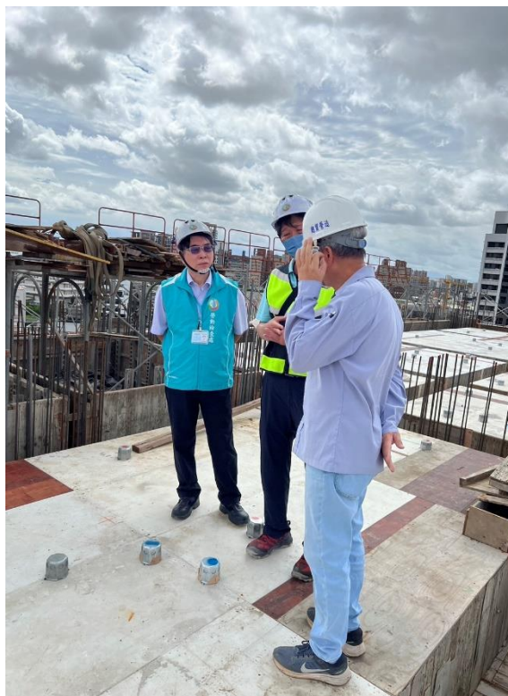
高雄市政府勞工局勞動檢查處劉得成專門委員率檢查員前往高雄市某建築工程實施勞動檢查。
