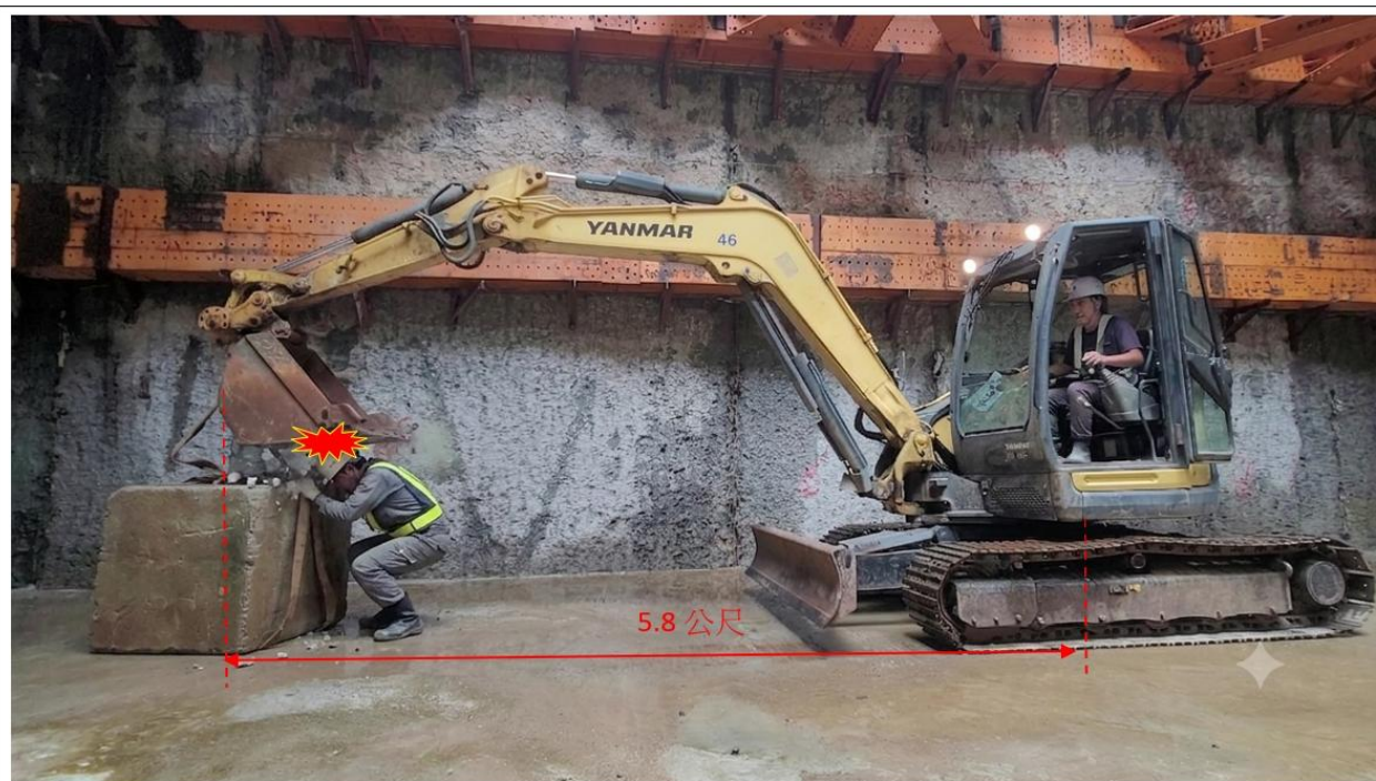
說明：動力鏟臂展 5.8 公尺的作業半徑，吊掛 2.4 公噸荷重搬運混凝土塊。（模擬照片）
