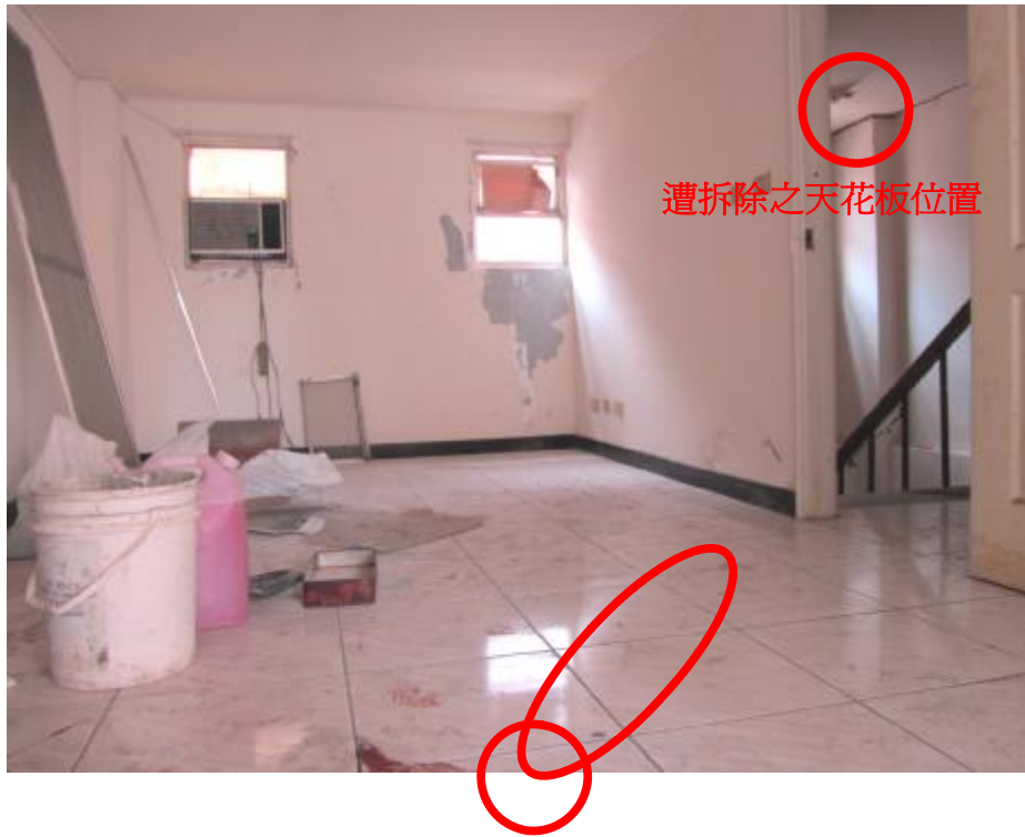
附照 3 | 自五樓樓板往樓梯方向拍攝。
