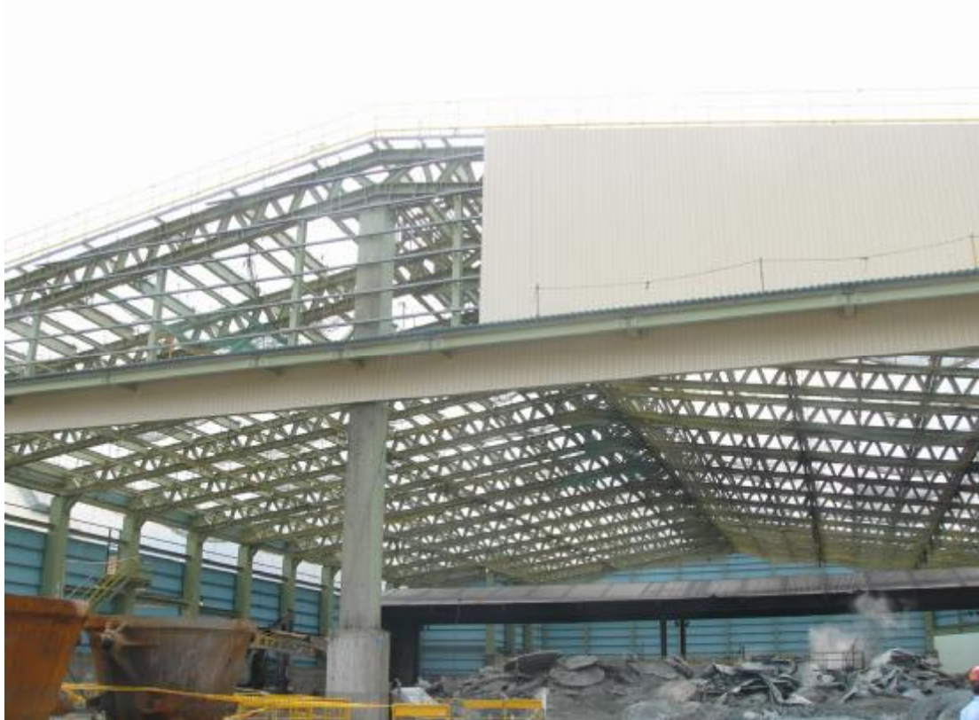
照片 2 現場照片
