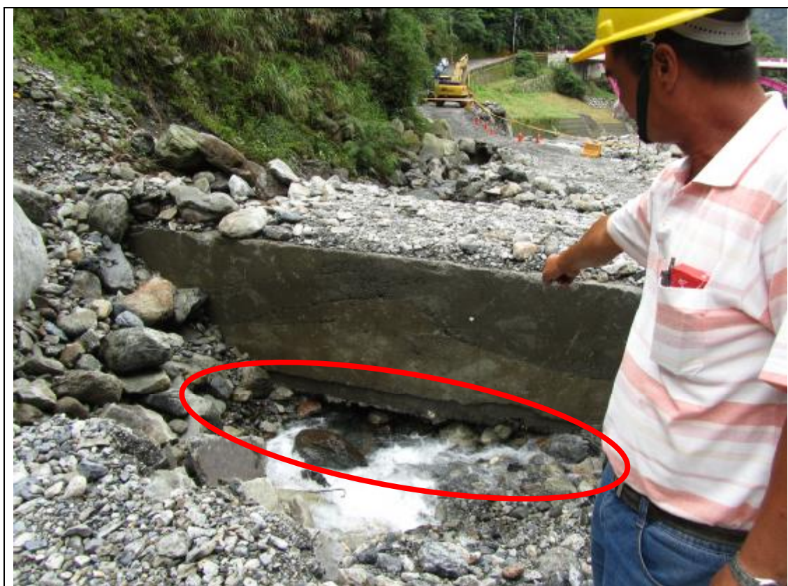
附照 1 | 罹災者被發現位置(紅圈處即為發現罹災者位置)。
