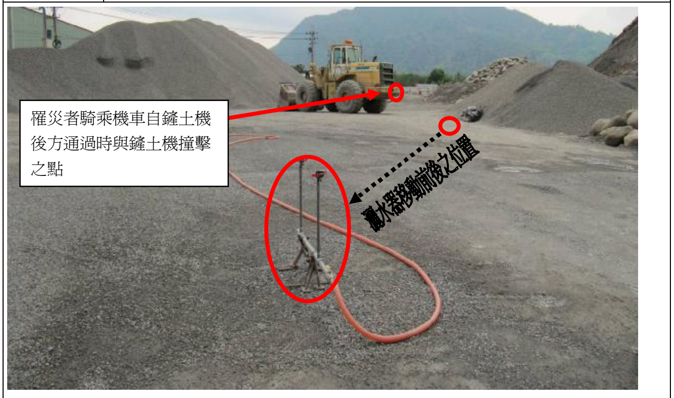
說明 | 鏟土機左側及左後方之情形
