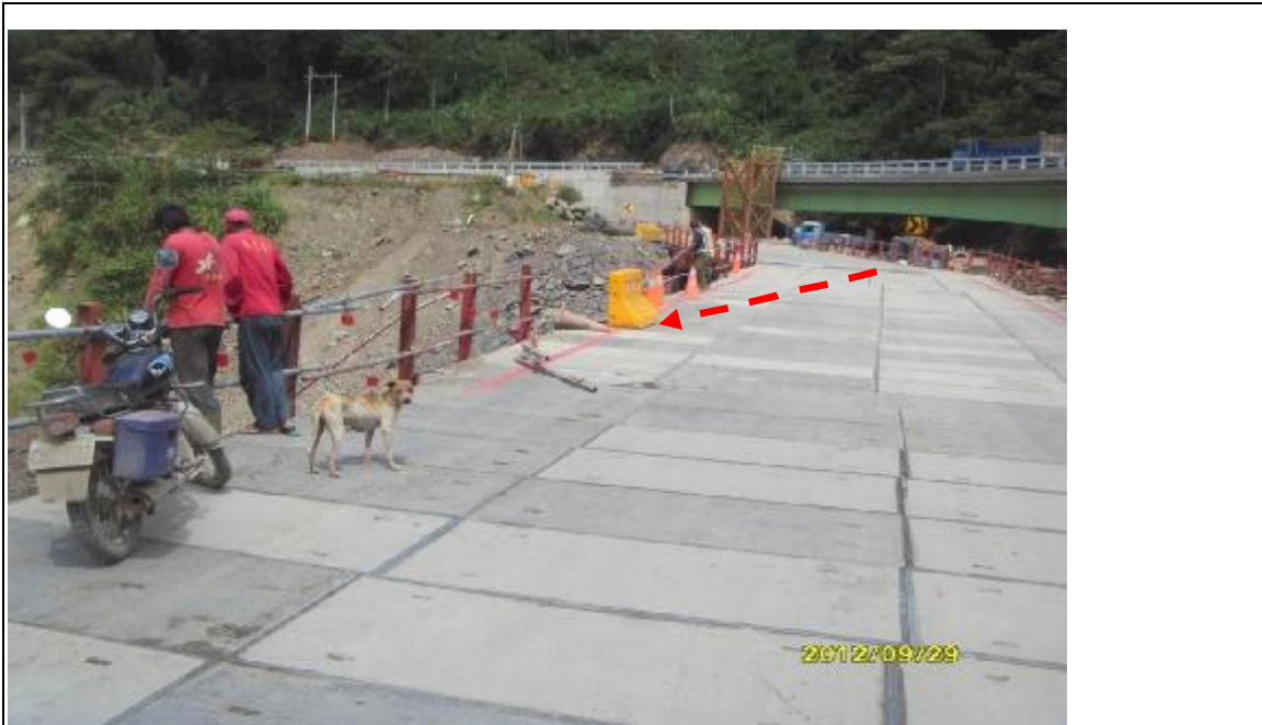
災害現場吊卡車翻落處(車輛滑動行徑)
