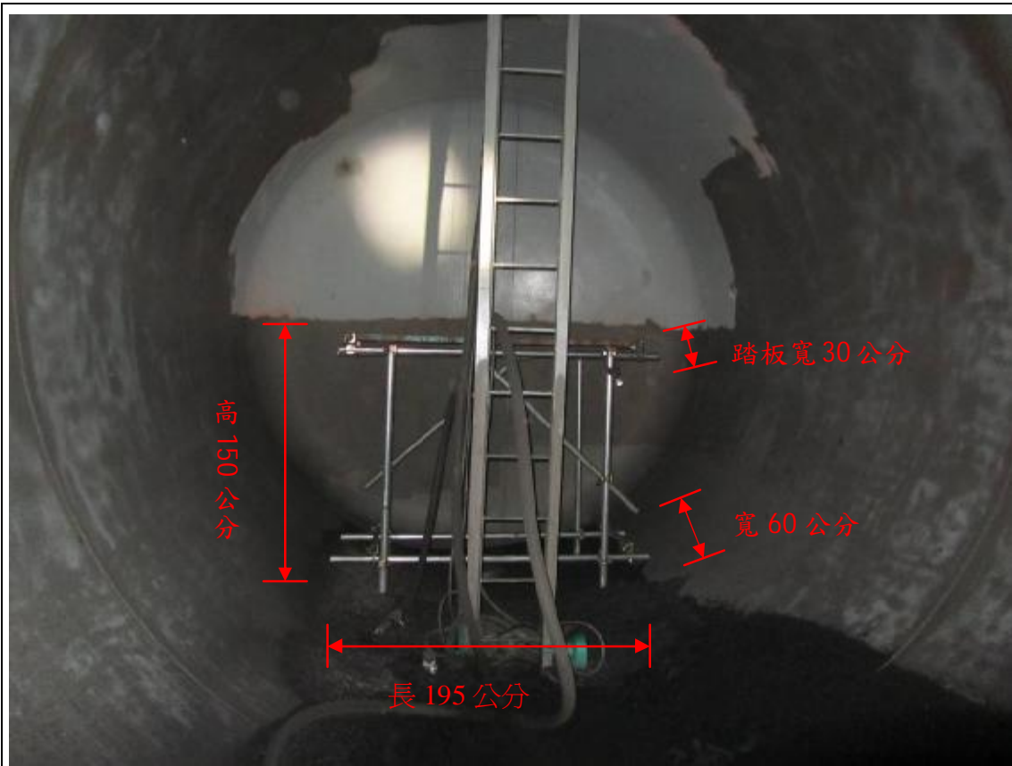
照片三 油槽內有一座作為工作台作用之施工架長 195 公分、寬 60 公分、高 150 公分、工作台踏板 30 公分。
