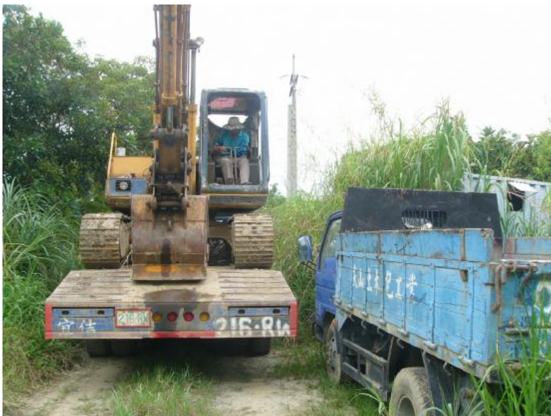
照片 1 現場照片
