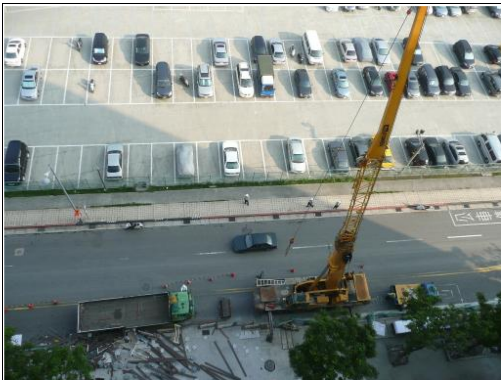
說明 一 災害現場俯瞰圖
