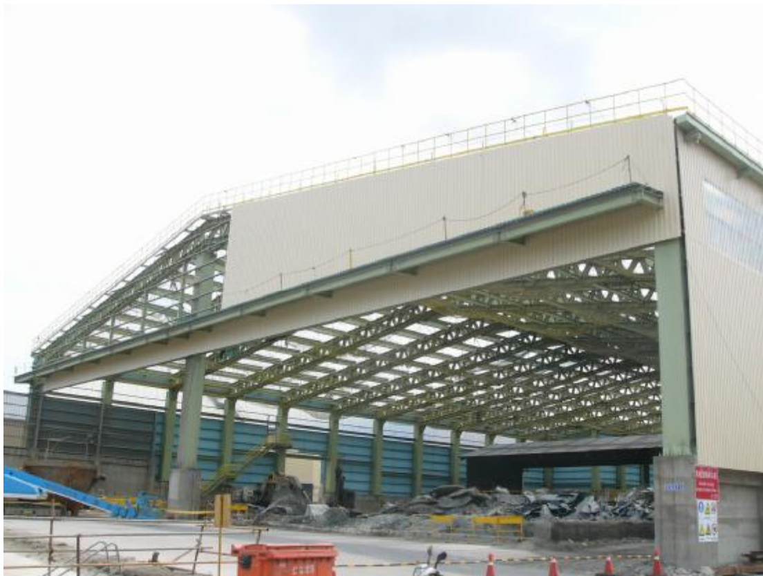
照片 1 現場照片
