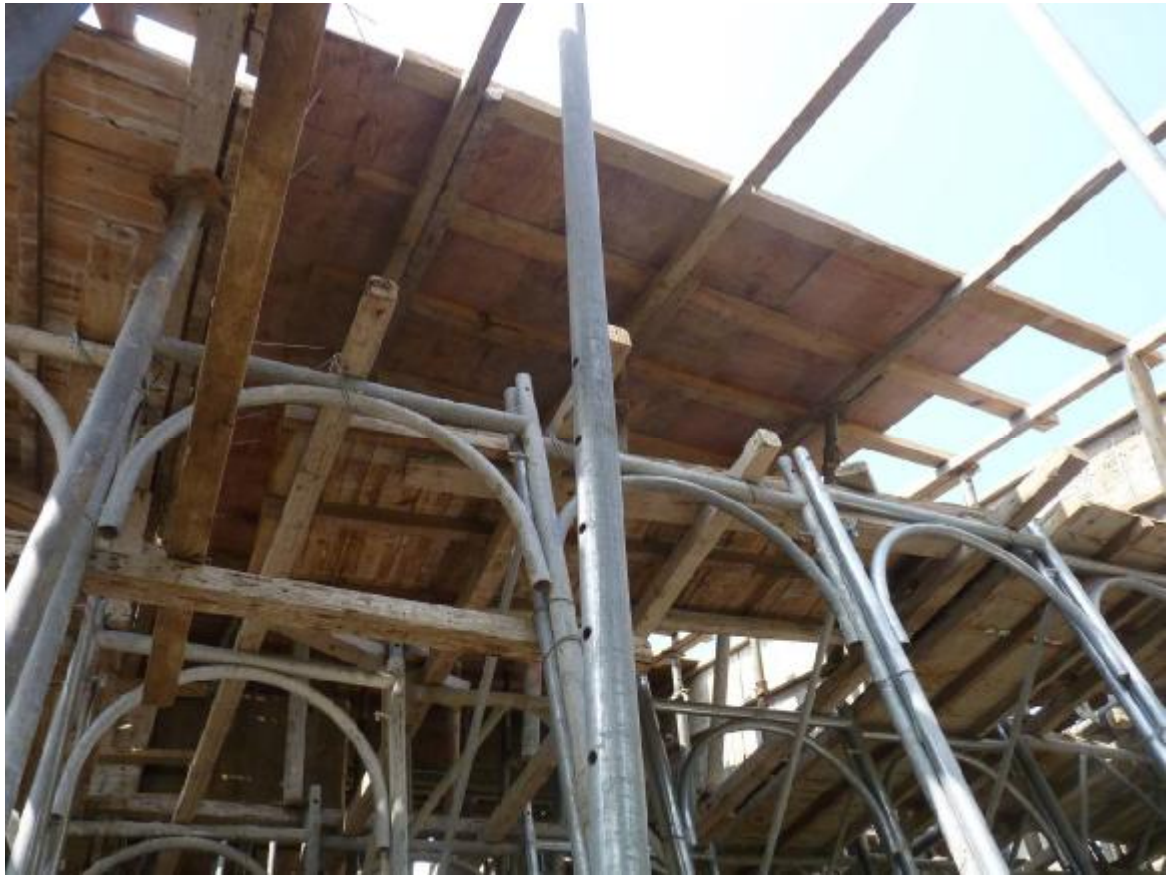
照片罹災者災害發生時從事 4 樓屋頂模板組立作業之位置
