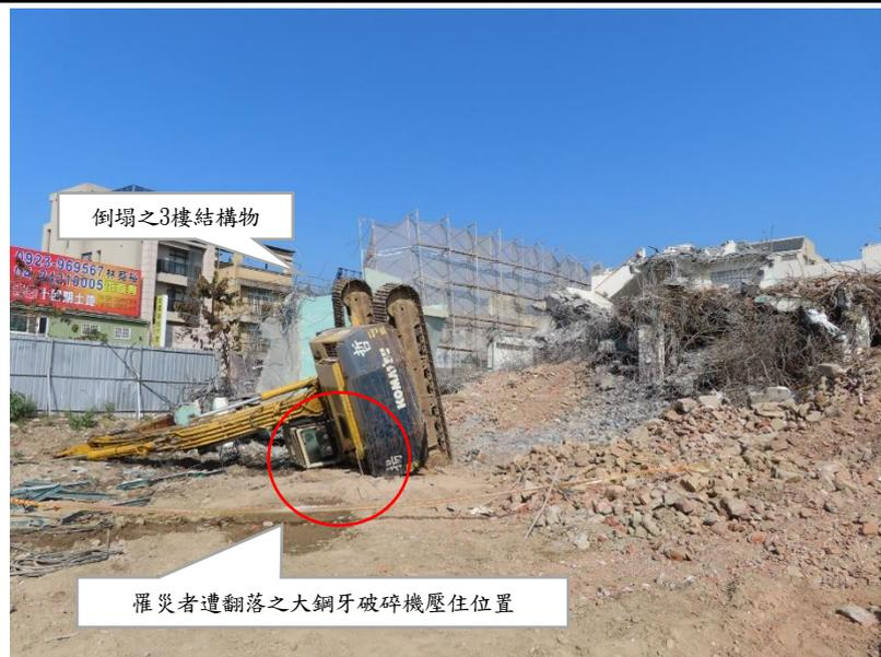
罹災者操作大鋼牙破碎機於建築物進行北側2樓樓板破碎作業。罹災者同仁亦操作另一輛大鋼牙破碎機進行東側3樓樓梯間破碎作業。
