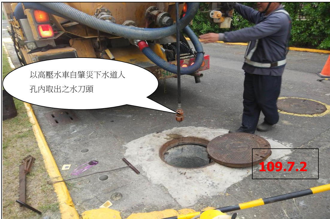
說明 照片 5：該肇災高壓水車(三〇〇〇公司所有)，高壓水管已連接水刀頭。
