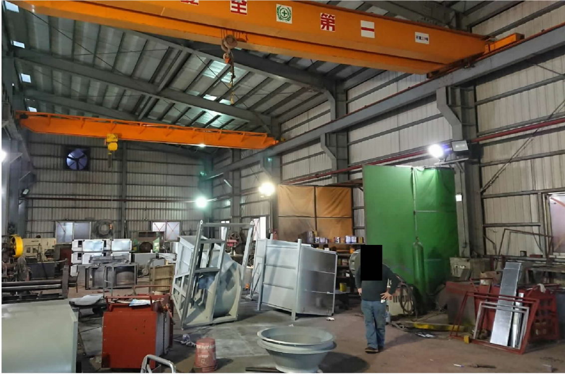
照片 1 災害現場照片。
