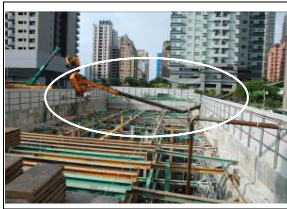
移動式起重機於從事吊掛鋼筋作業，發生起重機翻覆、伸臂彎曲。
