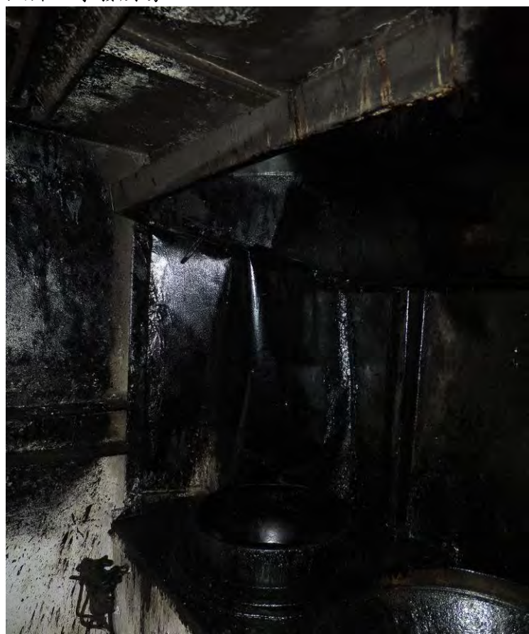
照片 2 廚房加熱鍋東北側瀝青噴濺狀況
