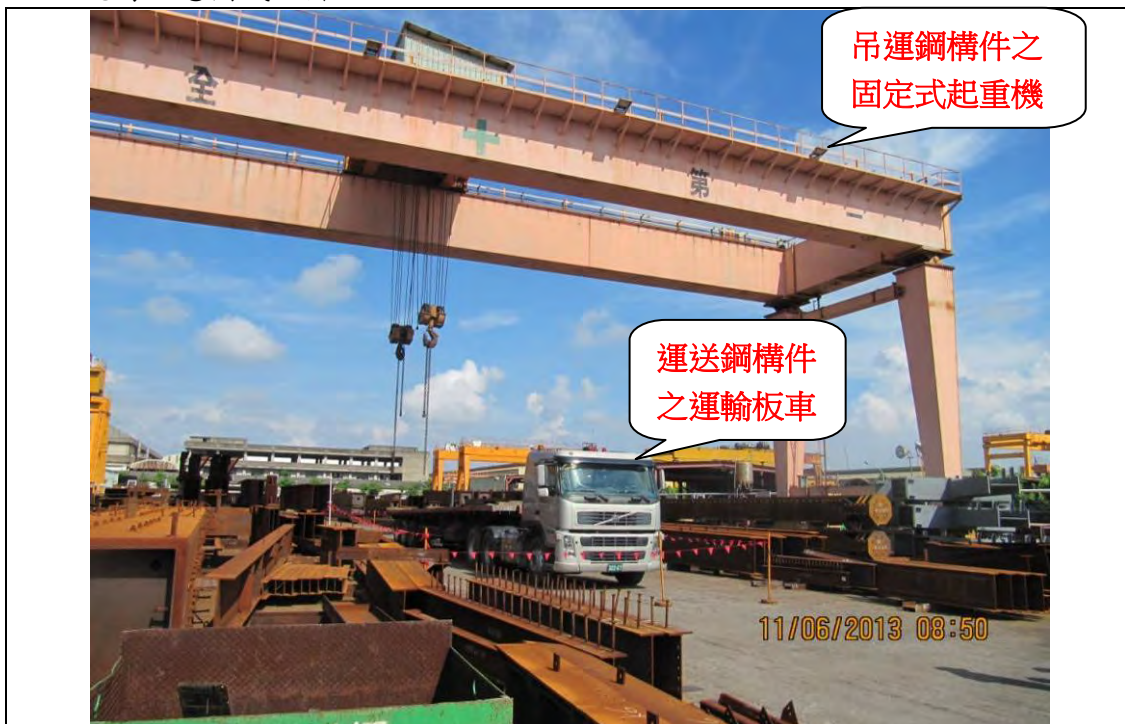
說明 照片 1： 肇災現場鋼構件成品儲放區全景。
