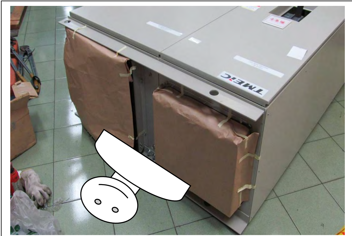
說明 3 災害發生時之模擬狀況，罹災者胸部被倒塌之配電盤壓住。
