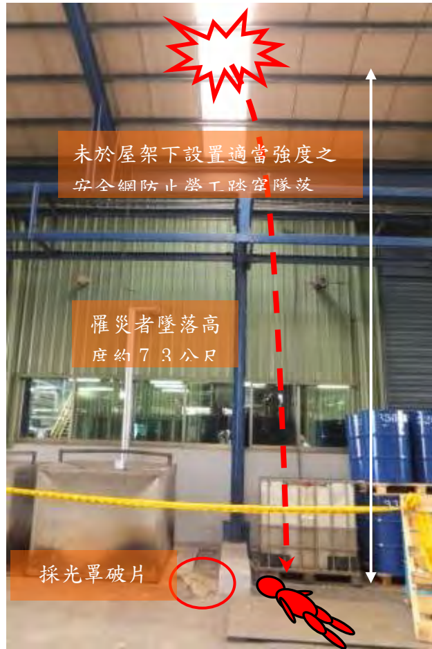
說明五 罹災者踏穿採光罩墜落點距地高度約 7.3 公尺
