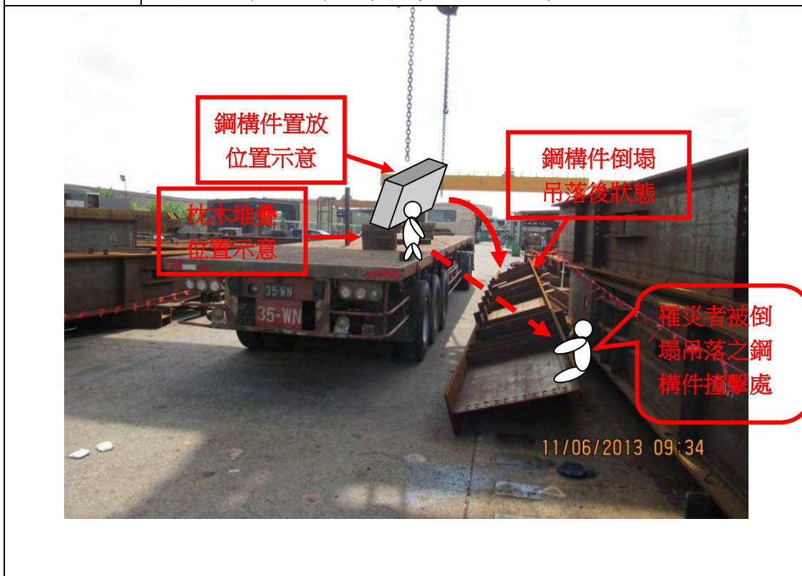
說明 照片 2： 運輸板車頭尾端各置一枕木組高度 40 公分及罹災被鋼構件壓傷處示意。
