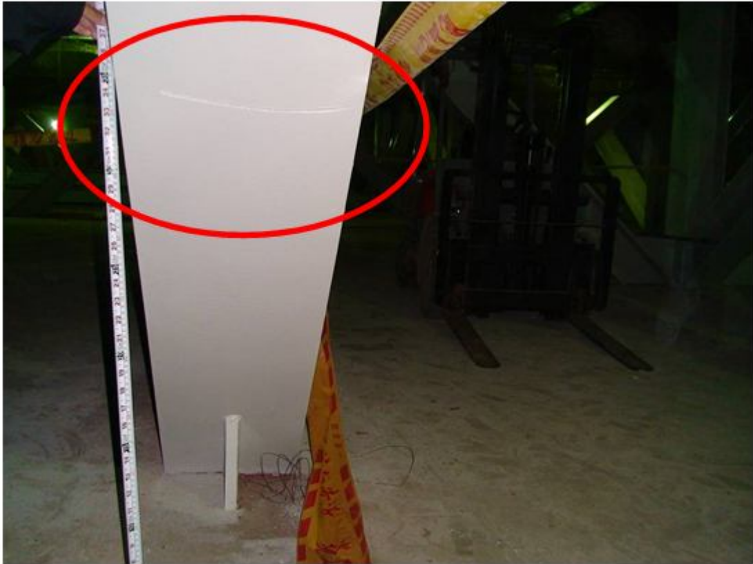
圖 2 罹災者撞擊之鋼樑斜撐
