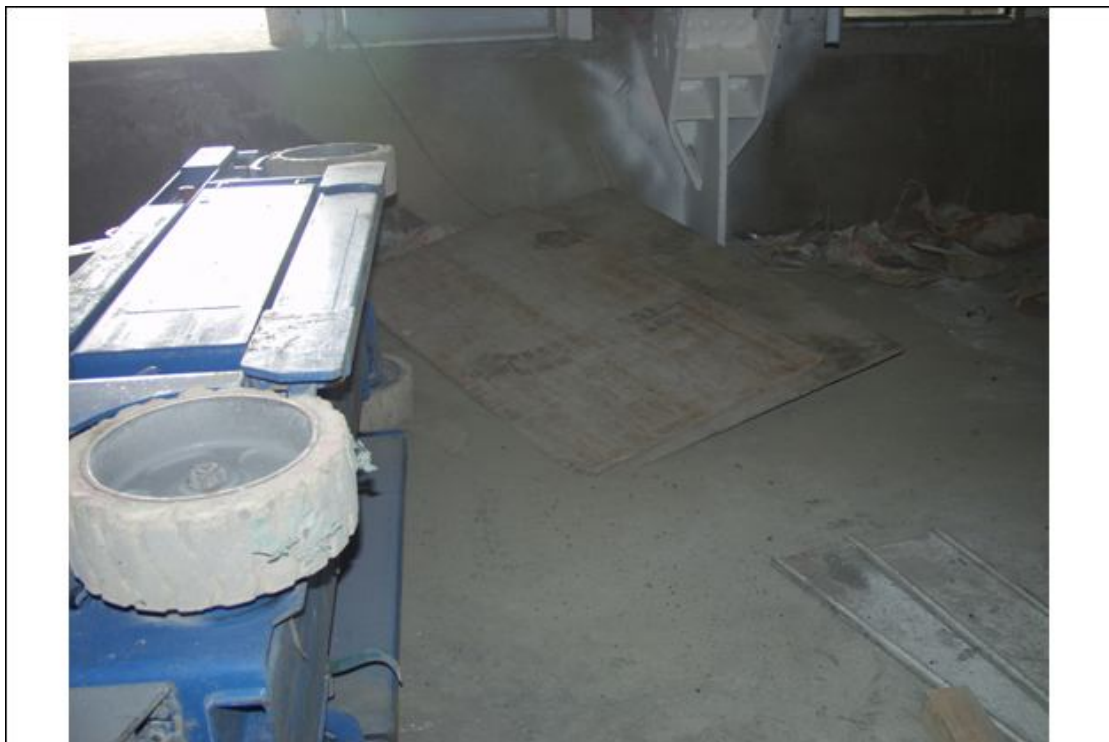
說明 高空工作車下方作業環境 (木板之斜度約 8.52)
