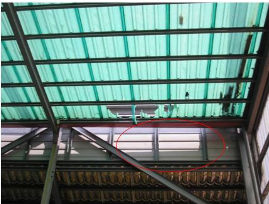
照片 2：廠房屋頂採光罩處之開口
