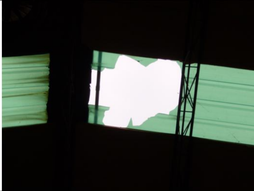
說明二 踏穿之塑膠浪板處破裂孔。
