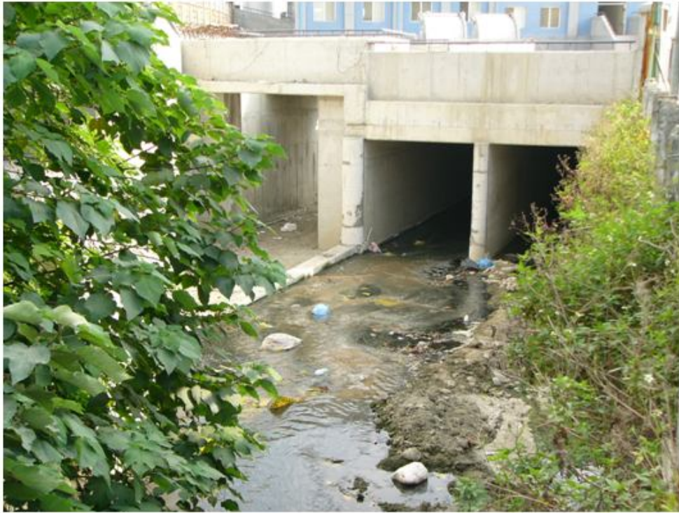
說明 相片 1，OO 鎮 OO 路旁重力排水渠道進入排水箱涵處，左側水道即為新建抽水站工程之前池入口。
