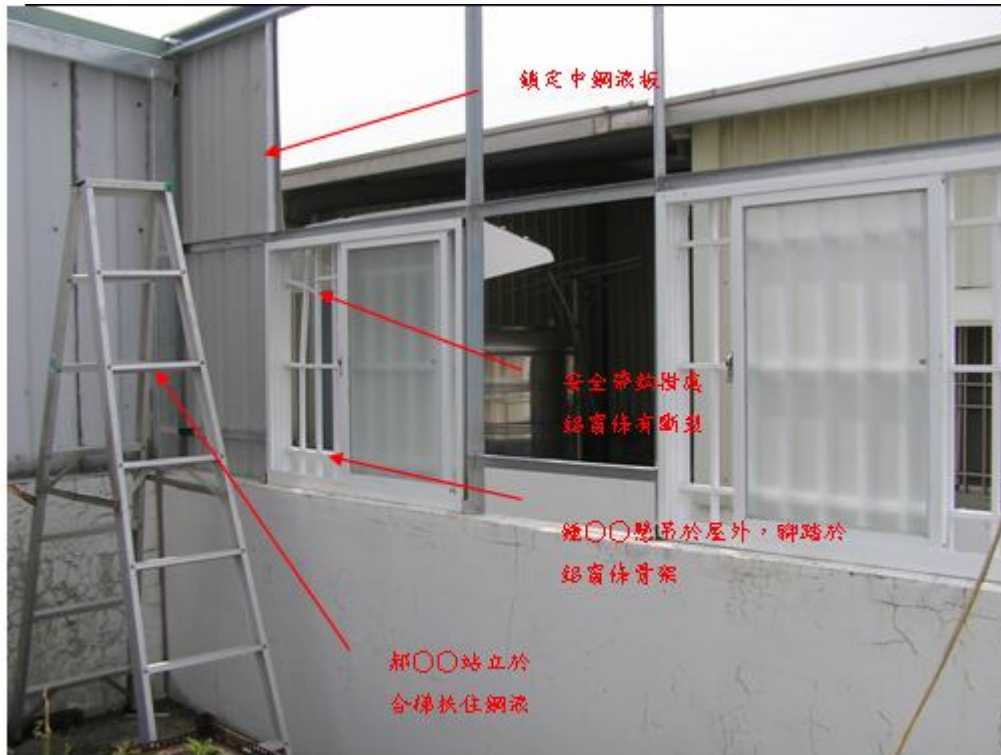
照片三：罹災者當日懸吊於屋外鎖定鋼浪板，郝○○站立合梯扶住鋼浪板。
