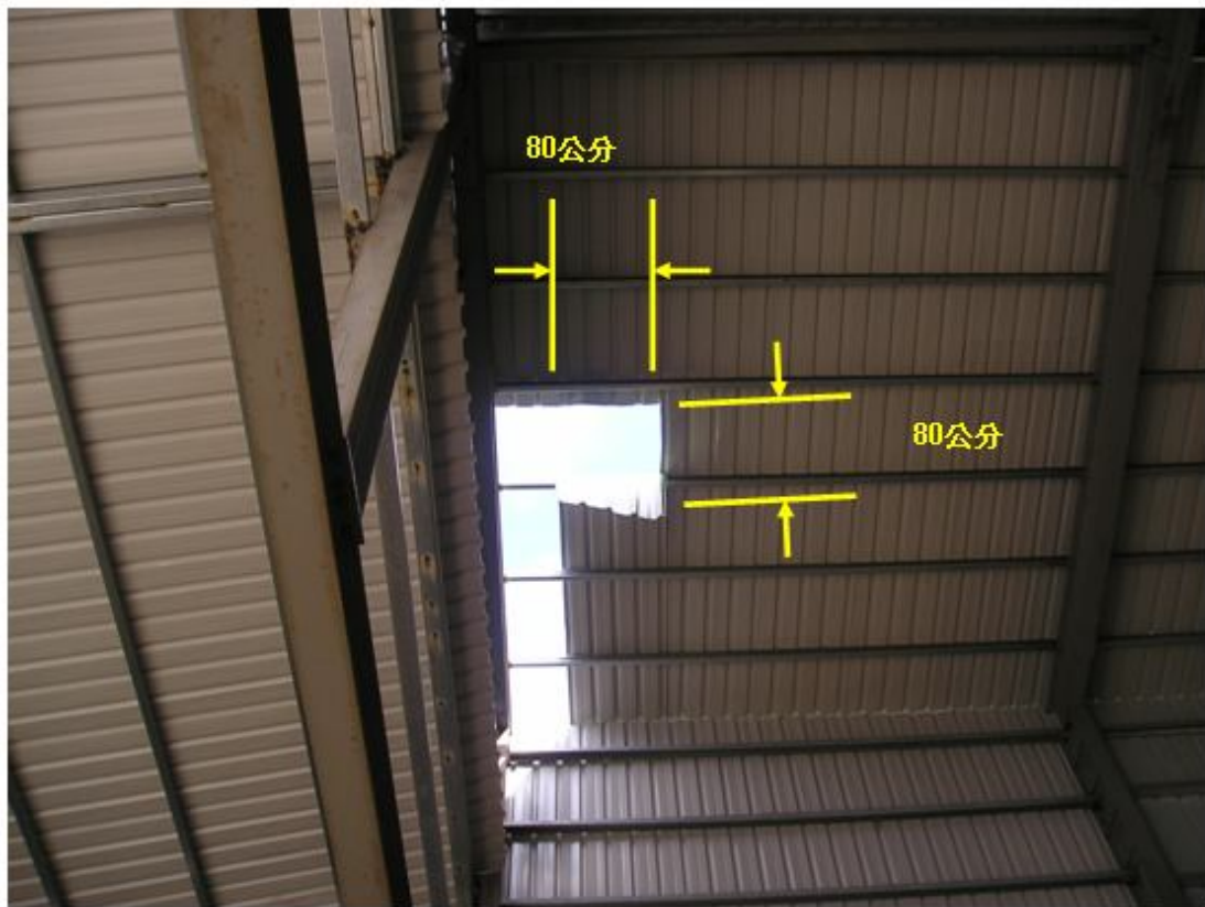
照片：踏彎之波浪板長約 80 公分、寬約 80 公分
