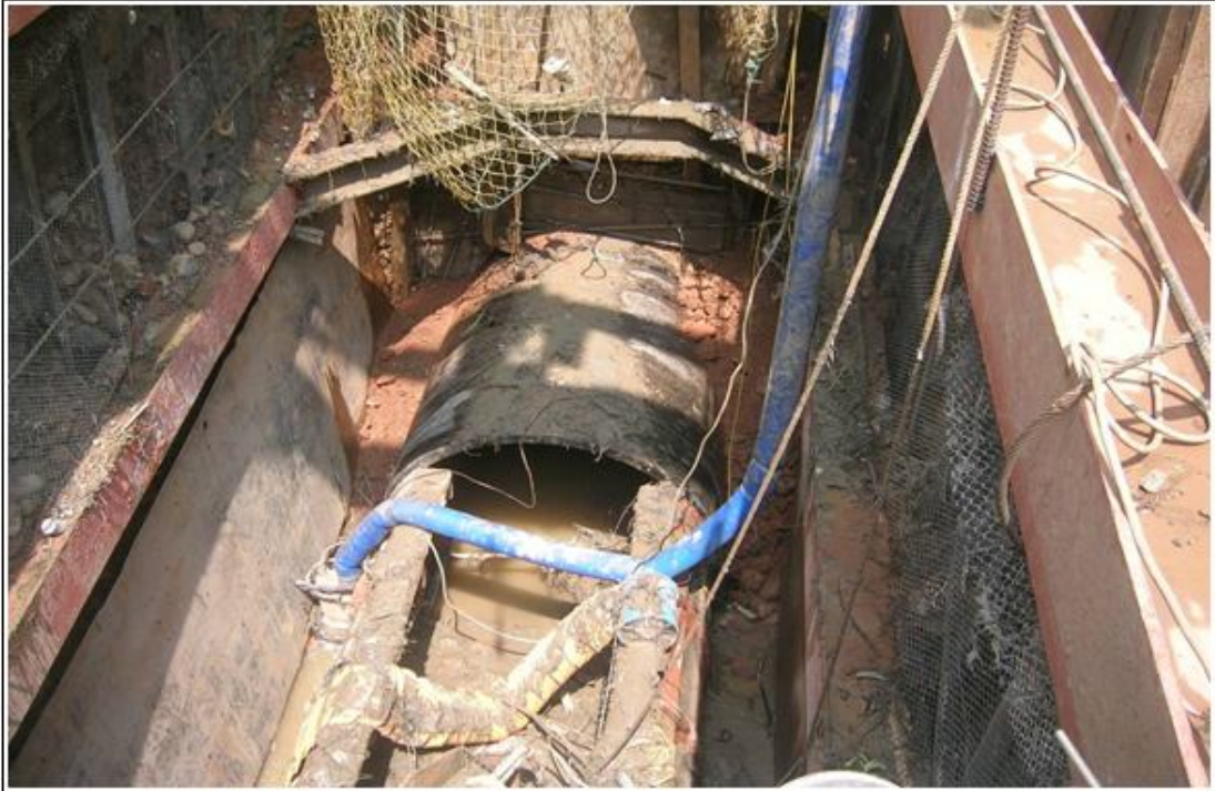
說明 附照 1 推進井內於災害發生前正施作第 1 支石墨鑄鐵管(DIP 管)
