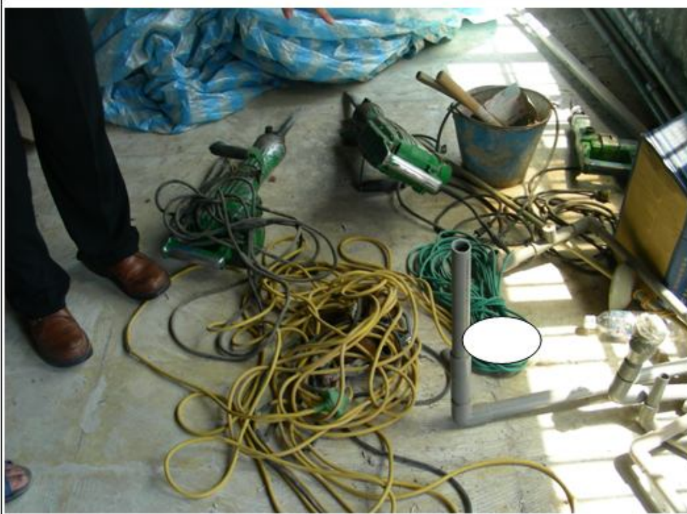
照片三 施工所用之電動破碎機。
