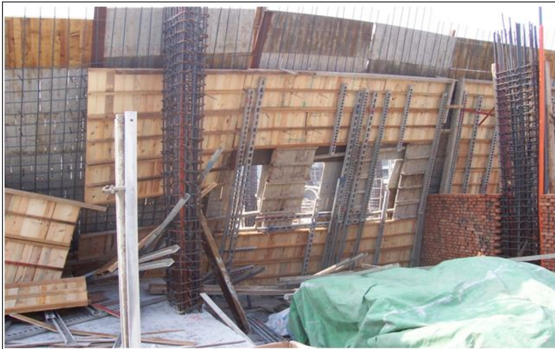
照片：北棟南向內側牆模也已進行至插螺桿之階段
