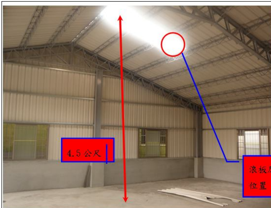
照片二 罹災者從屋頂浪板處墜落至地面，高度約為 4.5 公尺
