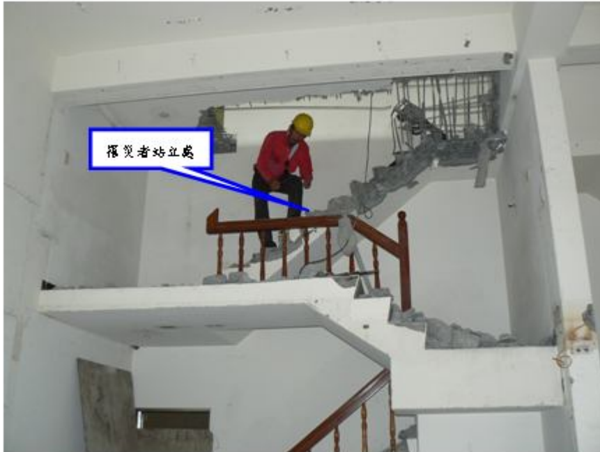
照片 1：罹災者勞工甲在工地現場進行樓梯拆除作業時之站立位置。
