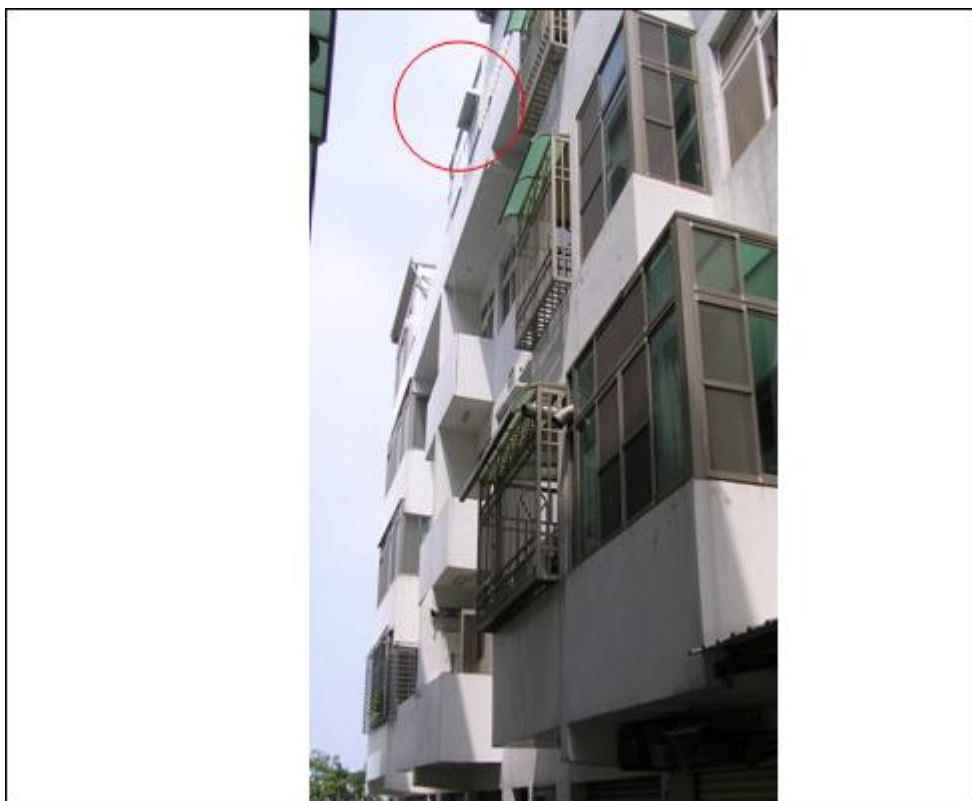
照片一：台南縣新化鎮○○樓頂搭建鐵層工程工地。
