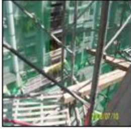
說明：外牆施工架開口處
