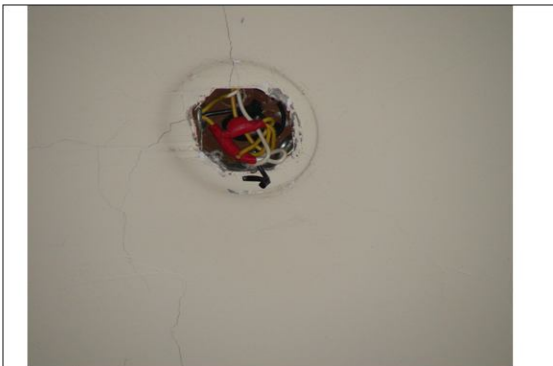
照片一 同事○○○至施工架將頭頂電燈鐵桿切掉並將電線包覆
