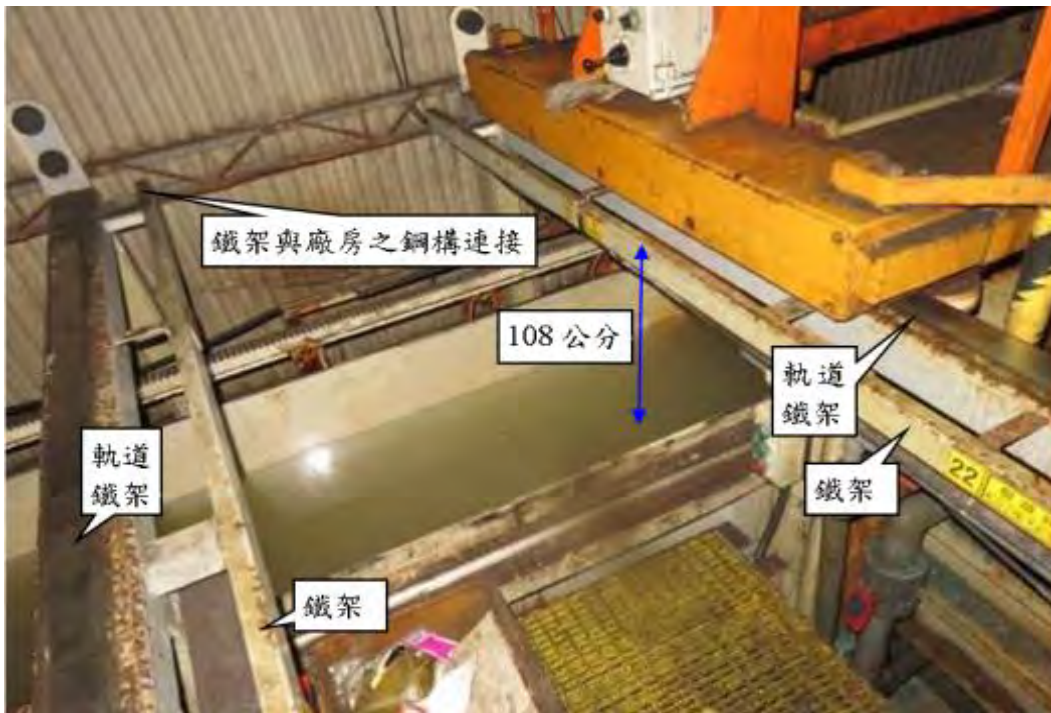
說明七 水洗槽上方有一滾電天車軌道旁之鐵架，其作用係防止人員接觸滾電天車軌道並供步道扶手用，該鐵架距水洗槽底高度 108 公分，鐵架與廠房之鋼構連接。
