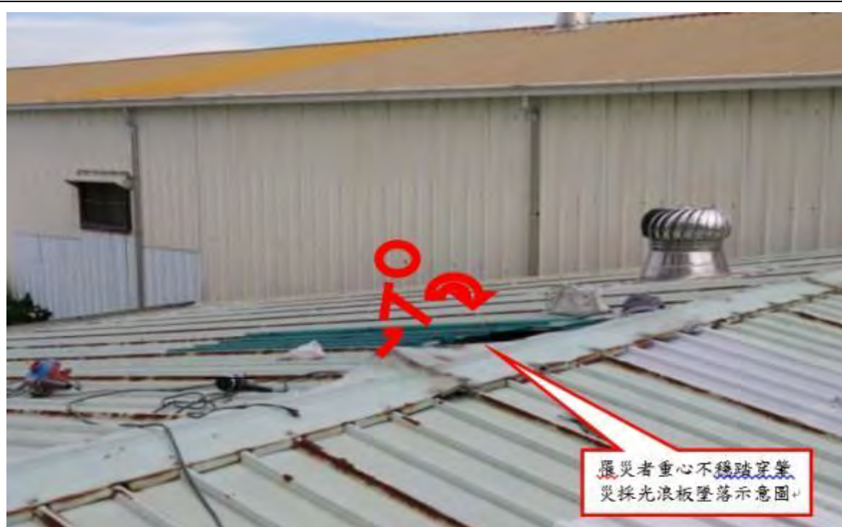
說明二 罹災者整個人踏穿肇災塑膠材質採光浪板墜落示意圖。
