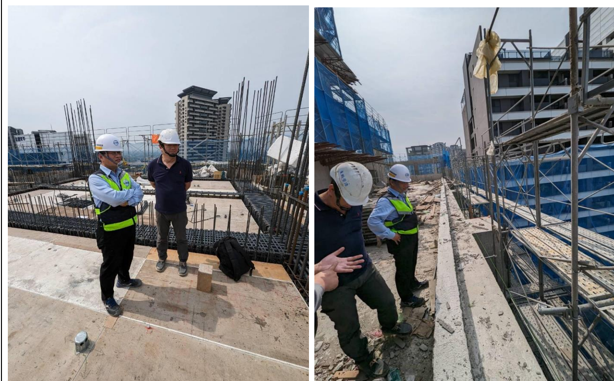
本署北區職業安全衛生中心曹常成主任率檢查員前往桃園市某丁類建築工程實施勞動檢查。
