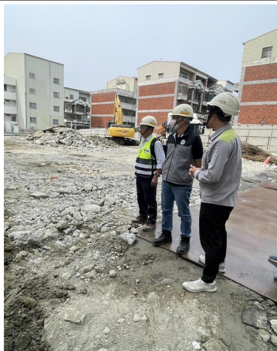
本署南區職業安全衛生中心陳明財簡任技正率檢查員前往臺南市某建築工程實施勞動檢查。
