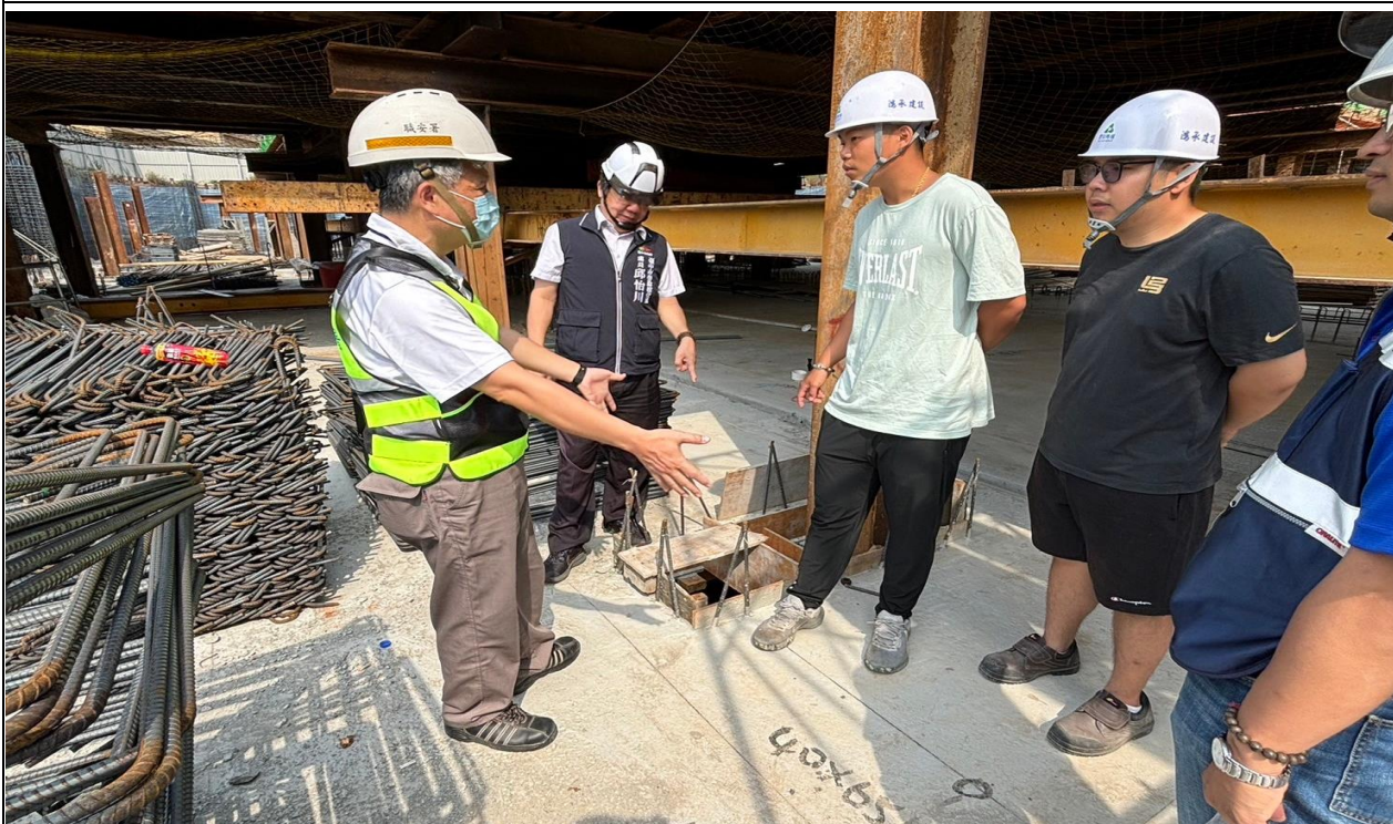
本署職業安全組林志展副組長與臺中市政府勞動檢查處邱怡川處長率檢查員前往臺中市某建築工程實施勞動檢查。
