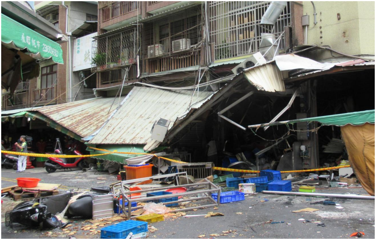
附照 1 說明：氣爆後之災害現場。(1樓屋外)。
