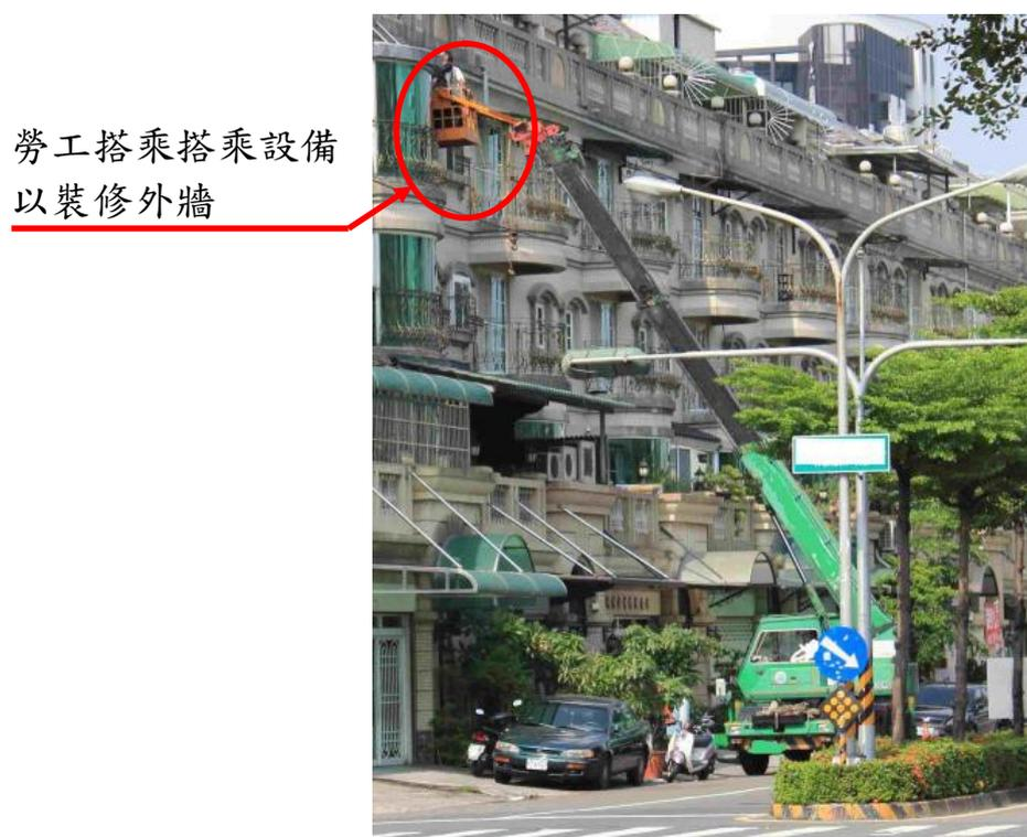
圖 2 起重機吊掛搭乘設備作業
