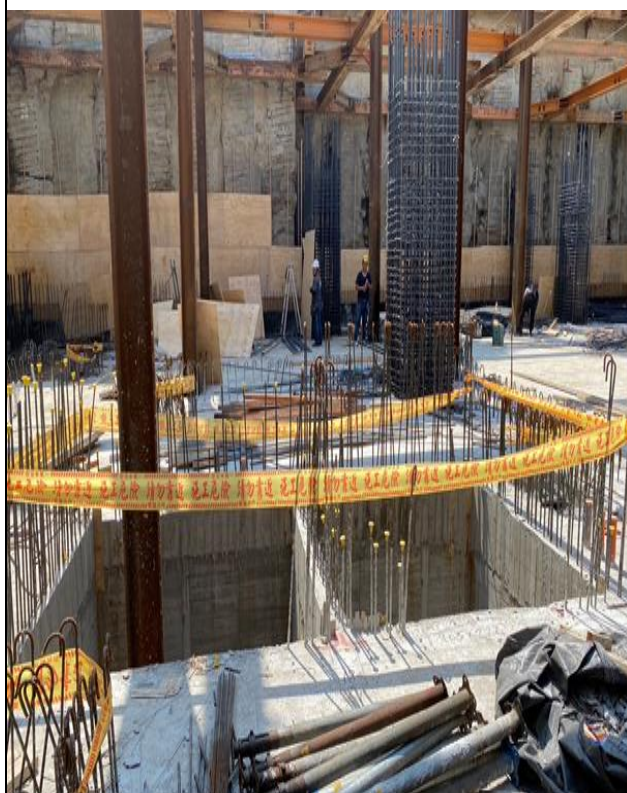
臺中市某建築工地開口未設置護欄；另樓梯未設置扶手。
