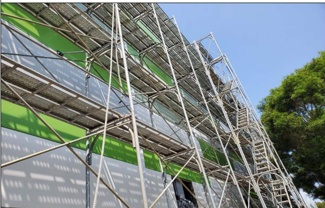
苗栗縣某廠房工程施工架內側交叉拉桿及下拉桿拆除。
