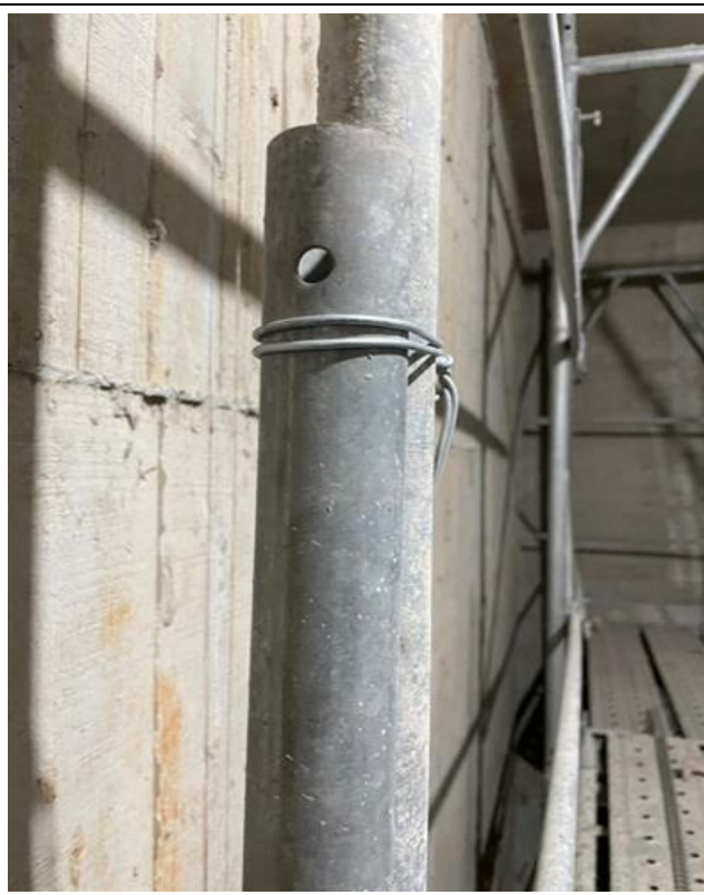
新北市某建築工地施工架之構件，未以金屬附屬配件固定連結。
