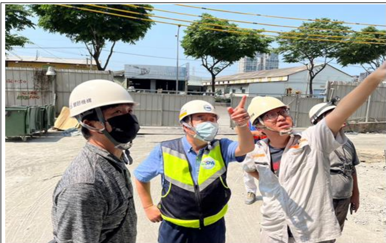
本署中區職業安全衛生中心李文進主任率檢查員前往臺中市某建築工地實施勞動檢查。
