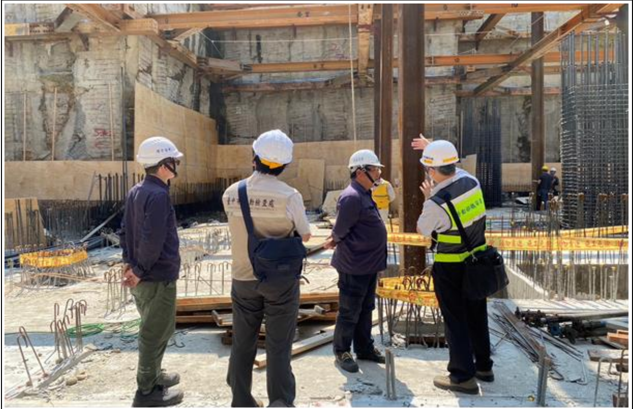
本署朱文勇組長及臺中市勞動檢查處許瀚丞副處長率檢查員前往臺中市某建築工地實施勞動檢查。
