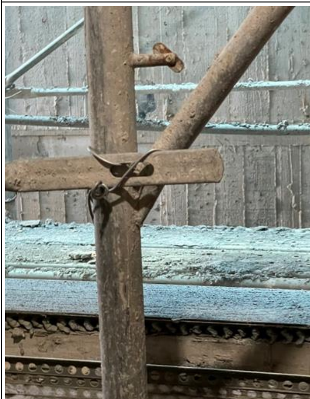
新北市某建築工地施工架之構件，未以金屬附屬配件固定連結。
