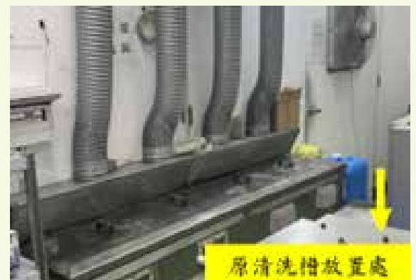
圖十六、設備擺放位置更動 本次作業環境監測現場，清洗槽改至化學槽體內操作，局部抽氣設備改為四道抽氣管路。設備擺放位置與個案急診當日之作業環境不同。
