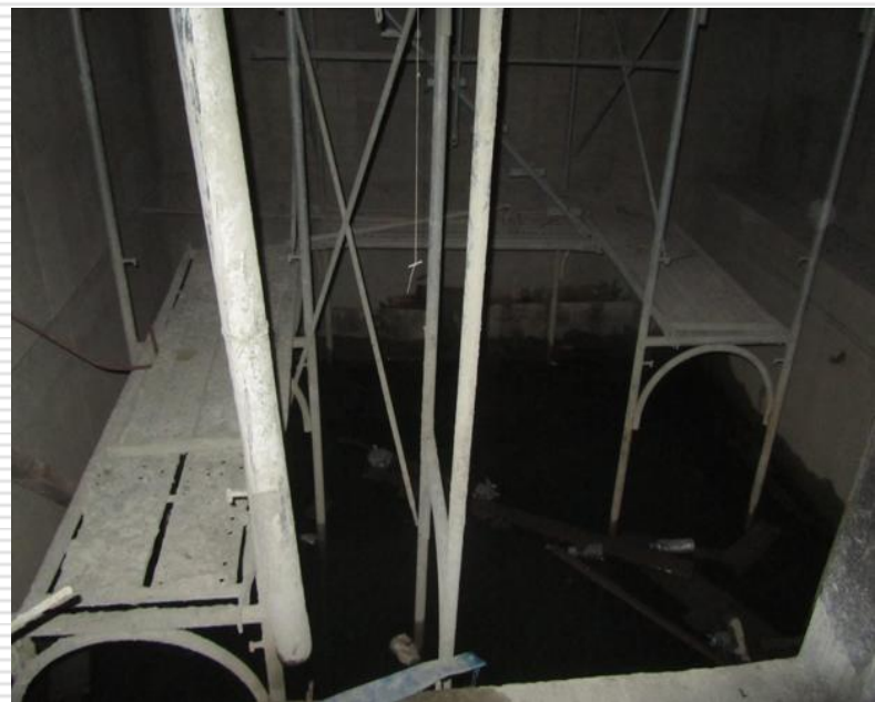
地下1樓 電梯機坑 施工架
