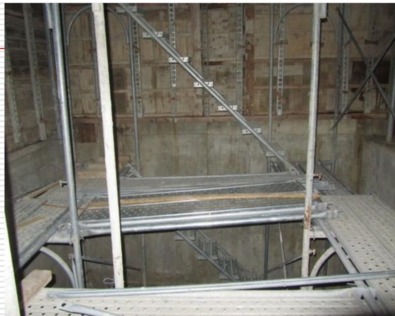
模板支撐 下方施工架50 公尺高
