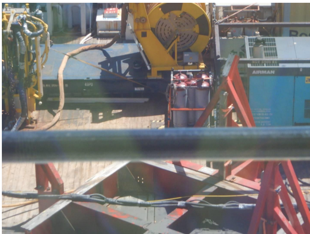
工作船甲板之高壓氣體鋼瓶貯存場所未有遮陽措施
