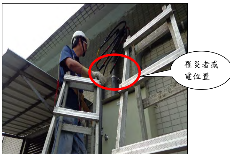
現場模擬罹災者作業情形
