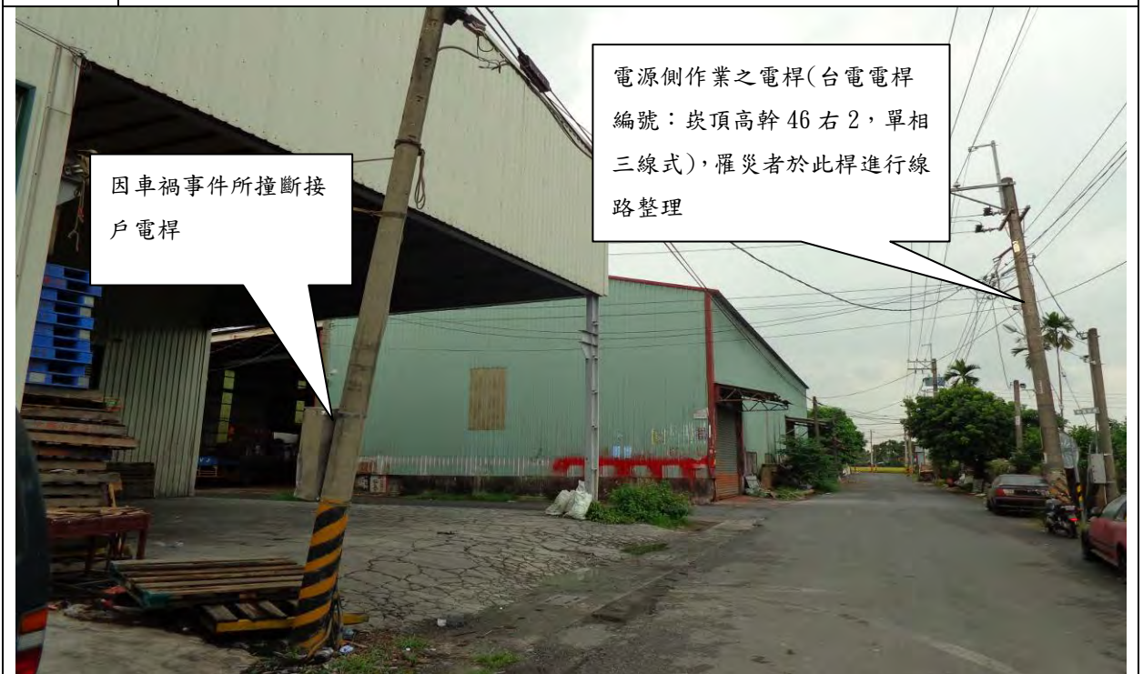
照片 2 進行因車禍事件造成損壞之接戶電線桿換新及電桿(電源側)線路整理與電桿脫落之絕緣礙子修護固定處理等作業之相對位置
