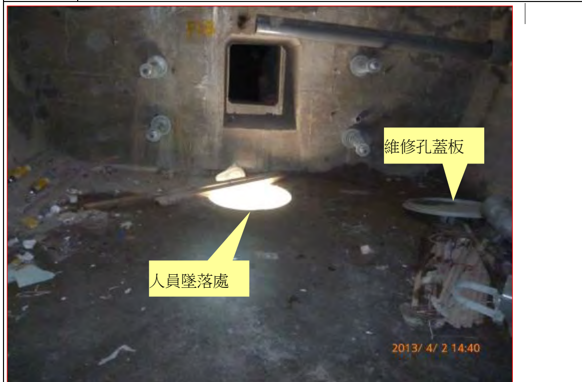
說明 當天工作中橋梁箱室內部照片
