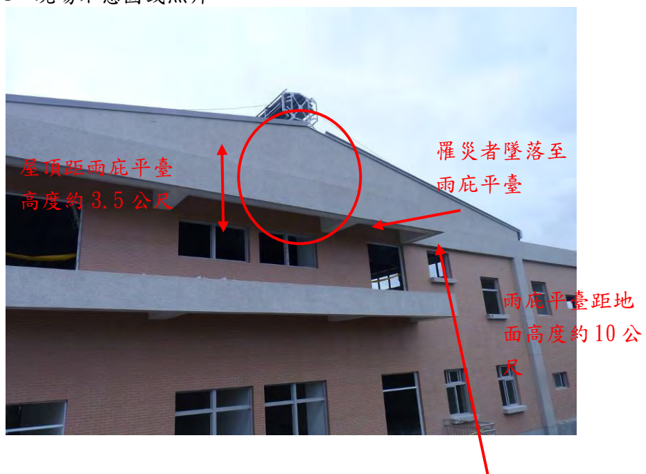
照片：罹災者災害發生時作業位置，位於新建廠房屋頂；罹災者自紅圈處移動梯（已移除）上墜落至雨庇
