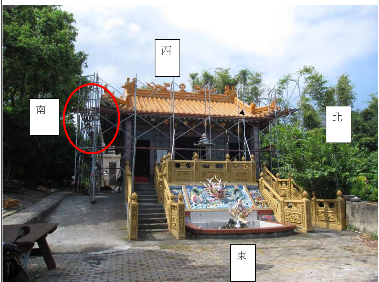
照片 災害發生於○○縣○○鄉「○○寺屋頂琉璃瓦鋪設工程」之工地
