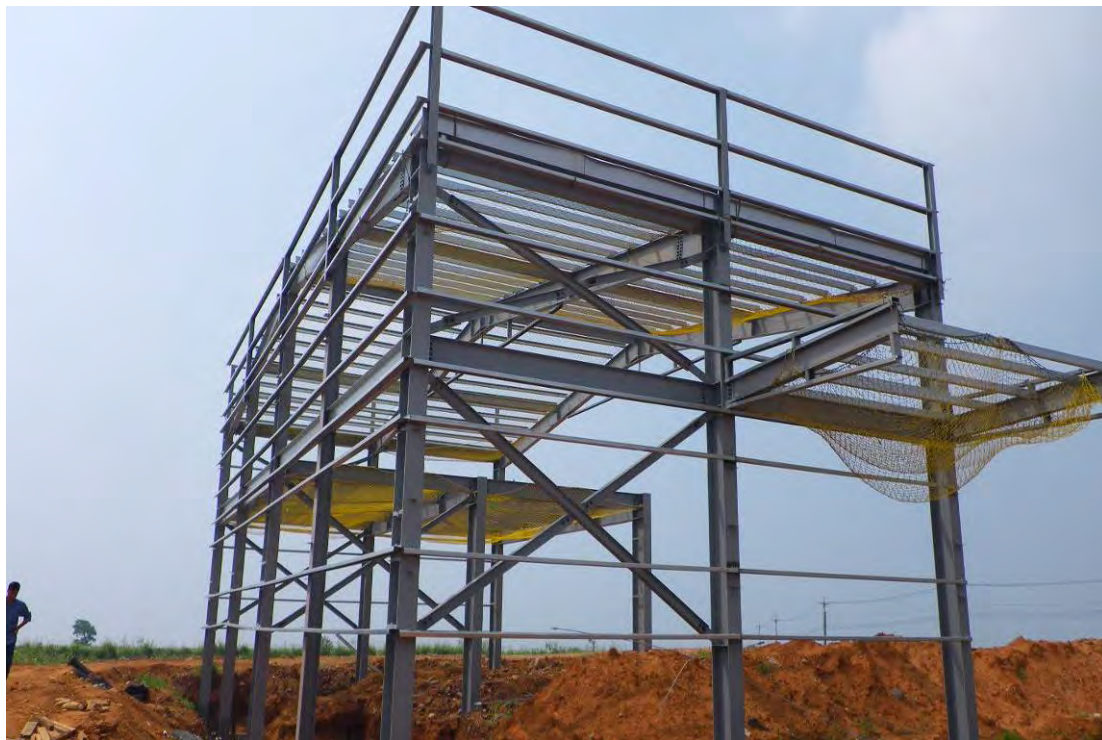
照片 1：台灣○○有限公司「倉庫之廠房鋼構工程（一次工程）」
