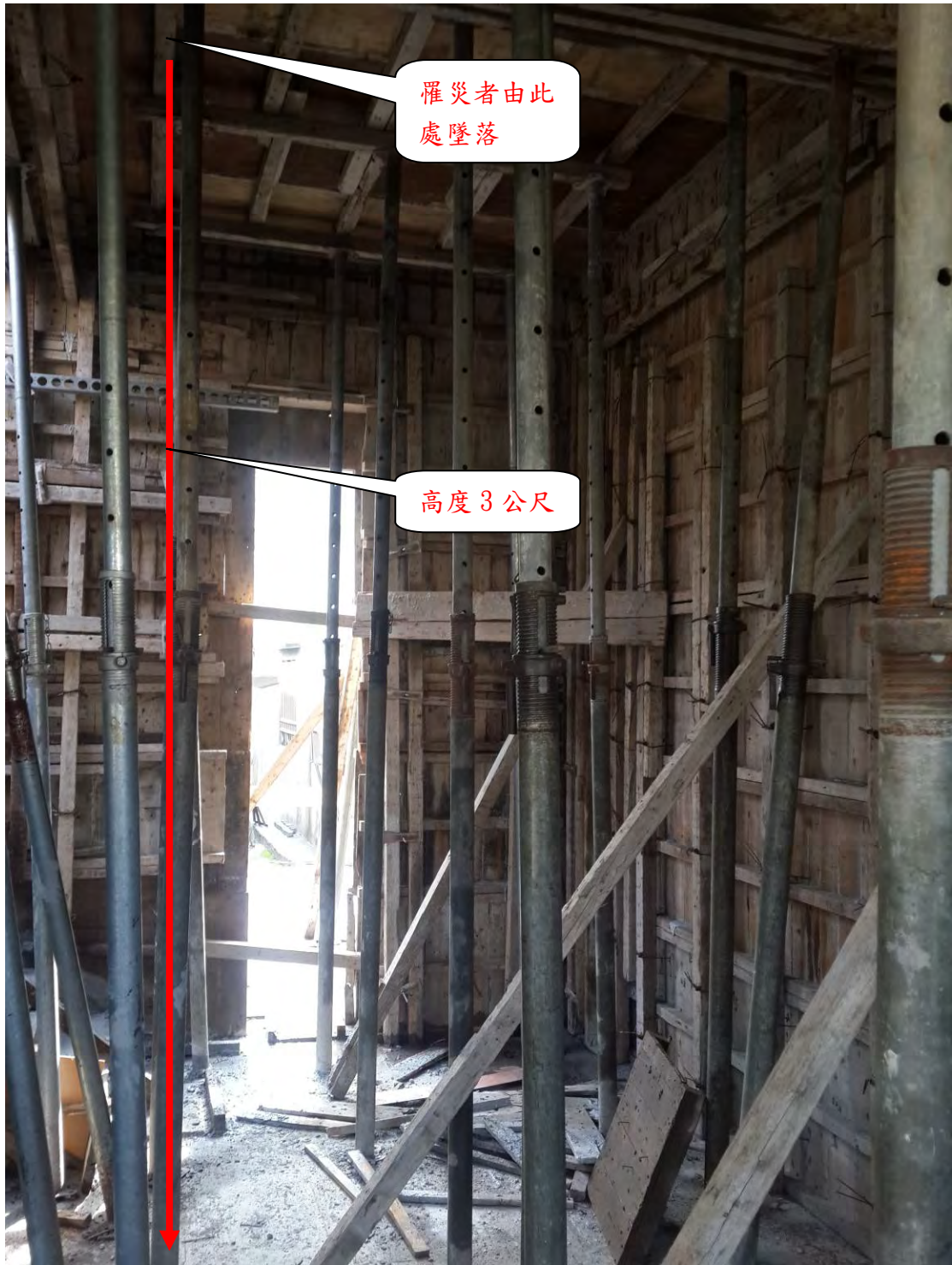
照片 3、1 樓頂板距地面高度 3 公尺
