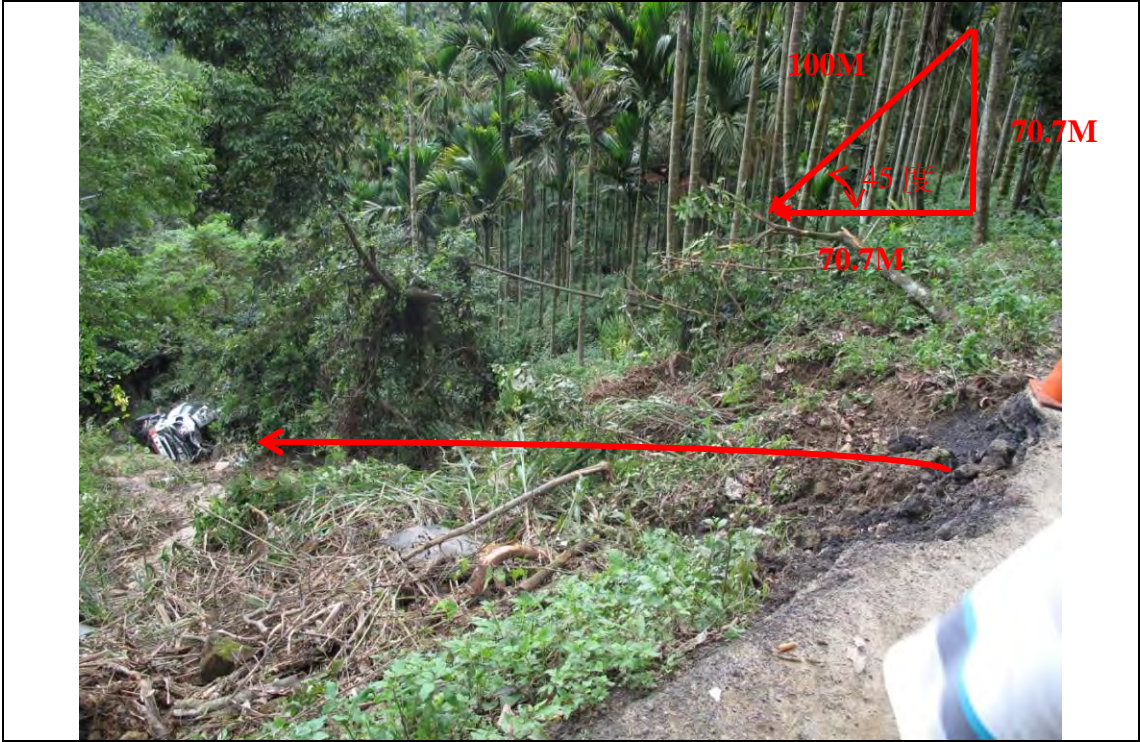
照片 2 墜落之坡崁高度約 70.7M，斜度約 45 度
