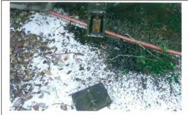
照片 左側外伸撐腳座斷裂分離 (臺灣桃園地檢署提供)
