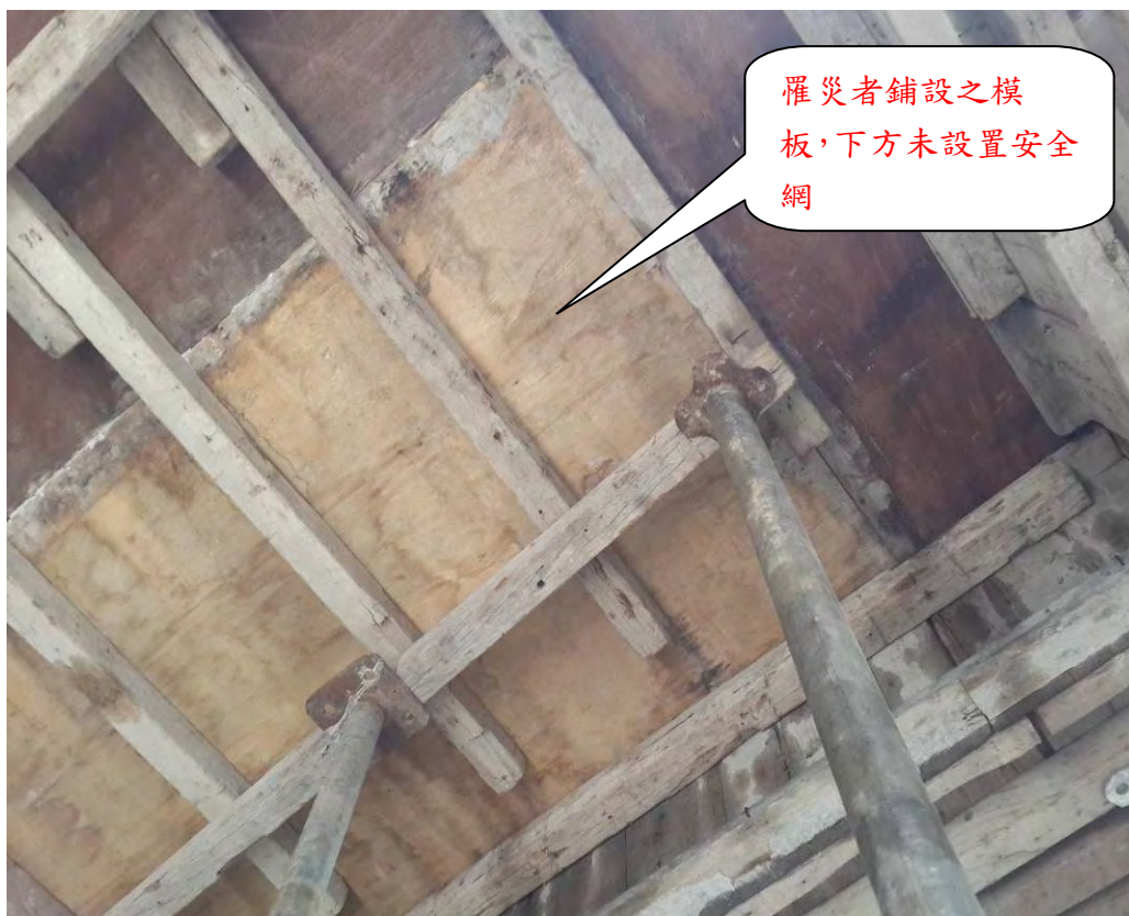
照片 2、罹災者於 1 樓頂板從事模板鋪設作業（災害發生當時尚未鋪設完成）
