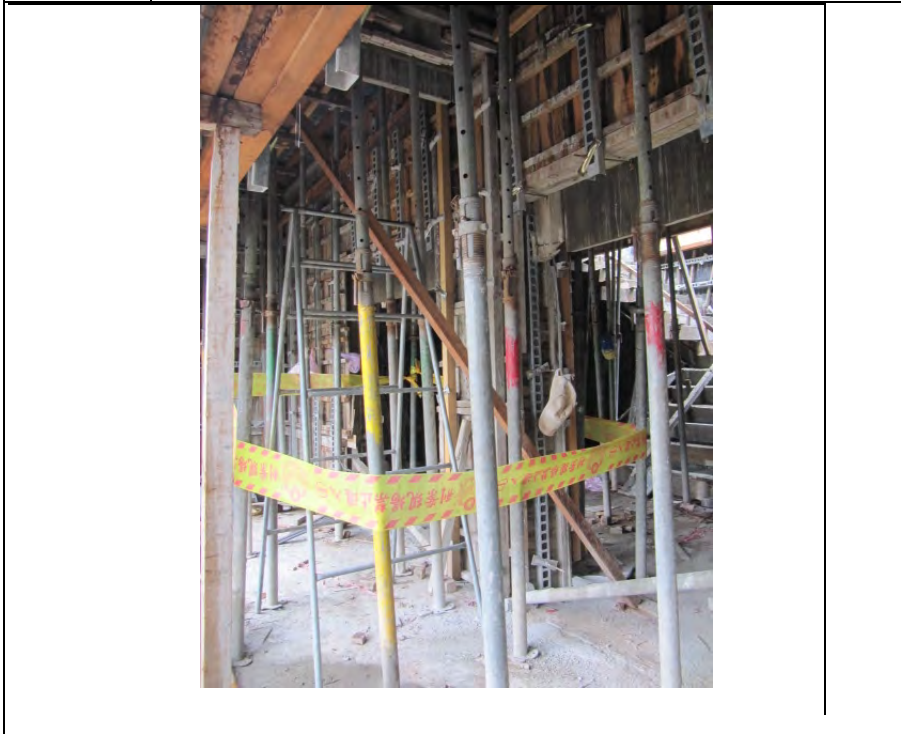
照片二 鐵製合梯高度 208 公分、寬度 101 公分、圓形橫桿直徑 2.1 公分。
