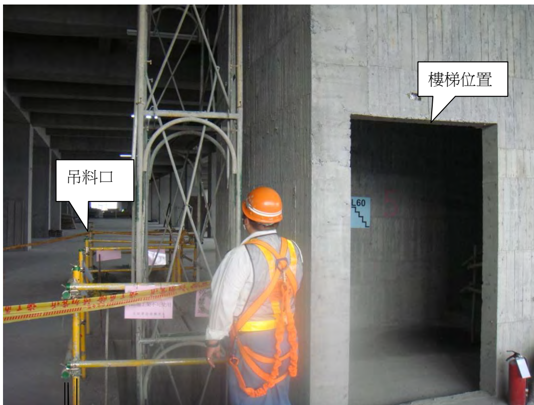
拆模完成後(發生災害時)已完成之樓梯及吊料口位置
