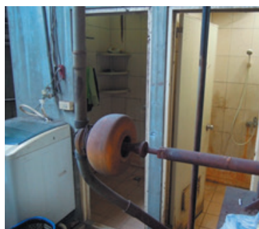
B 廠之洗衣沐浴設備
