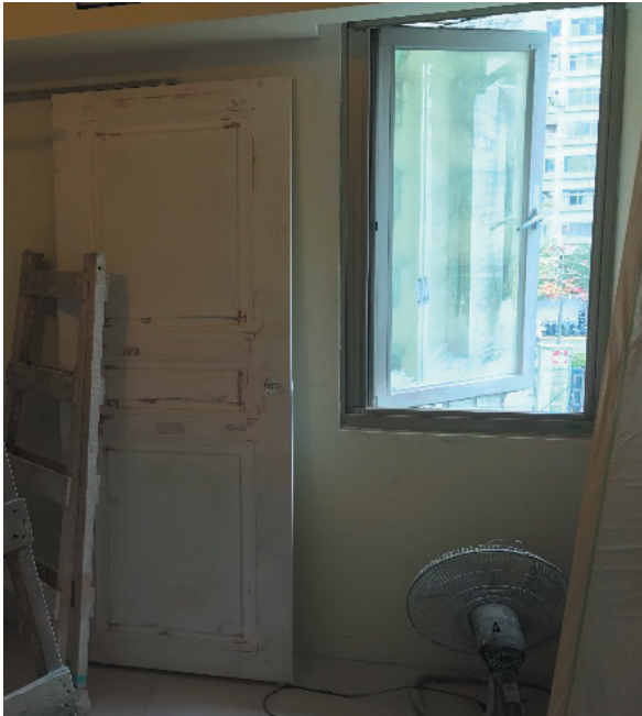
當日廠訪為民宅內部翻新裝修 - 木板上漆，施工房間僅開窗（若附近住戶抗議異味則不開窗），因現場粉塵瀰漫，故無開風扇，避免造成粉塵二次飛揚。
