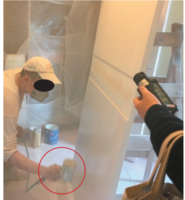
以右手持噴槍進行噴漆，過程配戴一般活性碳口罩，現場可見油漆與稀釋劑（甲苯或香蕉水）使用後未蓋回蓋子（紅色圈圈處），作業過程測得 VOC 最高濃度為 496 ppm。
