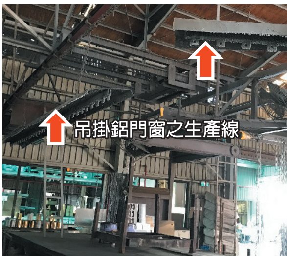
為吊掛鋁門窗條的生產線，因機器於現場訪視前一日故障，故現場訪視當日並未運作。
