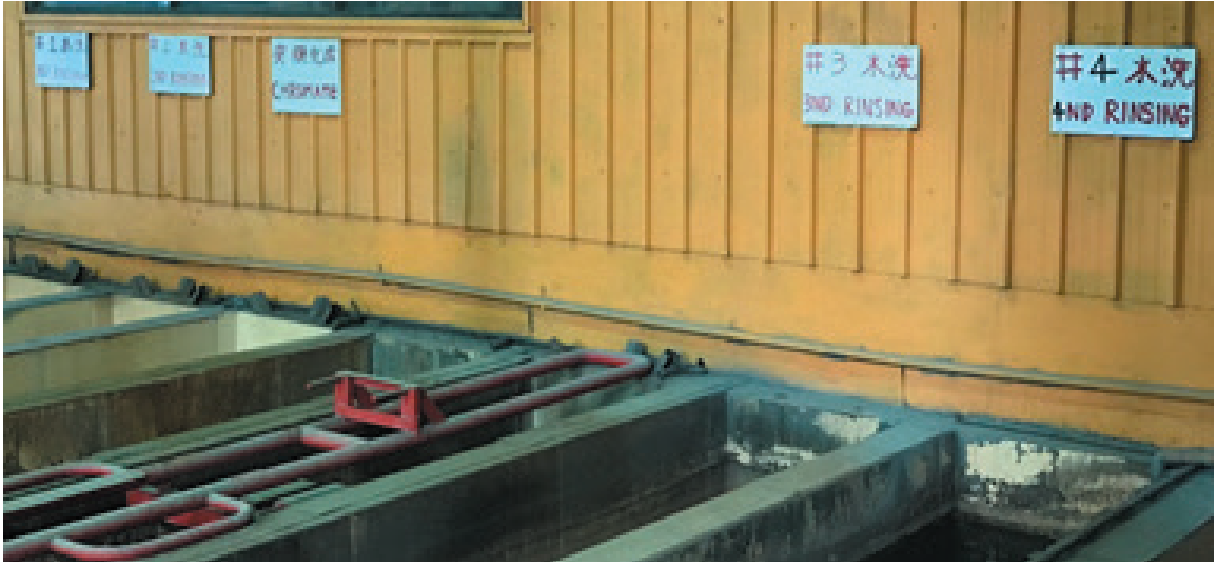
浸洗區屬半開放式，由圖中可見 1、2、4、5 槽皆為水洗槽，3 槽為皮膜化成 (皮膜劑 CAS.1569013)。
