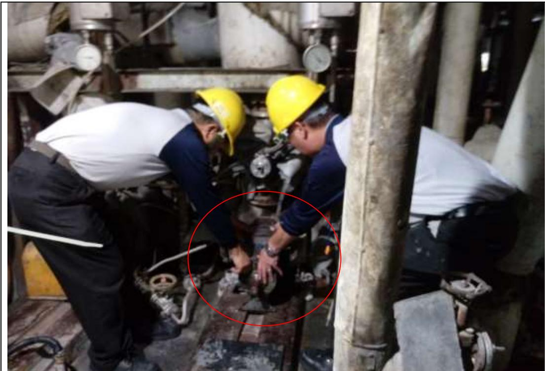
說明： 108 年 8 月 0 日 0 時許洪 00、吳 00 於 00 廠二樓進行泵浦拆清作業(模擬照片)。
