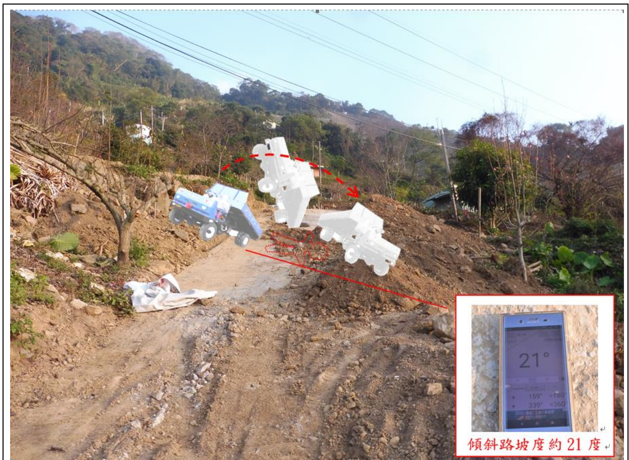
附照：農路工程，水泥傾斜路坡度約 21 度。
