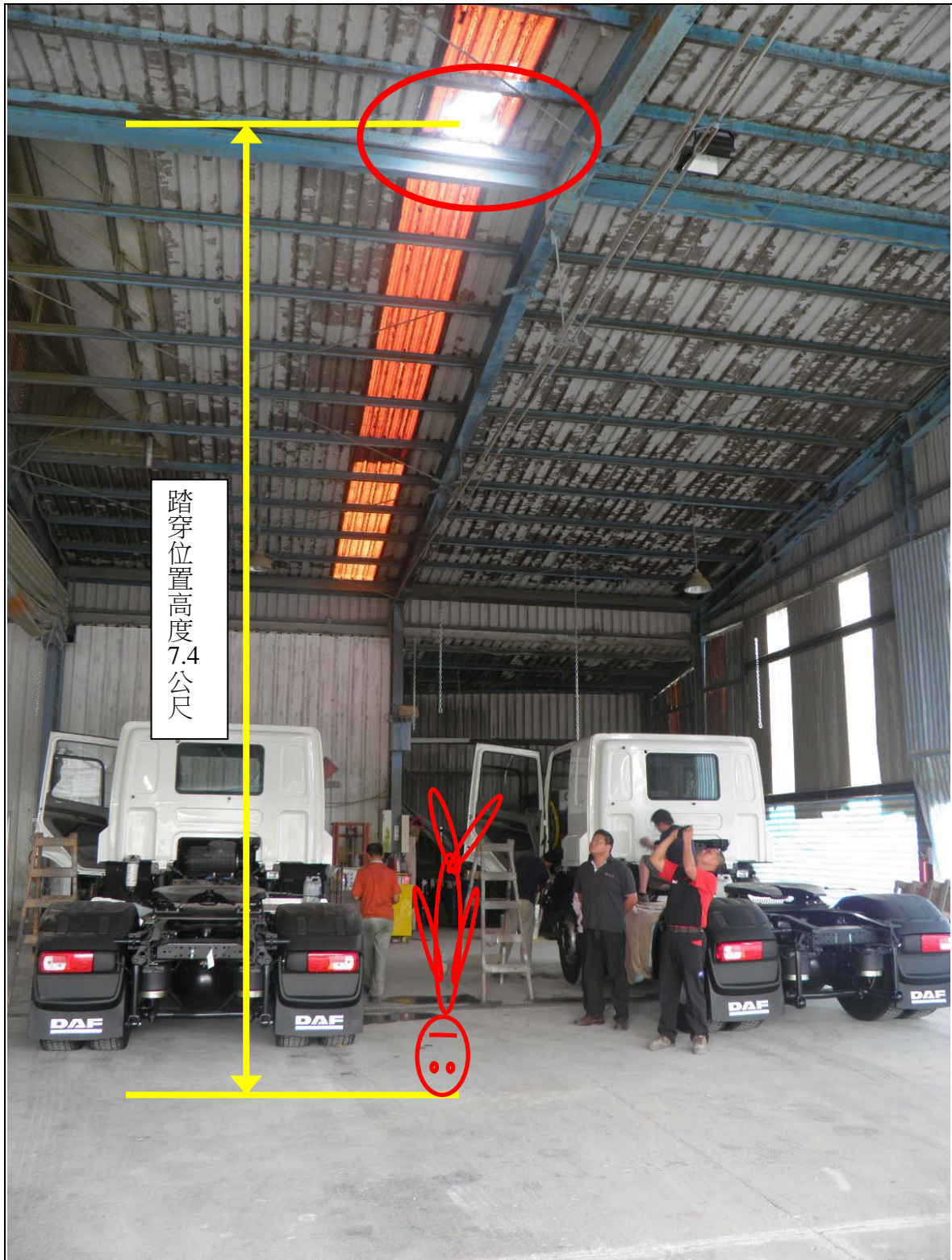
照片：罹災者踏穿採光罩墜落至地面，照片中紅線標示為屋頂踏穿位置與罹災者墜落位置。
