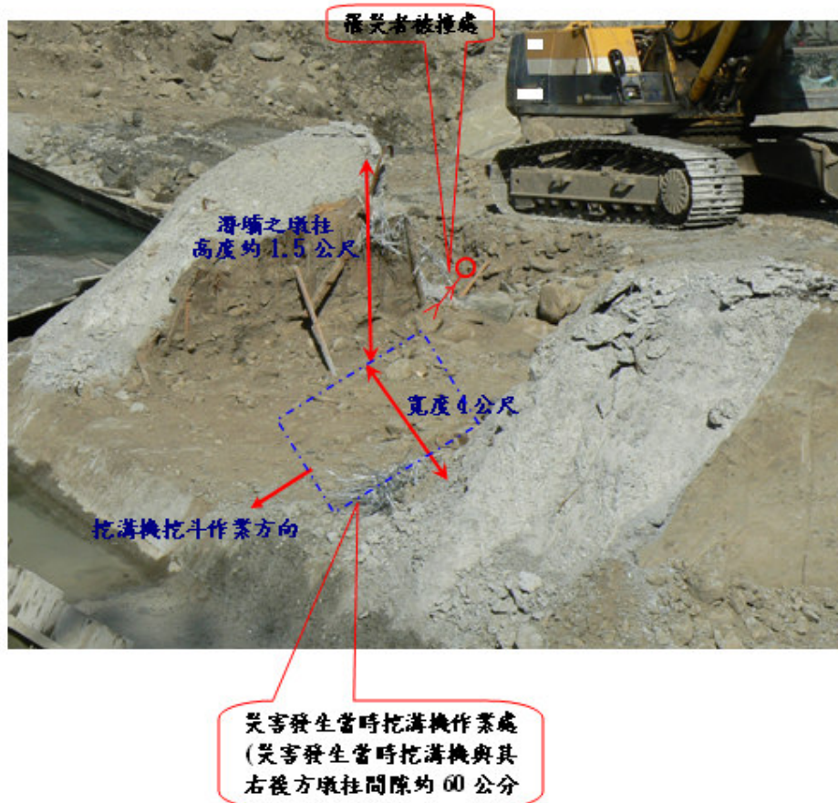
照片 1：罹災者在挖溝機右後側與墩柱間，遭正在作業中之挖溝機後側突出引擎室外殼撞擊。
