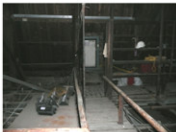
說明：3樓閣樓貓道。
