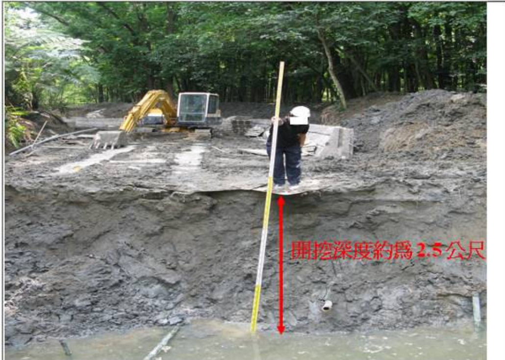
照片三 | 固床工基礎開挖深度約為 2.5 公尺
