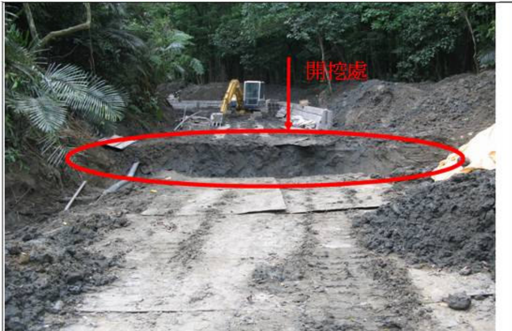
照片一 | 固床工基礎開挖處
