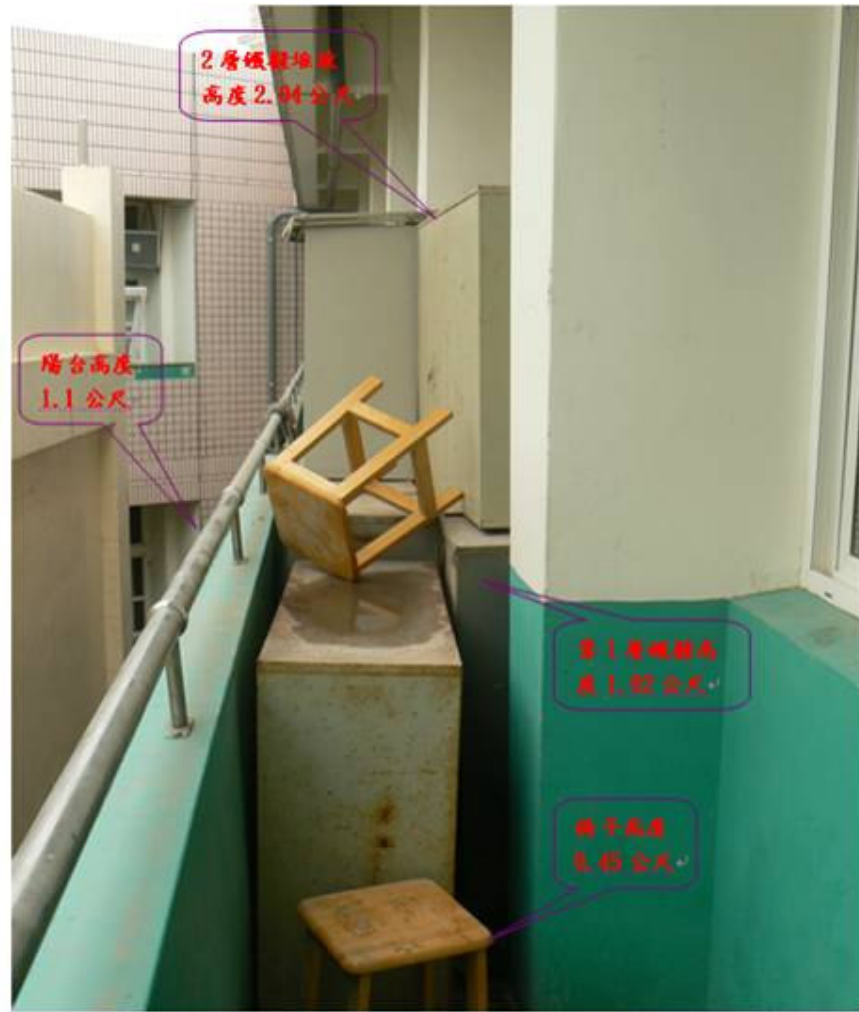
照片：罹災者在鐵櫃上作業不慎墜落地面。
