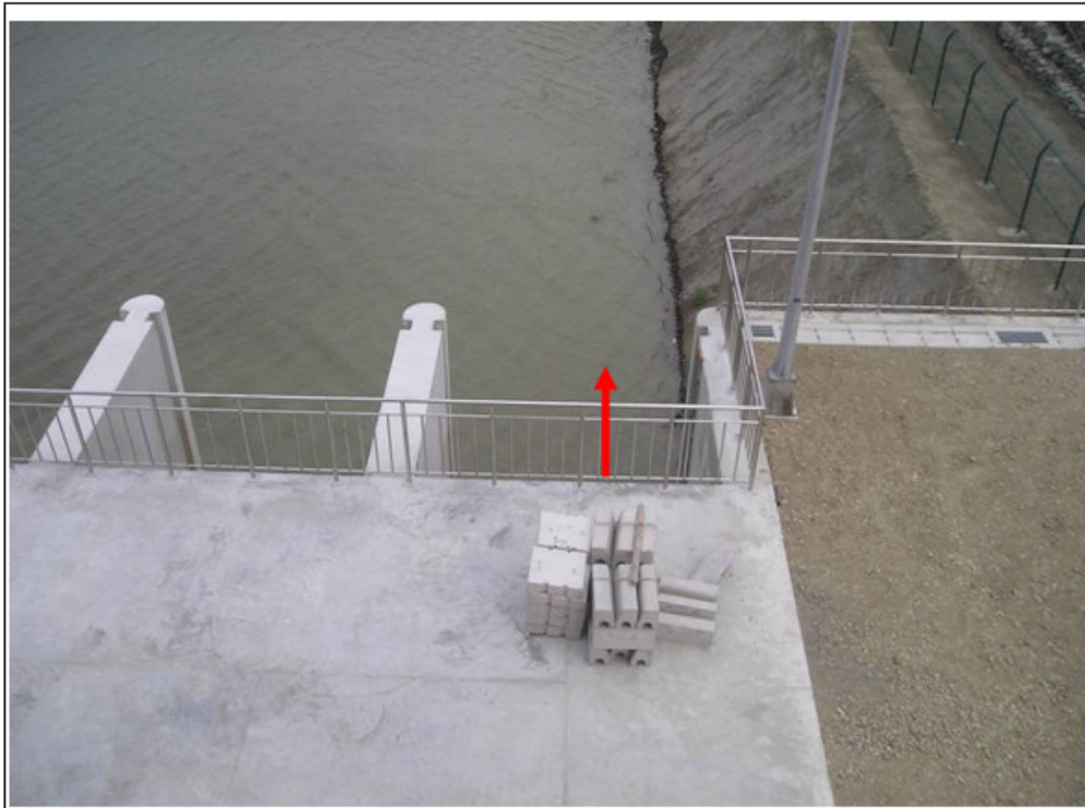
說明 附照 罹災者墜落前從事水溝蓋吊掛作業，當時正在收拾鋼索
