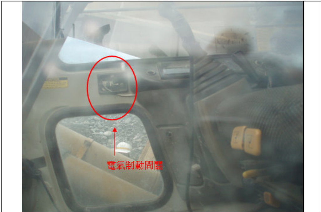
照片六 打樁機駕駛座電氣制動開關
