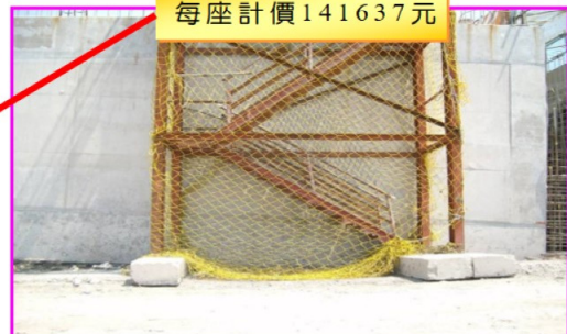
型鋼式上下設備施作照片
