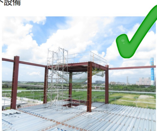
屋突已設上下設備及護欄
