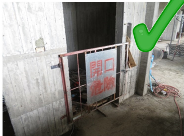
電梯口開口已設置護欄
