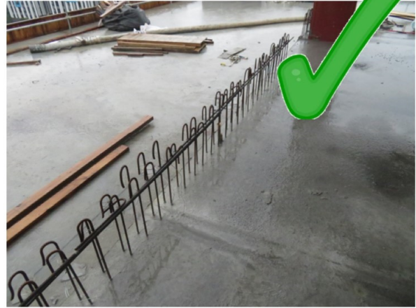
裸露鋼筋已彎曲
