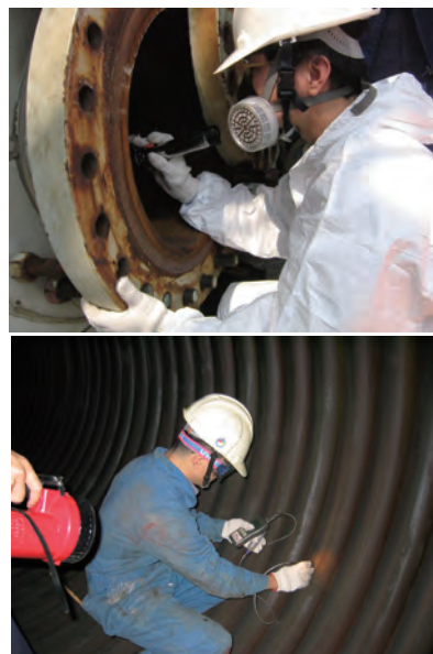
圖 3 危險性設備內部檢查實況
