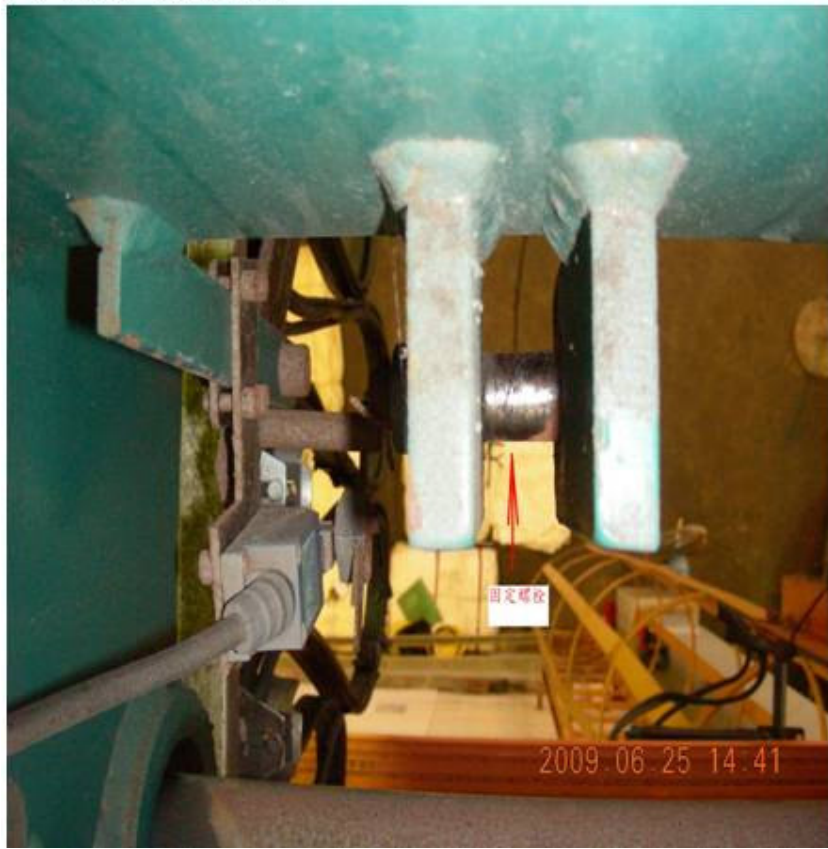
圖 2 鋼索固定端之螺柱
