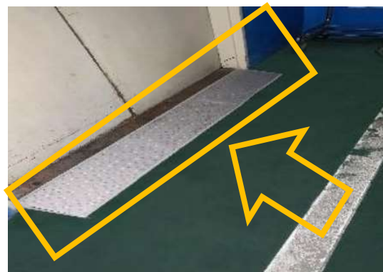
圖 2、倉庫進入醫院門檻處增設斜坡 減少人員推動貨車之阻力
