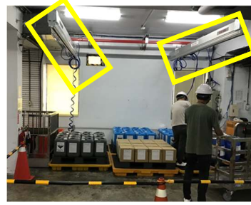
圖 2、在倉庫上方架設天車滑軌
