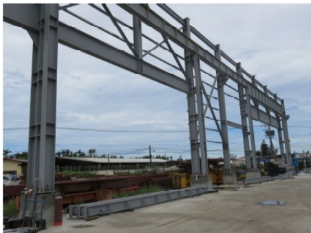
說明 照片 4： 災害發生時，現場南北面鋼構之梁柱大部分已組裝。
