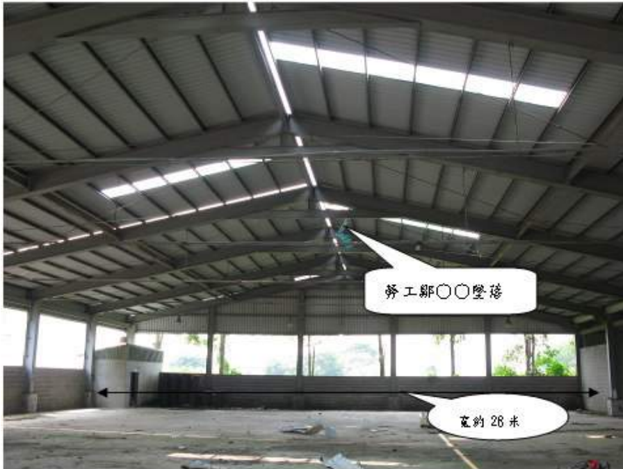
照片一： 鋼骨結構廠房，長約66米；寬約28米；斜屋頂高約7米。
