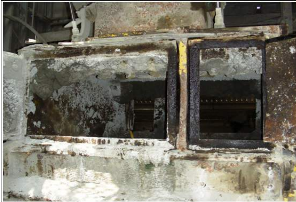
照片三 拌合機內部入口
