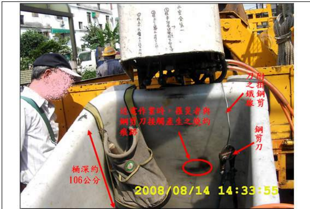
說明 2 高空工作車(昇空車)桶內感電灼傷之情形
