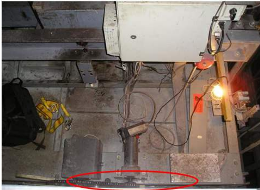
照片 2 罹災者於車廂頂部作業遺留之器具，及升降機上升後被夾於車廂前方與升降路之間的位置
