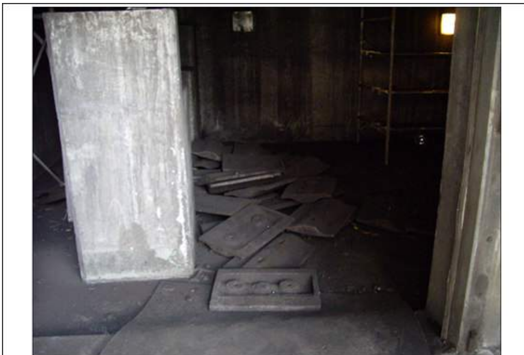
說明 3 煤磨機機體下方地上由機體內掉落之襯板 (約 37 片)
