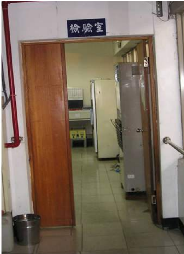
照片 2：災害現場位於該廠檢驗室內
