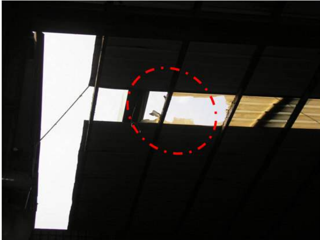
照片 1：屋頂之採光罩有一形狀不規則之開口(距地面之高度約 6 公尺)
