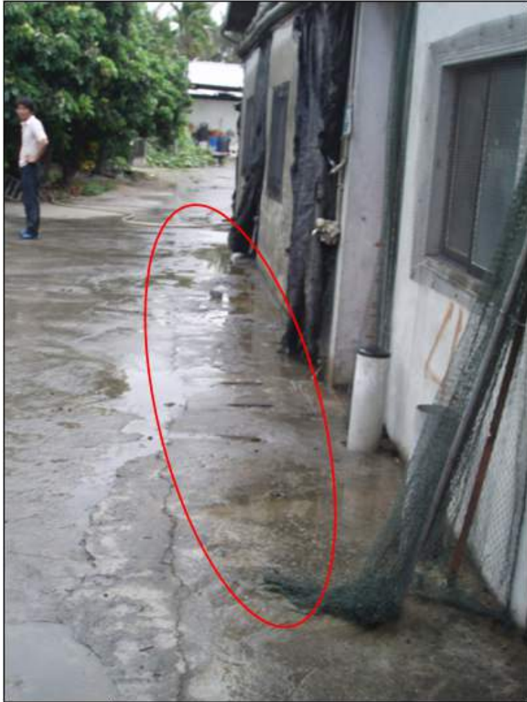
說明 | 照片一：肇災溝渠於 0000 牧場內情形 (暗管)。
