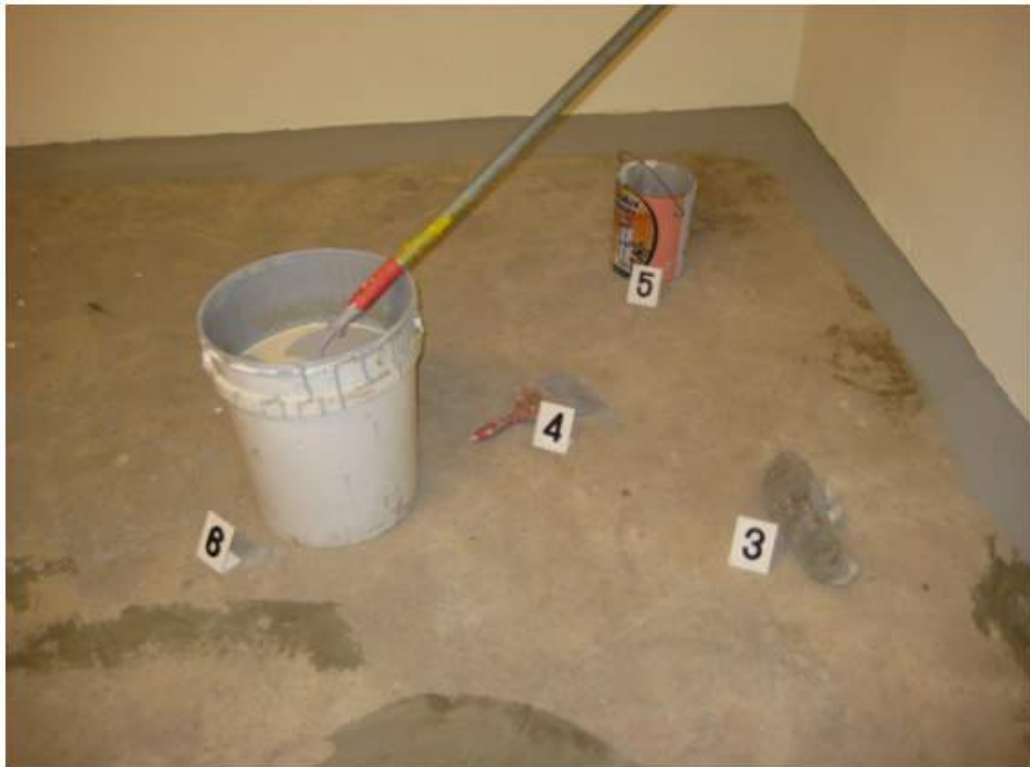
照片二 油漆作業使用環氧樹脂漆與環氧硬化劑位置
