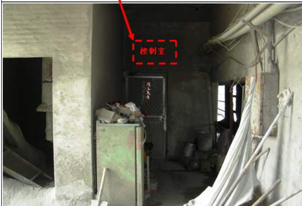
照片二 拌合機及輸送帶控制室
