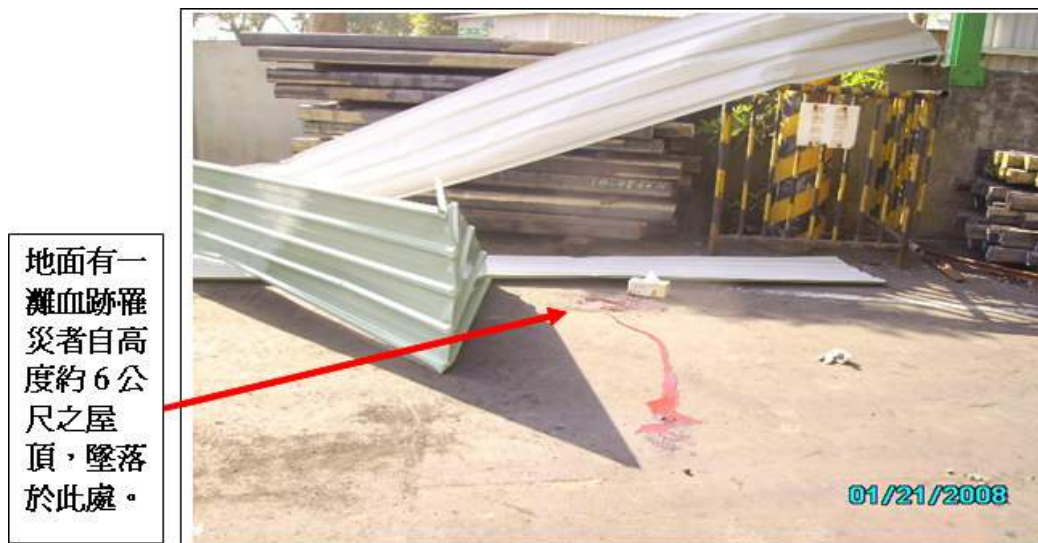
說明 照片二：罹災者自高度約6公尺之屋頂，墜落於地面。
