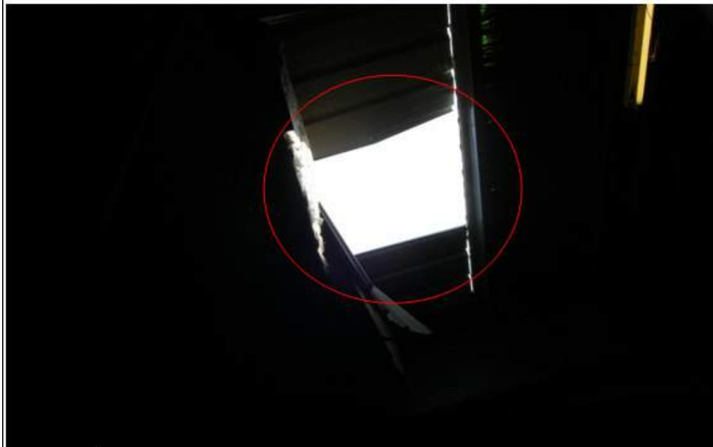
照片二 事故當日罹災者不慎自 3.4 公尺高之屋頂開口處墜落至地面。
