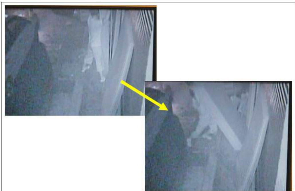
說明 圖二：一次搬動多片板材，支撐不住而倒塌
