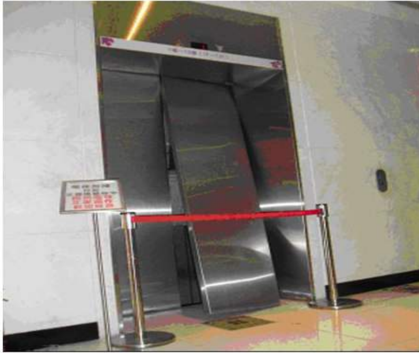
照片 1 錯開之電梯開口部
