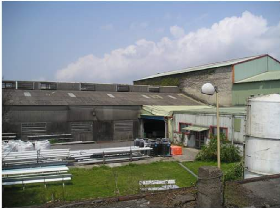
照片十三 各廠房屋頂相連接，未發現罹災者上下之移動式爬梯
