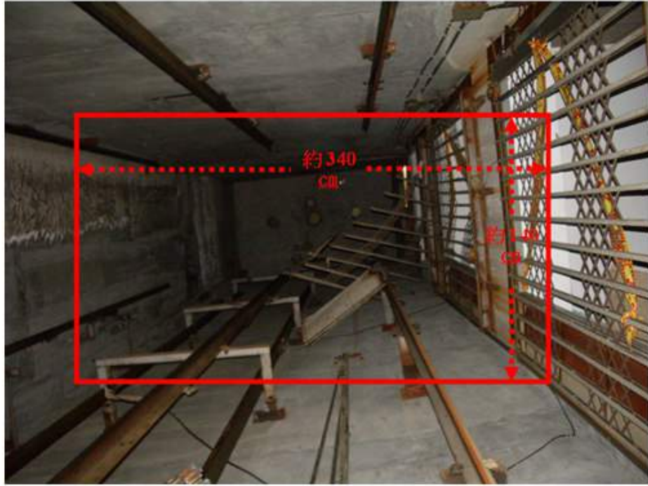
說明 3 電梯尺寸：電梯內之深約 340cm 寬約 140cm 電梯外拉門高約 208.5 cm、寬約 153cm
