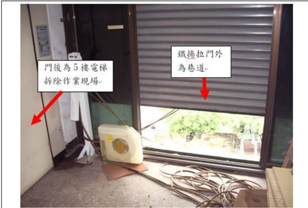
說明 1 五樓電梯拆除作業現場(一)
