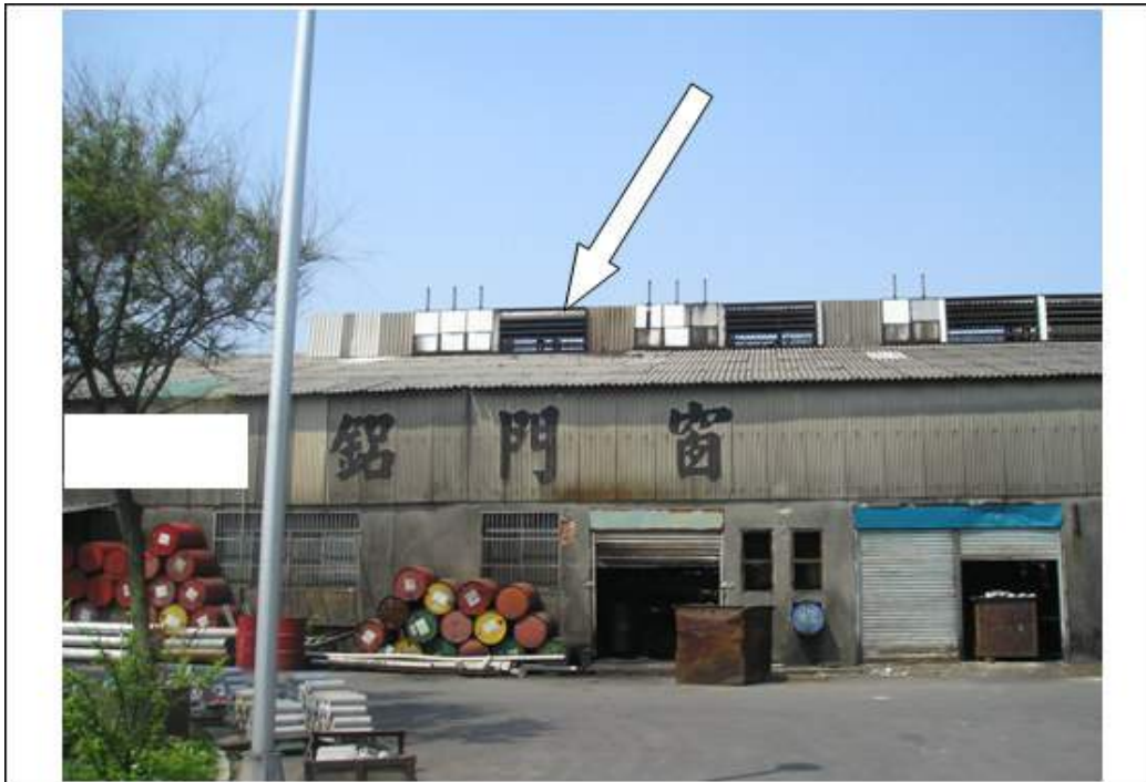
照片二 同上(太子樓 2 側裝設防颱百葉窗)
