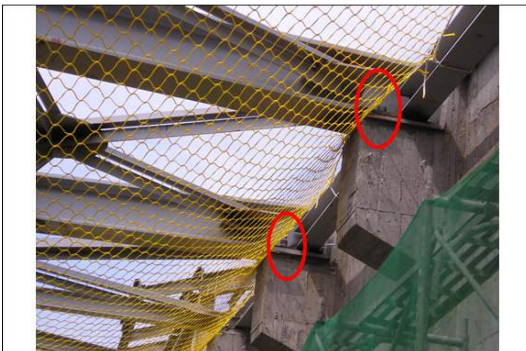
說明照片 2 鎖固 H 型鋼鋼樑與水泥柱之螺栓
