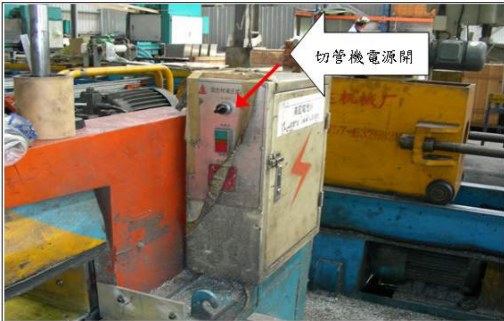
說明 1 肇災之切管機控制箱及電源開關。
