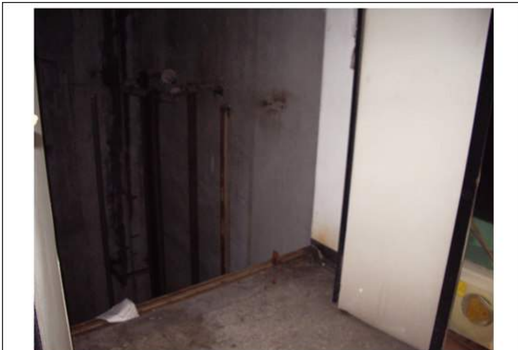
說明 2 五樓電梯拆除作業現場(二)
