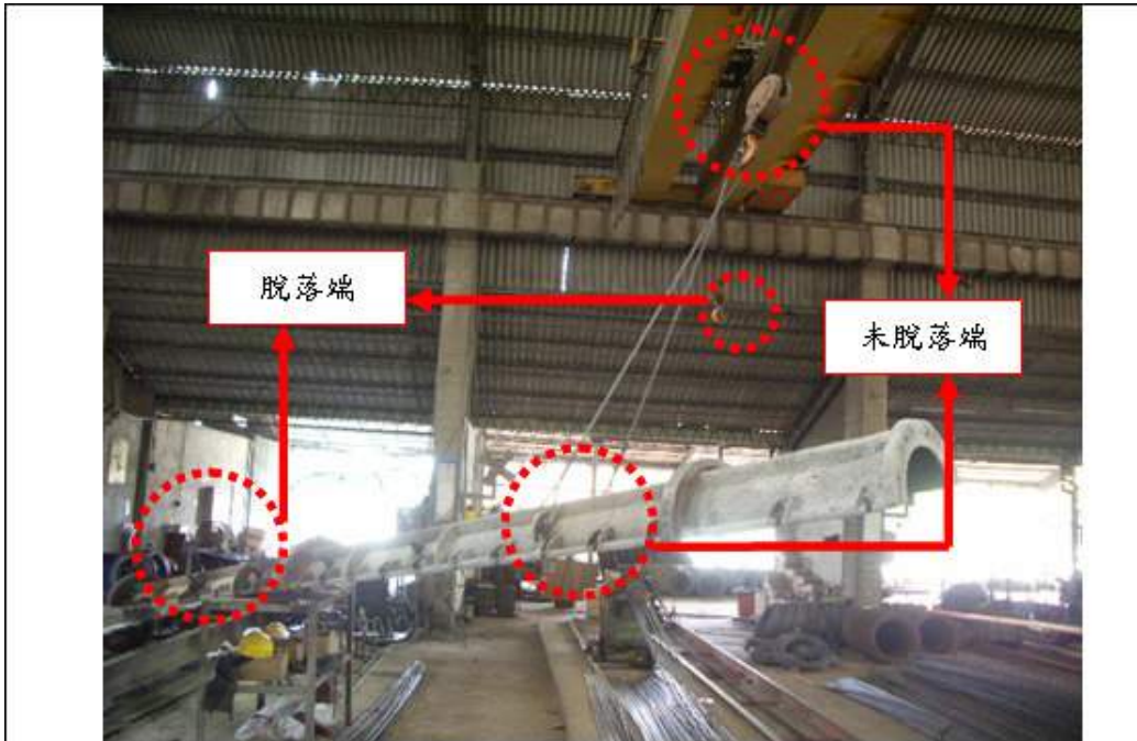
圖 6. 筆災之固定式起重機鋼索環眼脫落情況
