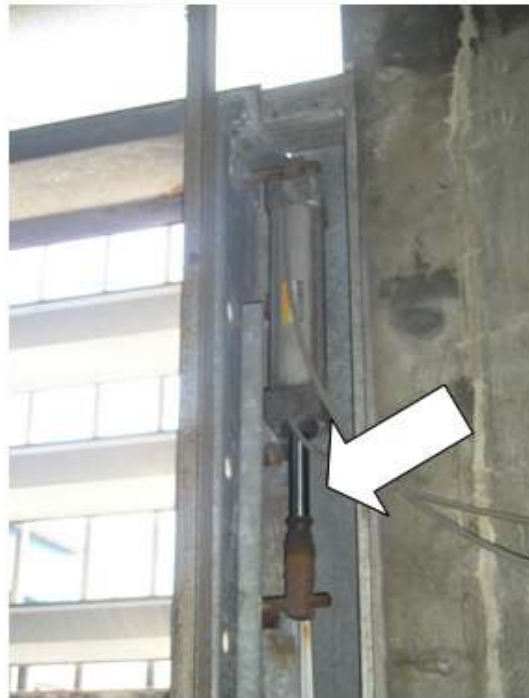
照片十 百葉窗「開」、「關」係以氣壓桿原理作動
