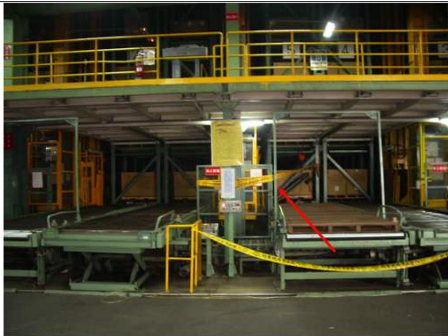
說明 圖四：災害現場遠照。
