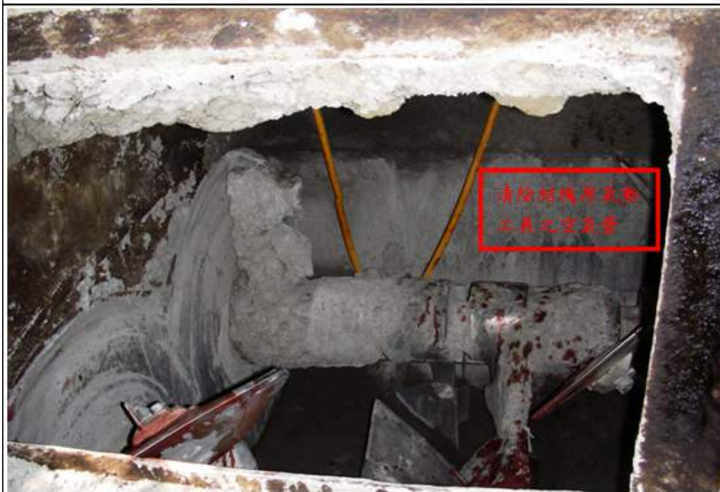
照片四 災害現場-拌合機內部
