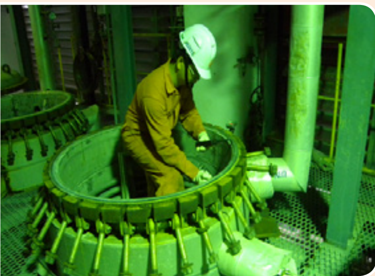
◎ 檢查員進入反應槽實施測厚及確認銲道狀況
