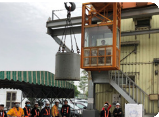
◎ 固定式起重機吊掛作業教育訓練實習
