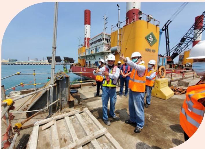
◎ 臺中港 36 號碼頭新建工程現場檢查情形
