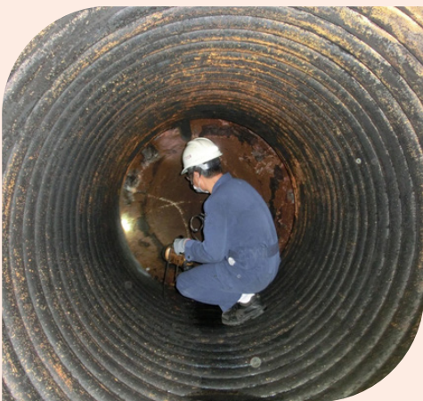
◎ 檢查員進入貫流式鍋爐實施爐管測厚及確認銲道狀況
