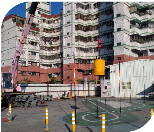
◎ 辦理勞工吊掛作業訓練
