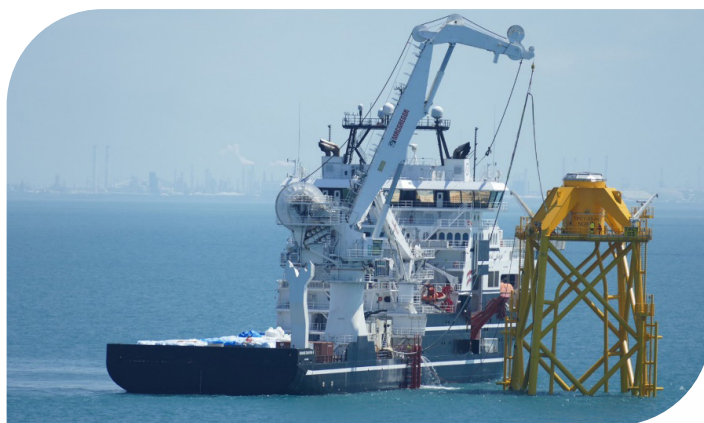
◎ 海上基樁套筒桁架組裝作業
