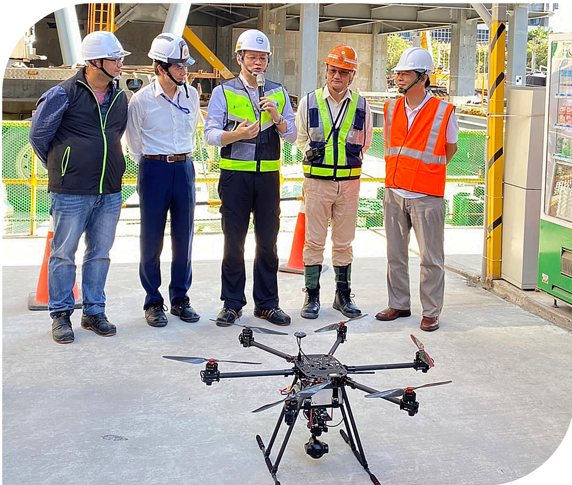
◎ 職安署至營造工地宣示強化無人機科技巡檢
