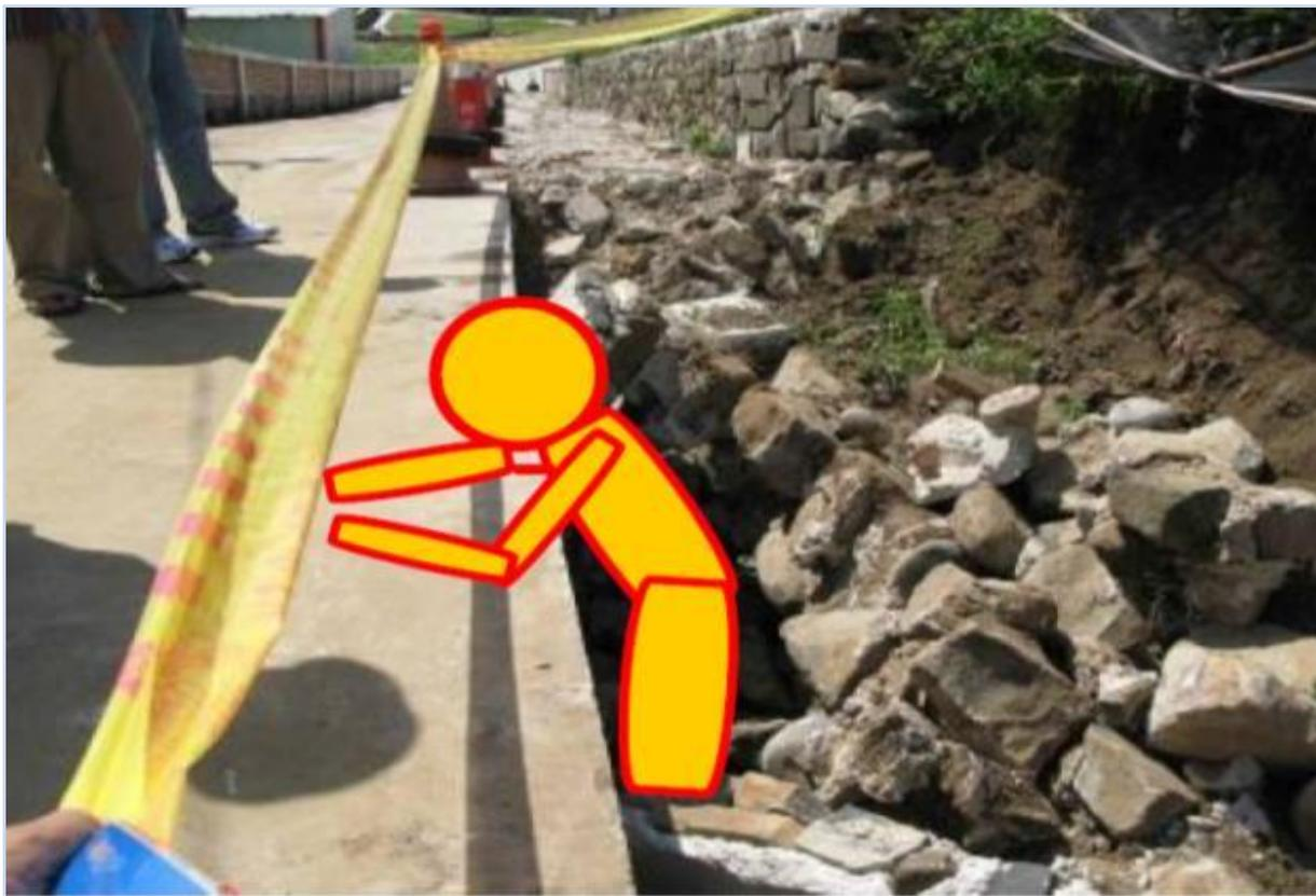
罹災者張○○負責載運土方外，尚須下至開挖面從事開挖完成面尺寸之量測及整平工作，約於當日下午3時許，當罹災者下至開挖面從事作業時，開挖面上方一旁之砌石矮牆突然整片倒塌，罹災者閃避面向道路側欲逃出，卻因不及砌石矮牆之倒塌速度，致背部以下遭砌石壓住，雙手趴臥在道路上，傷重不治。
