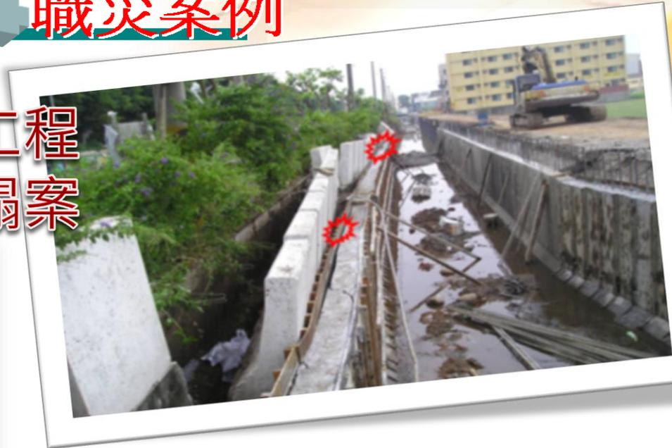
某營造公司於進行拆模作業時（開挖深度約為2公尺、寬度約為3公尺），因該拆模段原設置之擋土支撐已先拆除，致一旁原有道路擋土牆發生崩塌，造成所僱2名勞工被壓，經送醫院急救，傷重不治死亡。
