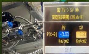
數位控制壓力 過高自動洩壓
