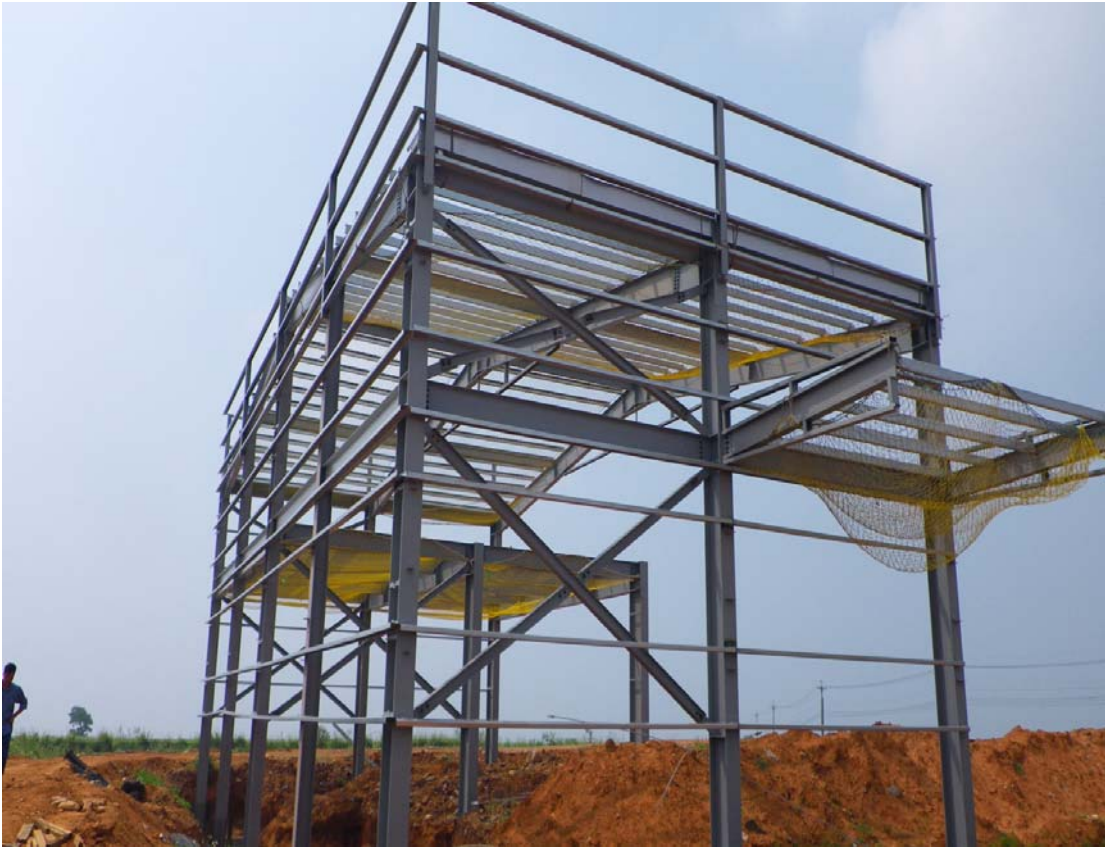
照片 1 台灣○○有限公司「倉庫之廠房鋼構工程（一次工程）」
