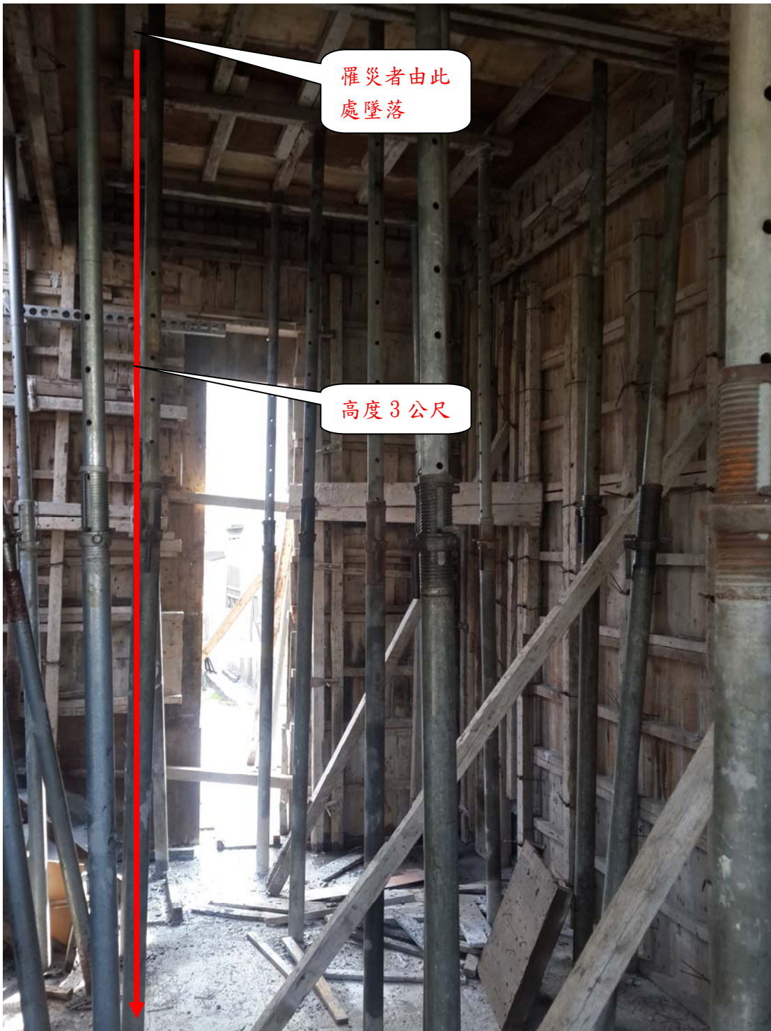
照片 3、1 樓頂板距地面高度 3 公尺
