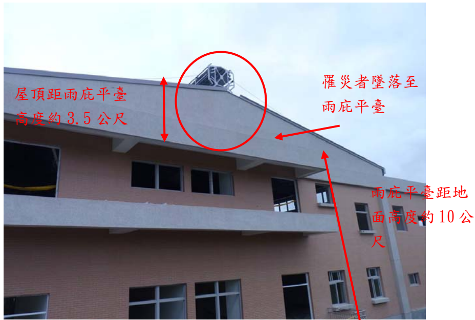
照片 罹災者災害發生時作業位置，位於新建廠房屋頂；罹災者自紅圈處移動梯(已移除)上墜落至雨庇
