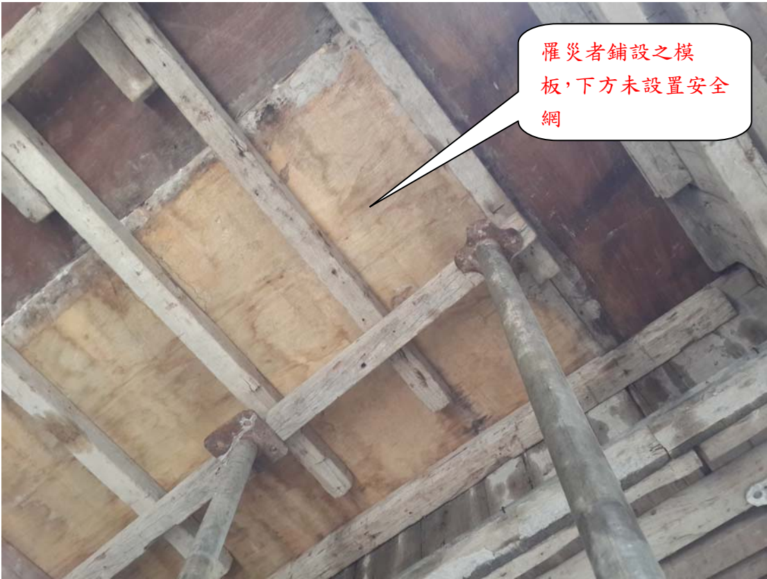
照片 2、罹災者於 1 樓頂板從事模板鋪設作業（災害發生當時尚未鋪設完成）
