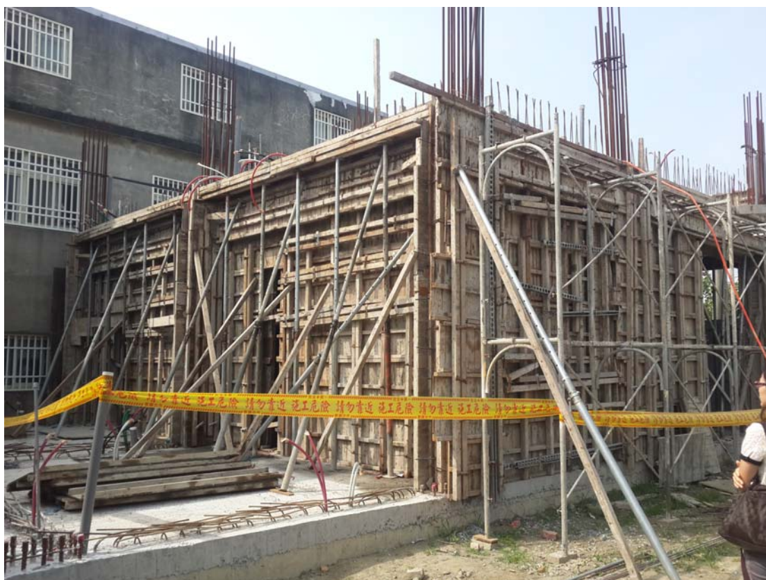
照片 1 林○信、林○志住宅新建工程為 3 層樓建築，目前進行 1 樓頂板模板作業
