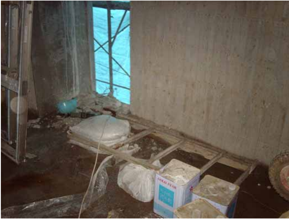
照片 1：災害現場位置及施工使用之合梯（地上七樓）
