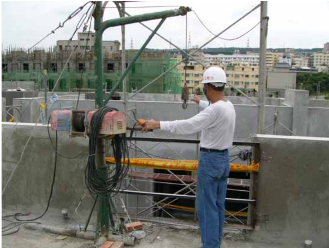
照片 1：假想罹災勞工墜落前操作捲揚機的可能相關位置。 (開口角鋼柵欄為職災發生後設置)
