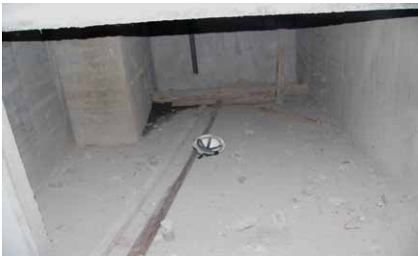
照片 1 地下 3 樓通風管道口
