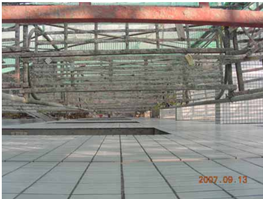
照片 2：災害現場位置之地上 6 樓外牆施工架，其長條型安全網 皆已拆除
