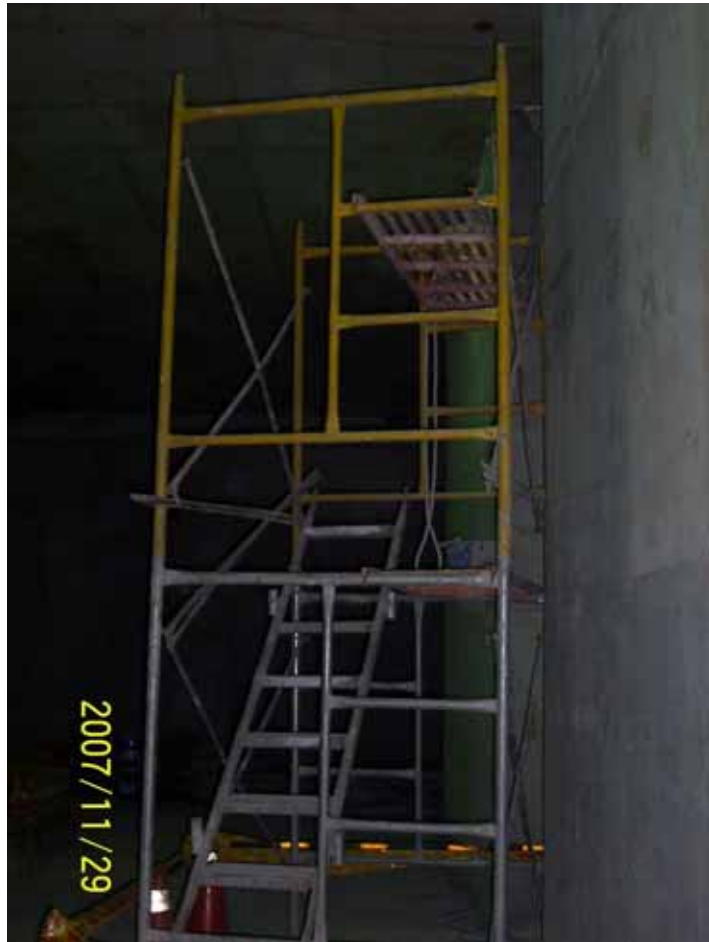
照片 1：罹災者使用之施工架
