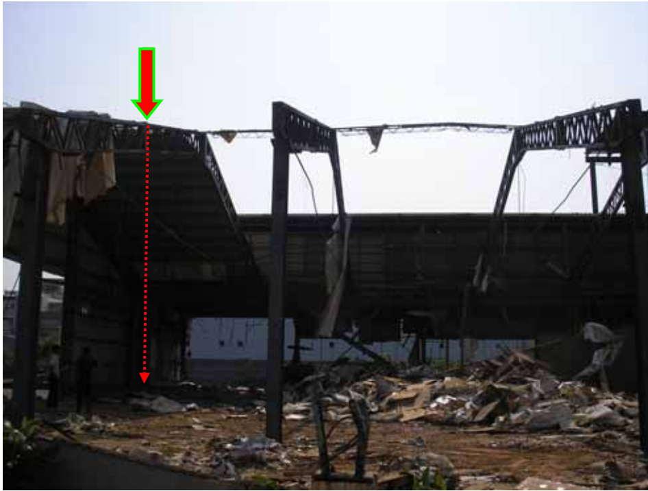
照片 1：屋頂從事浪版拆除作業位置對地高度 8.6 公尺
