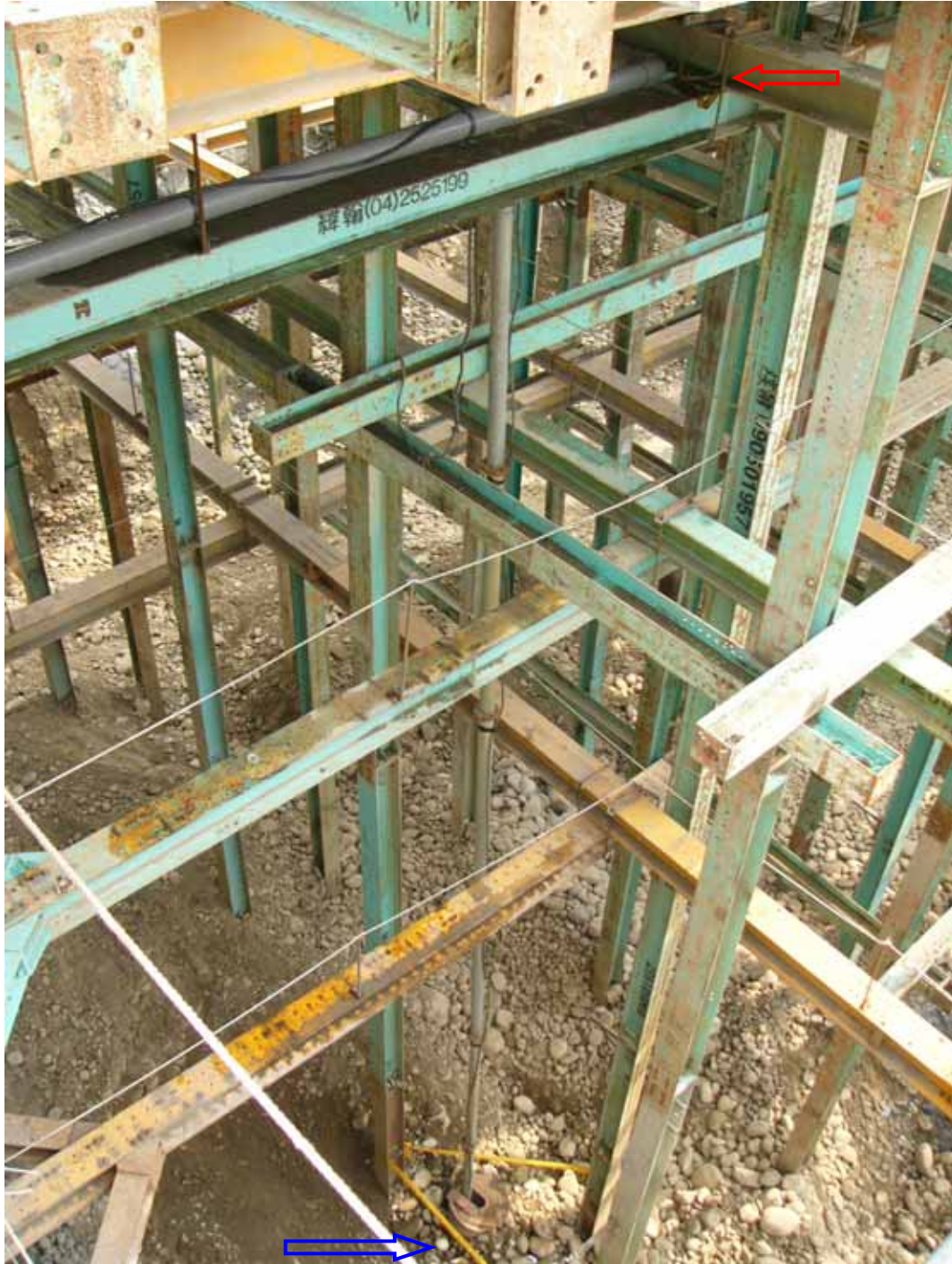
照片 1：災害發生處。紅箭頭處為罹災勞工所遺留之安全帶，藍箭頭處為罹災勞工墜落後遺留現場之安全帽，墜落高度 15.9 公尺
