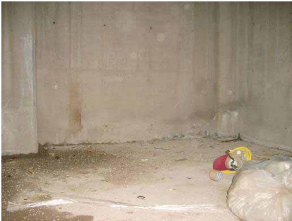
照片 2：墜落終點：FAB 棟 B 梯地下 1 樓
