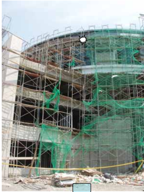
照片 1：工地 A 區及圓弧建物外牆施工架(地面區塊為罹災者躺臥位置)
