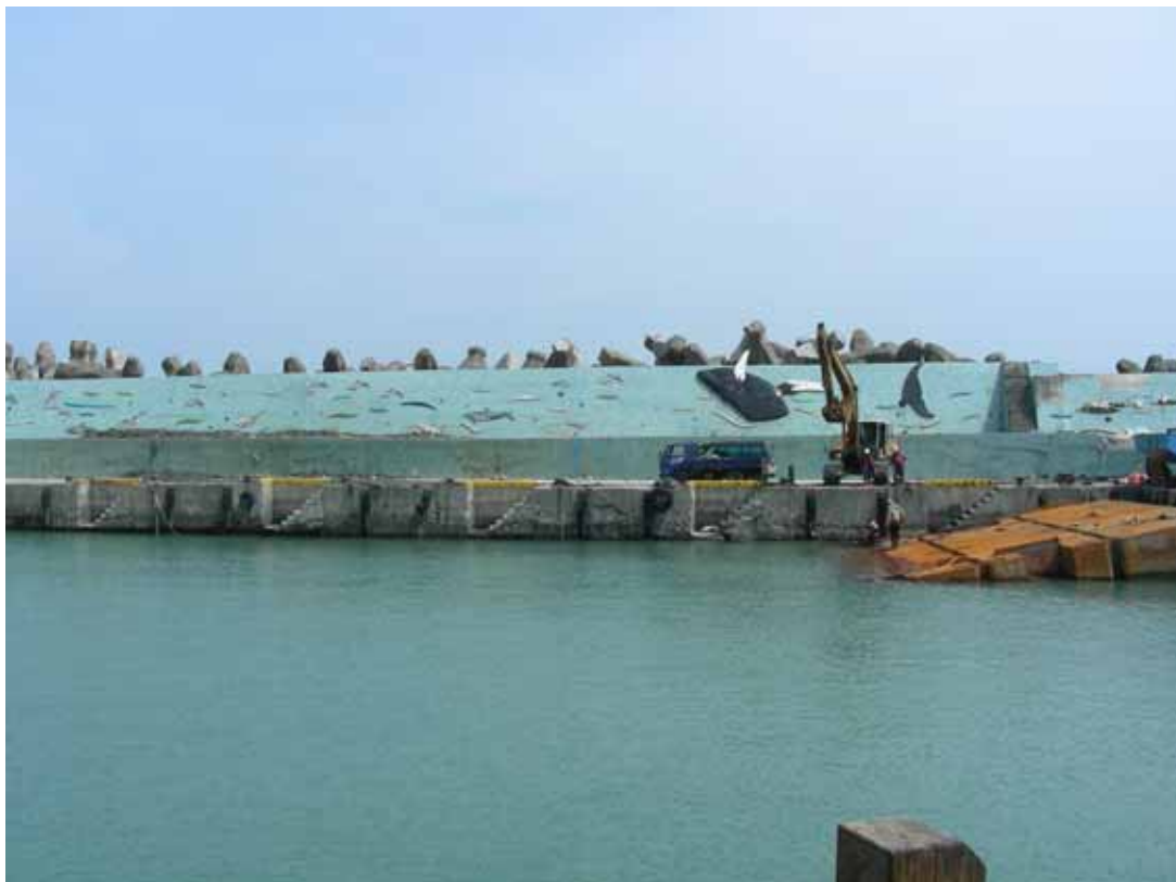
照片 2：當日下午防颱準備時，正要把工作平台船(11.6M×15M)繫於右邊數來第 3 個黃色橫檔旁的繫繩柱上
