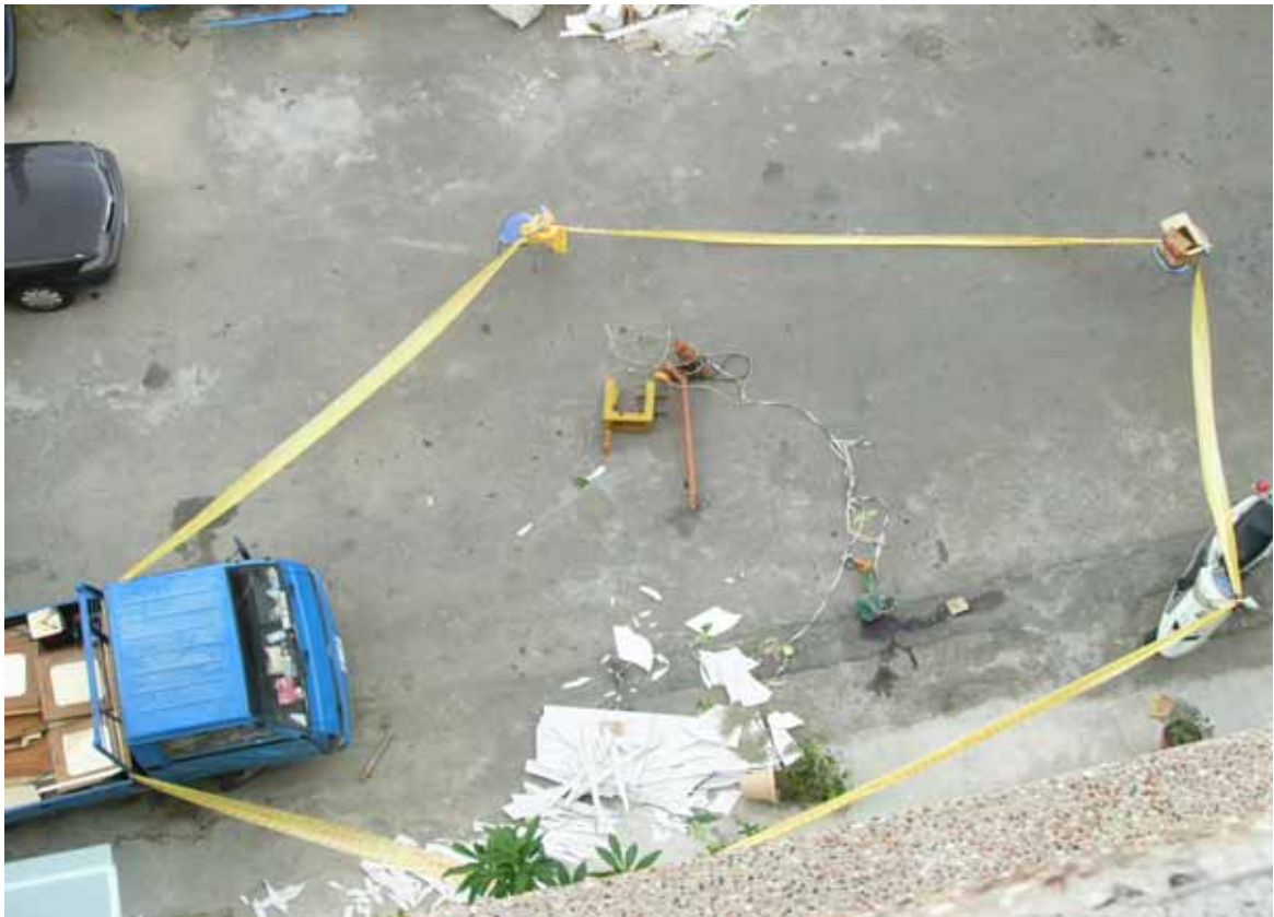
照片 1：墜落於地面之捲揚機、矽酸鈣板及為避免吊料碰撞外牆綁在吊勾上方鋼索上之繩索與陳○○位置
