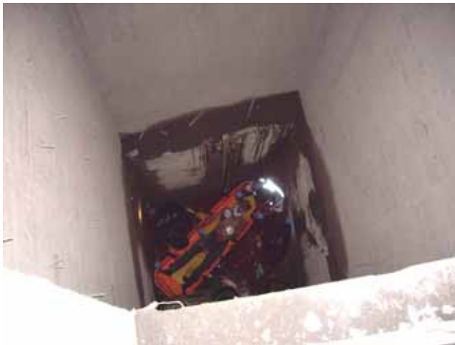
照片：罹災勞工進行1樓電梯直井吊料平台拆除作業， 因未設置防護墜落至地下3樓電梯機坑致死
