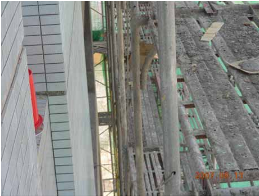
照片 1：災害現場位置之地上 6 樓外牆施工架。(罹災者當時作業位置)
