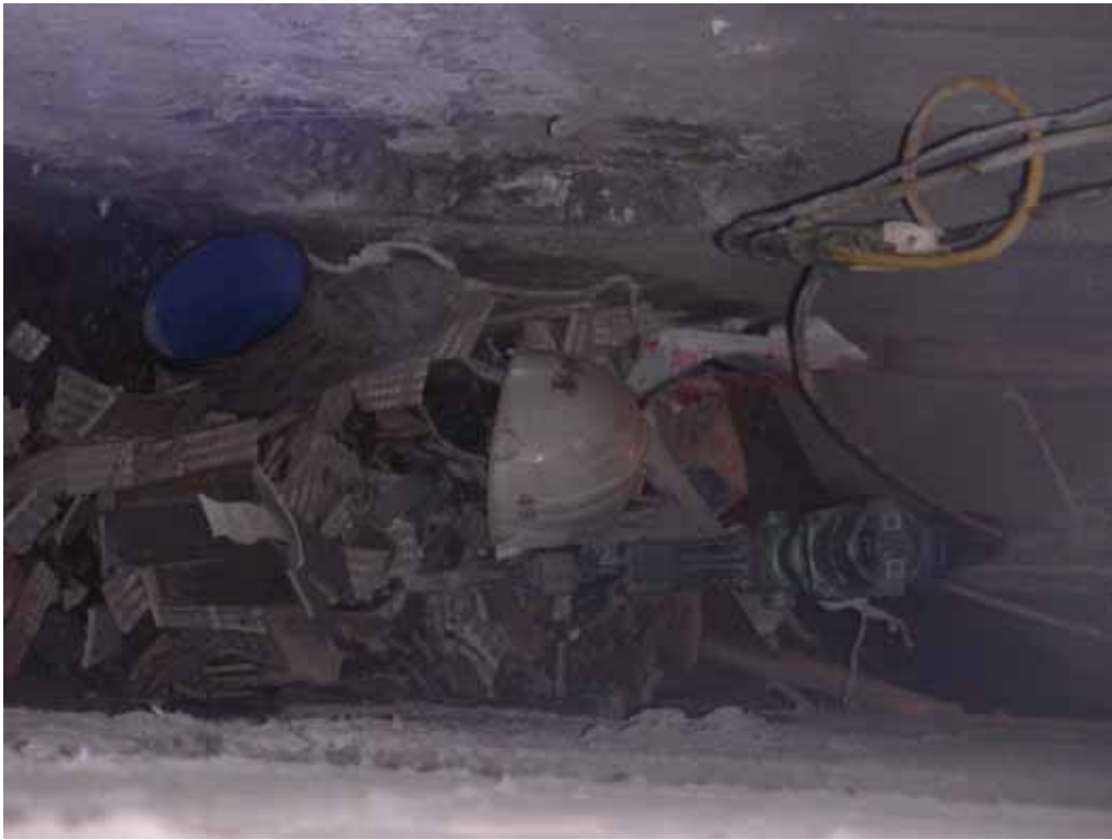
照片 1：罹災者遭二丁掛磚擊中頭部，現場安全帽破裂，散落一地的二丁掛仍留有血跡，留置一旁的打石工具為工務所提供
