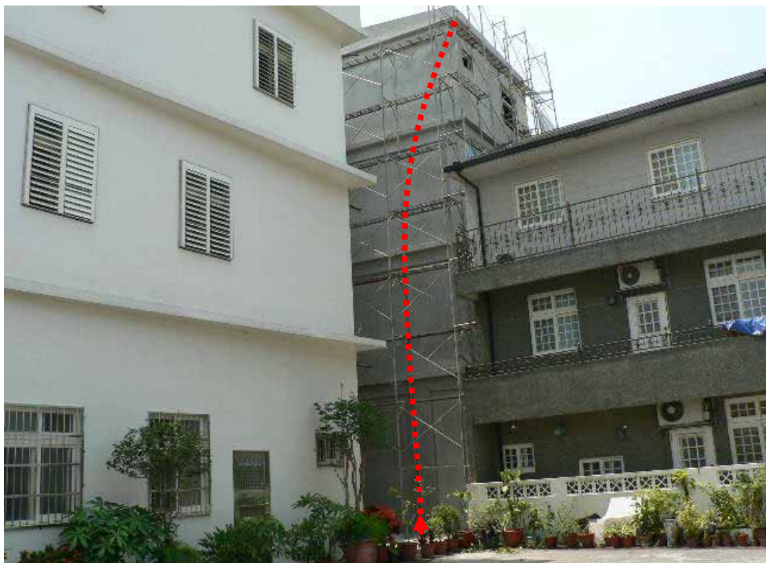
照片 2：面向建築物之背面及右側外觀情形
