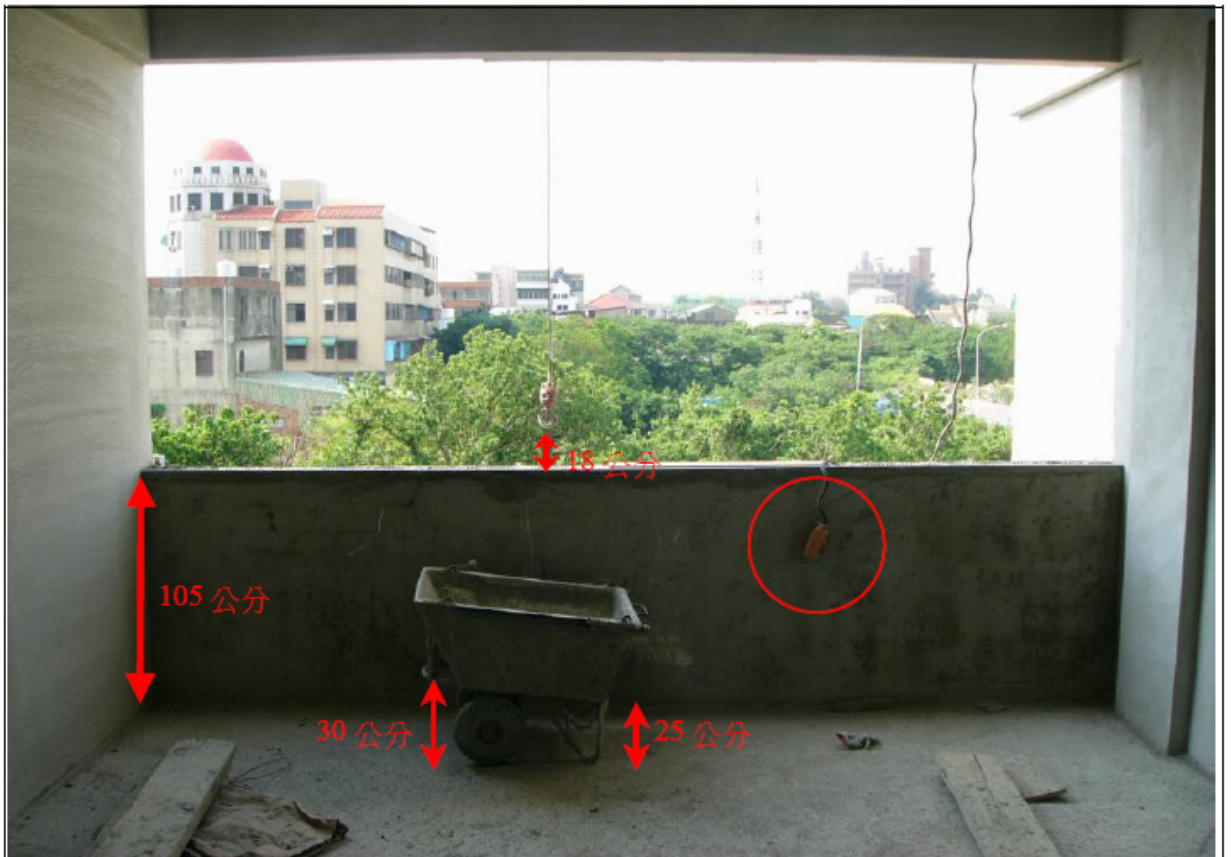
照片 2：3 樓後陽台置放吊料所需之獨輪車（車體底部離地板面為高度為 25 公分—30 公分），捲揚機鋼索、掛鉤（距水泥磚造欄杆頂部距離為水平距離約 59 公分、垂直距離 18 公分）及其控制開關
