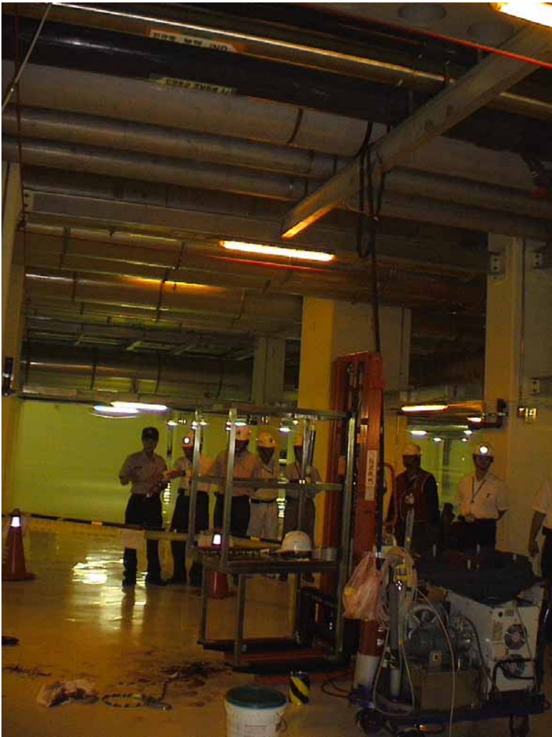
照片 1：職災現場實景（救災時將升降平台降下）
