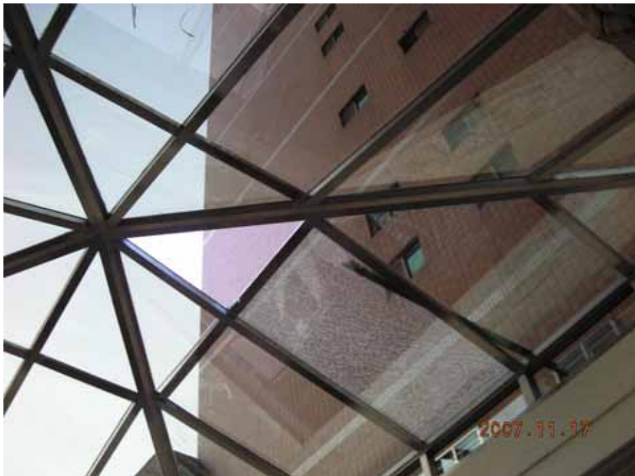
照片 2：罹災者墜落之採光罩直角三角形開口
