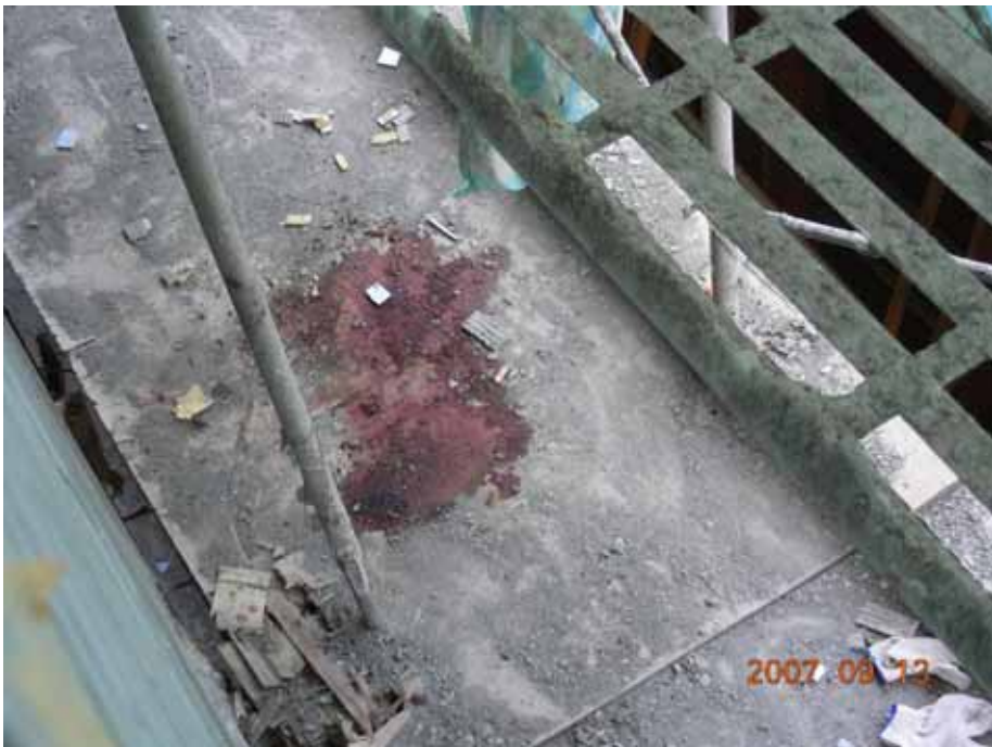
照片 4：罹災者墜落位置示意圖 (地上 2 樓施工架三角托架上之平板)
