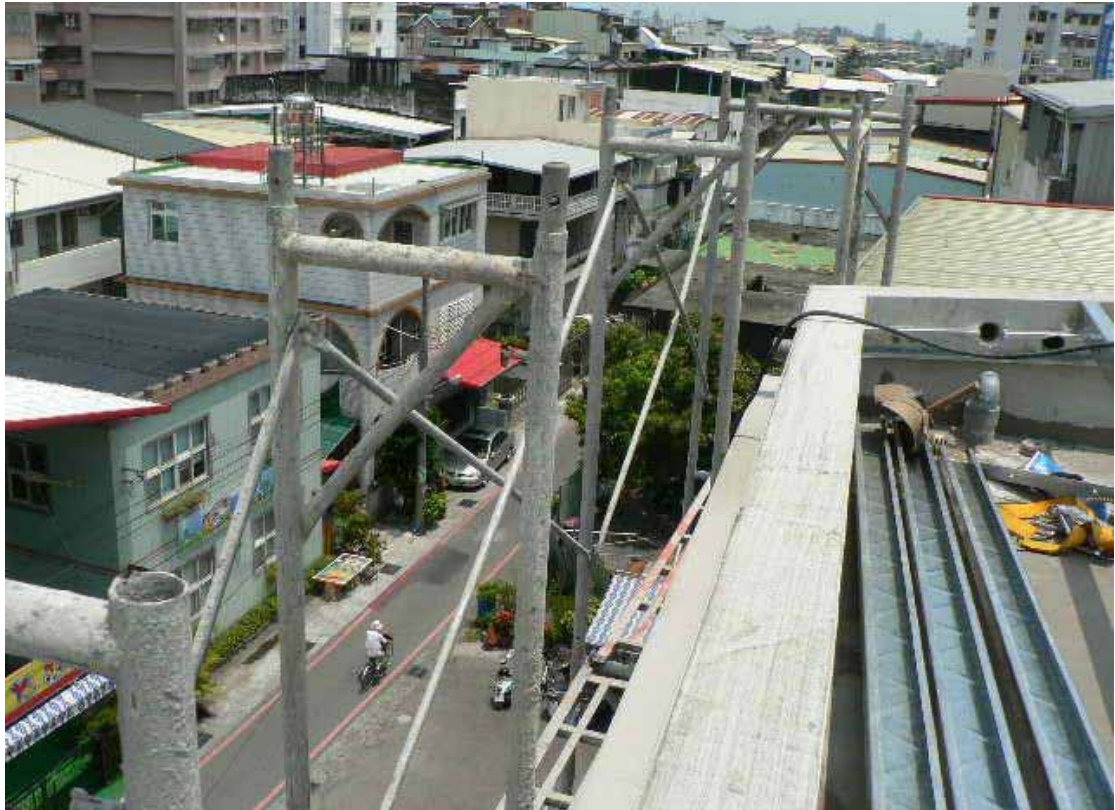
照片 3：面向建築物之背面施工架組立情形（此處護欄寬架據土木工程部分承商稱災害發生當天中午時係被掛置於下層架上）
