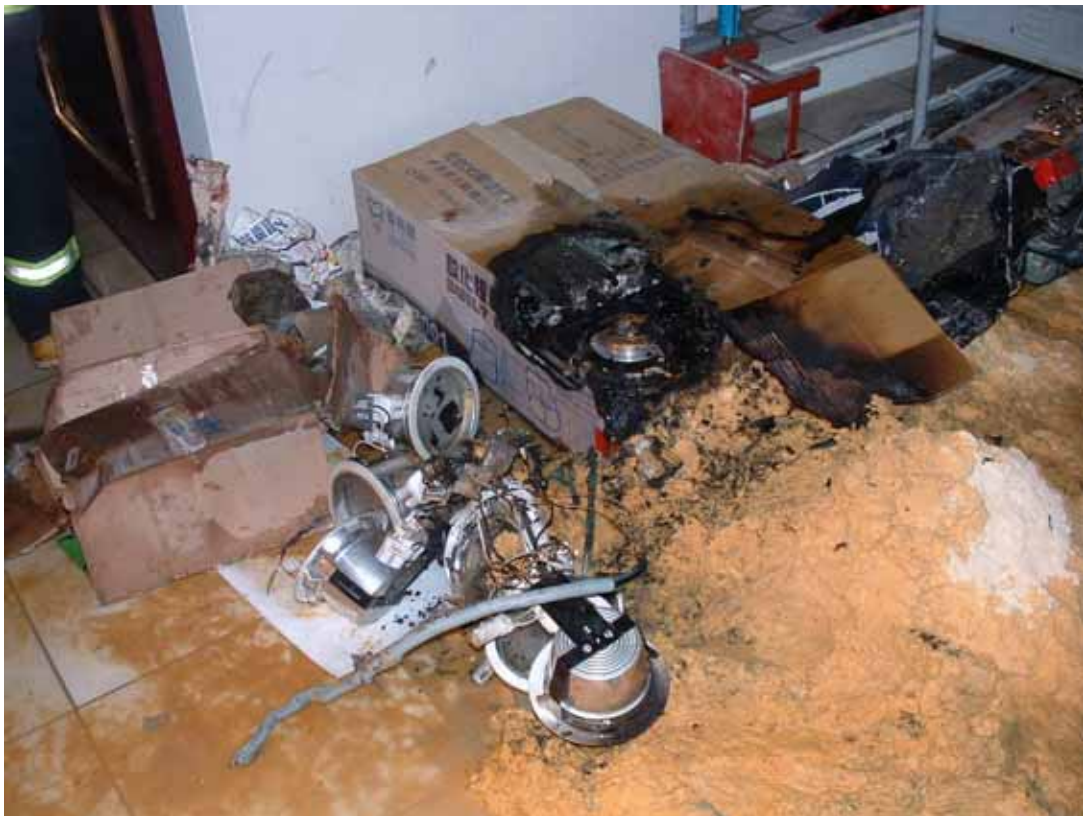
照片 2：客廳門口、燒壞之瓦斯爐及磨地板產生之木屑
