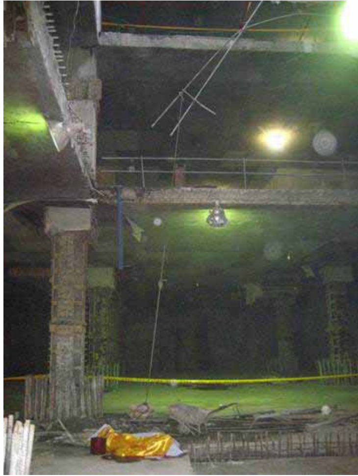
照片 1：現場情形
