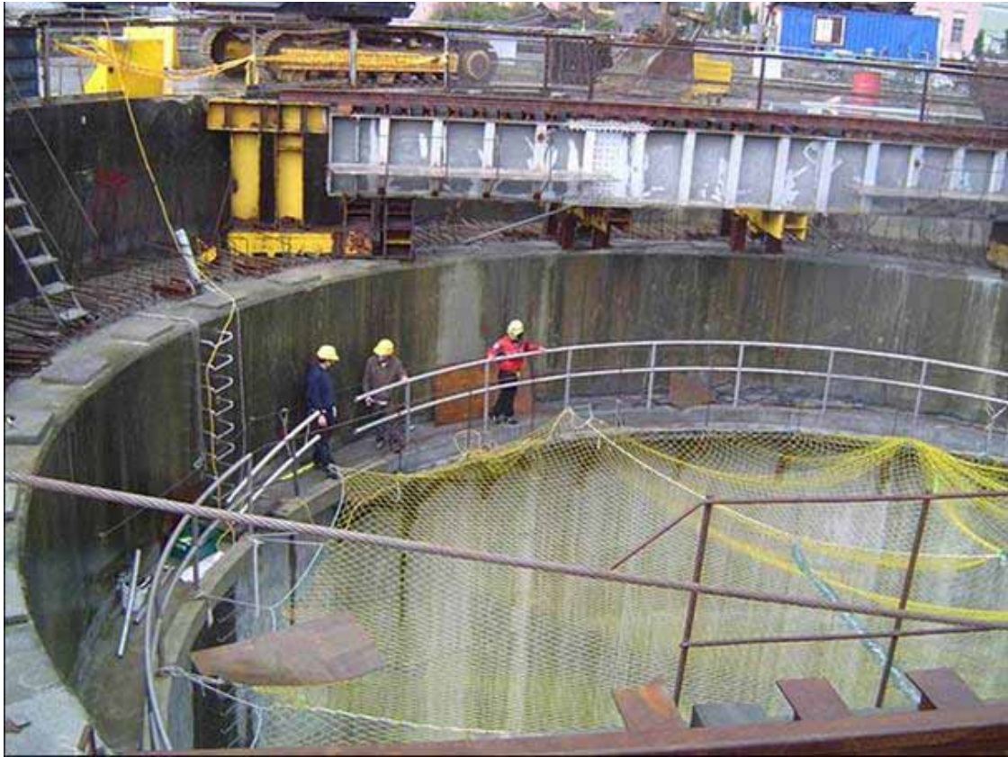
照片 1：災害發生前現場狀況
