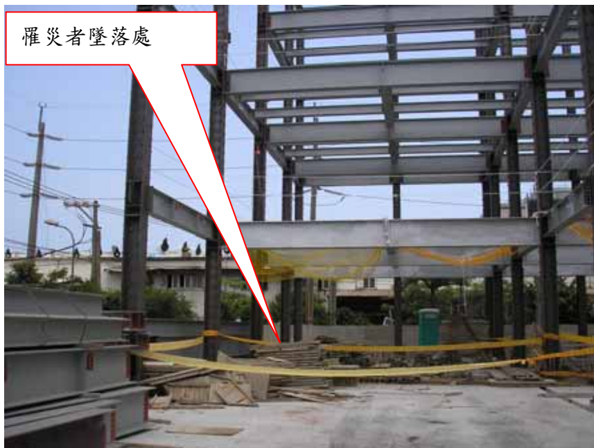
照片 2：事故現場鋼構組立狀況
