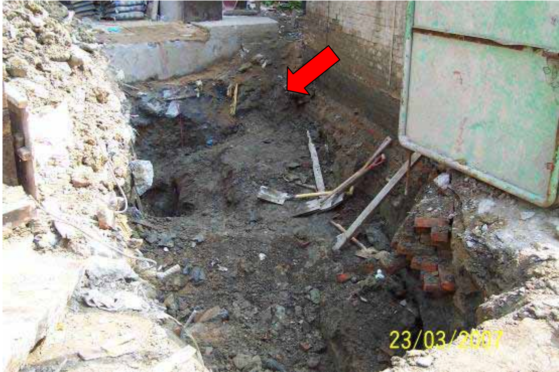
照片 1：現場管溝開挖情形（於搶救後由大門側向建物側拍攝）， 箭頭處為混凝土版塊滑落之位置及方向
