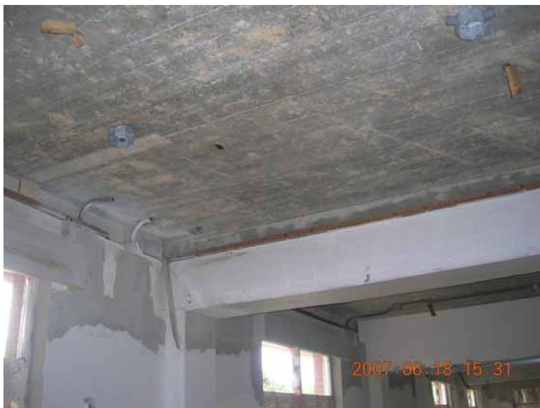
照片 1：罹災者於災害發生前欲施作天花板配管作業
