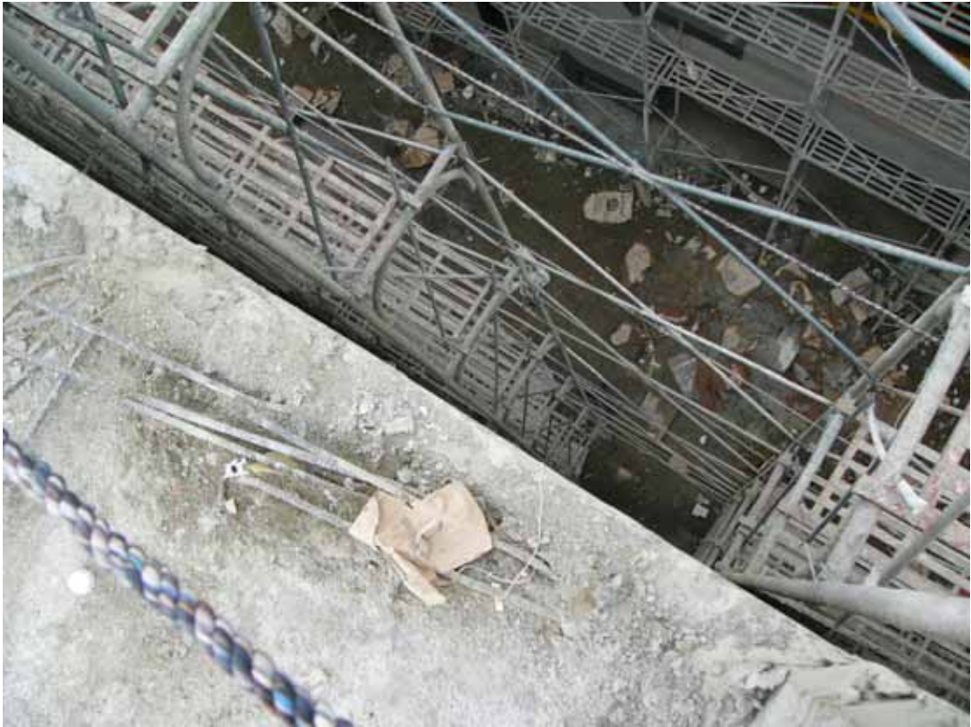
照片 2：罹災勞工墜落之女兒牆開口，高 12.4 公尺
