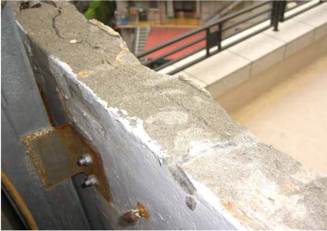
照片 1：現場捲揚機支架固定處（頂樓女兒牆）
