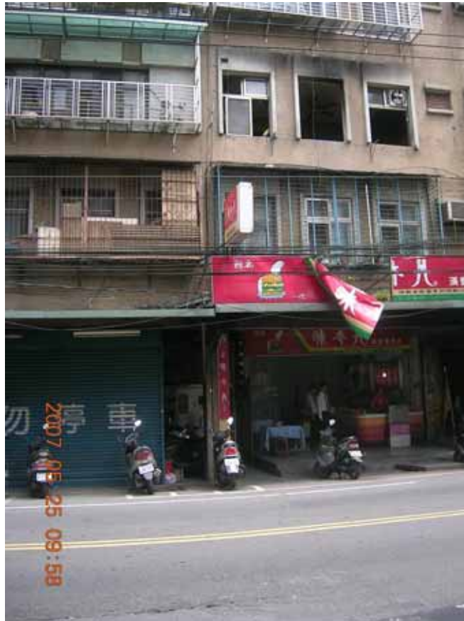
照片 1：罹災者自距地面約 7 公尺高處之 3 樓墜落地面
