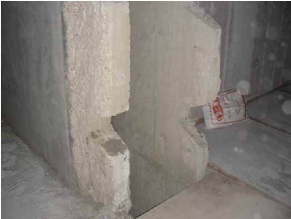
照片 2：9 樓二丁掛磚滑落處二旁伸縮縫約 45CM 未設防止物體飛落之防護，通道上的木板亦未固定
