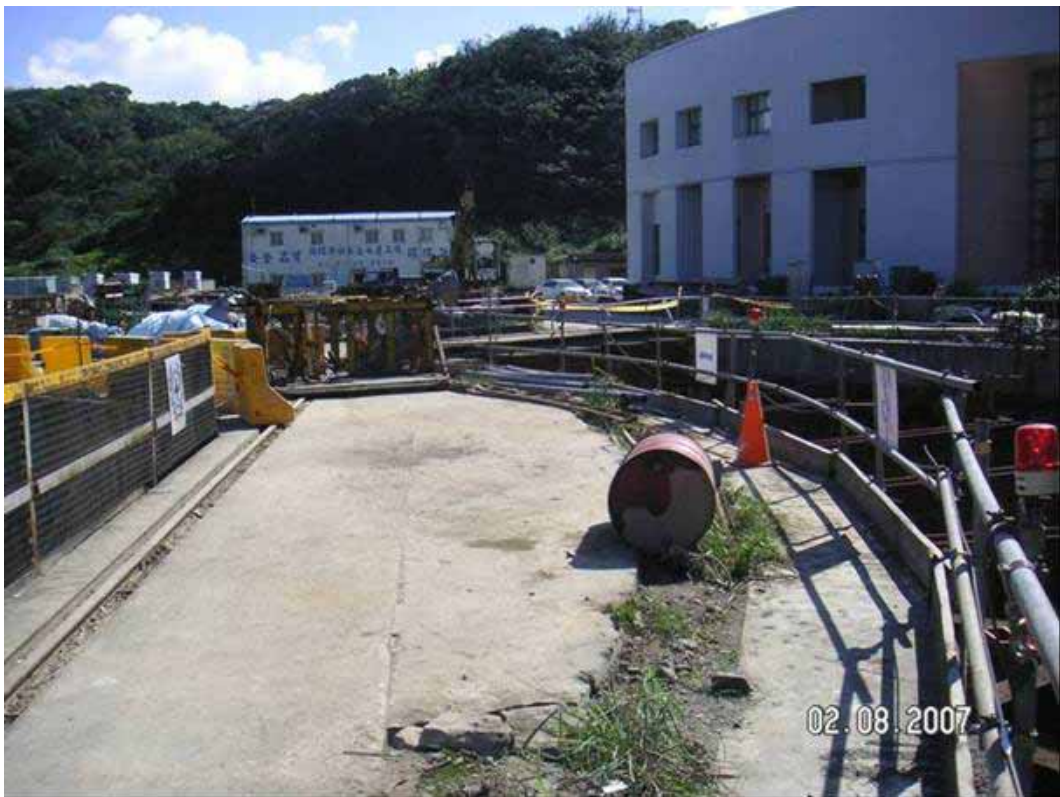
照片 3：事發後原位於 2 號井與暗渠間便道之數堆支撐用型鋼位置已被移走
