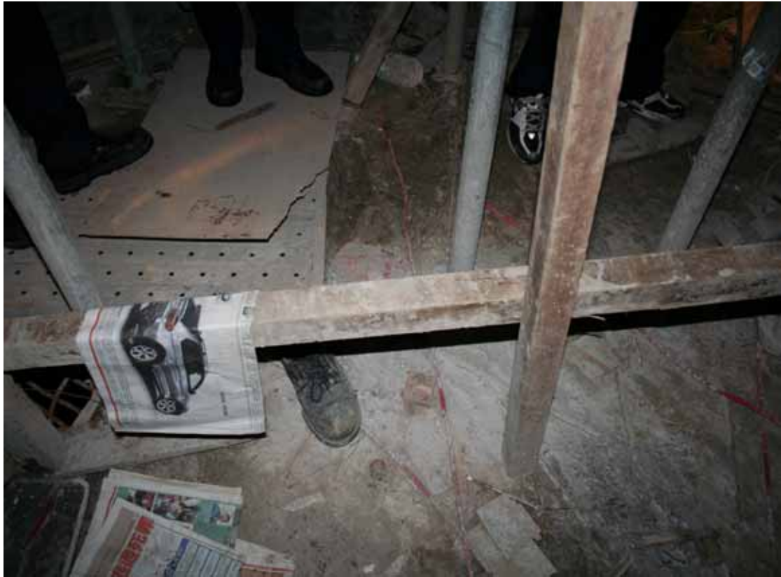
照片 2：災害現場警方於 96.5.10 晚上所拍攝，地面留有數條紅色電線
