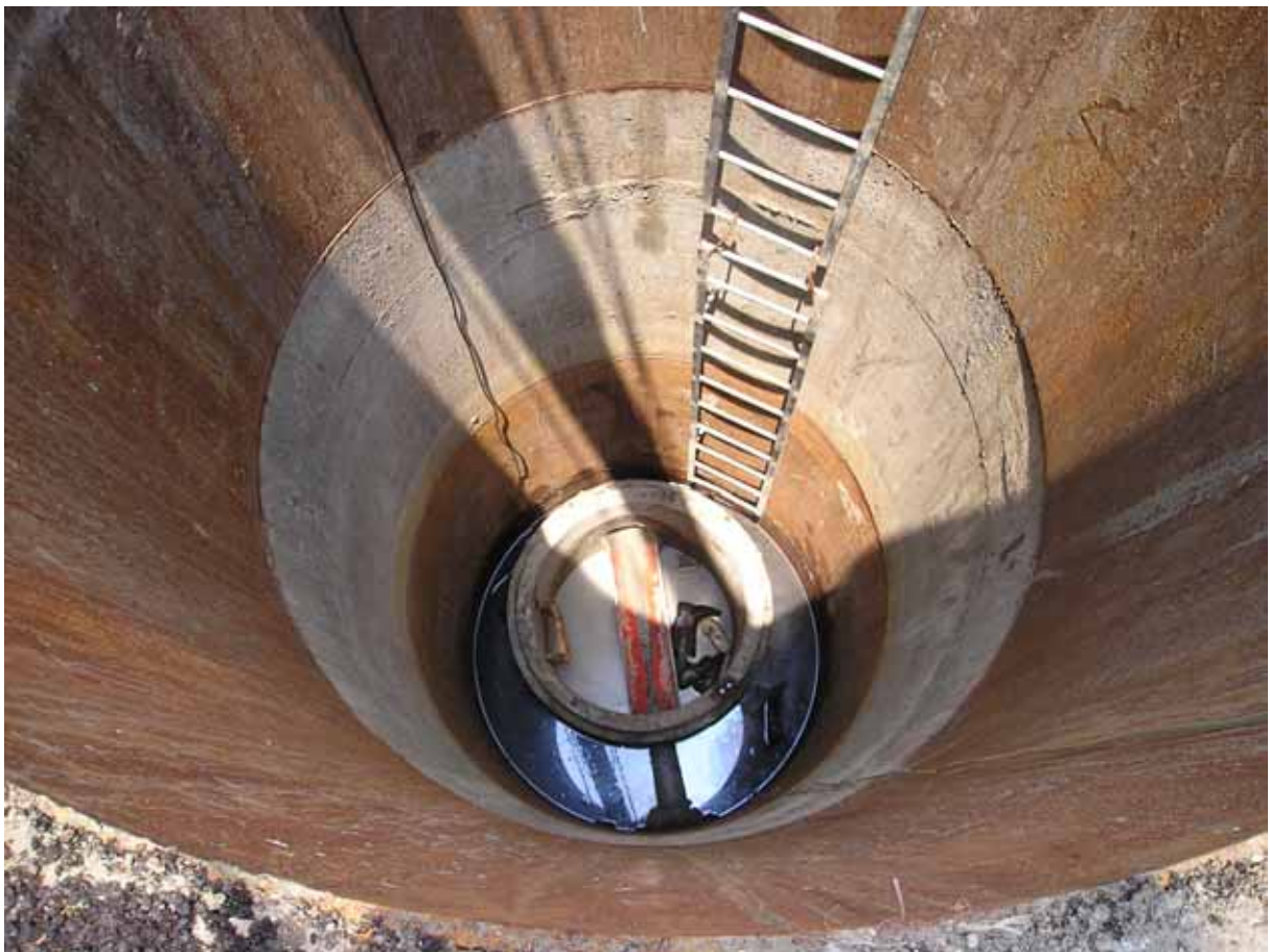
照片 1：發生災害之工作井底部
