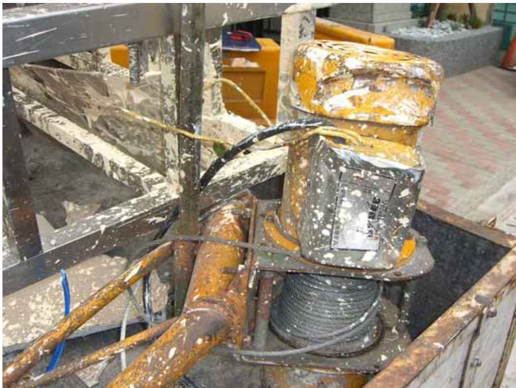
照片 3：使用之吊升捲揚機
