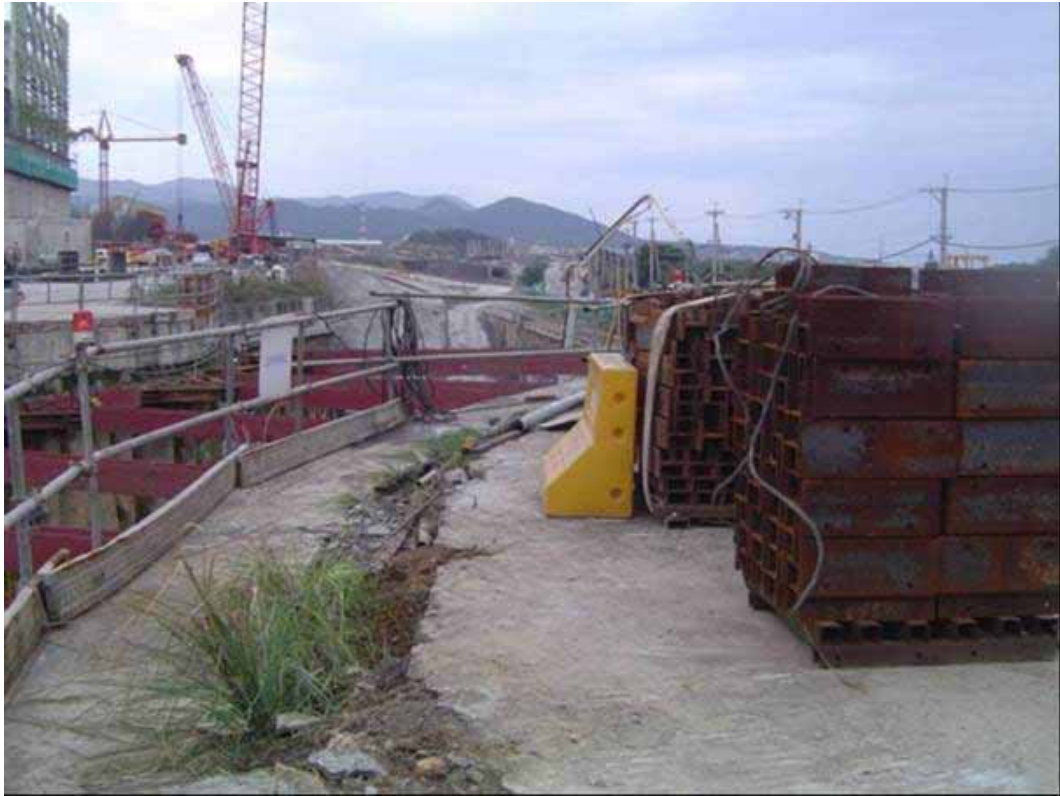
照片 2：災害發生前現場狀況
