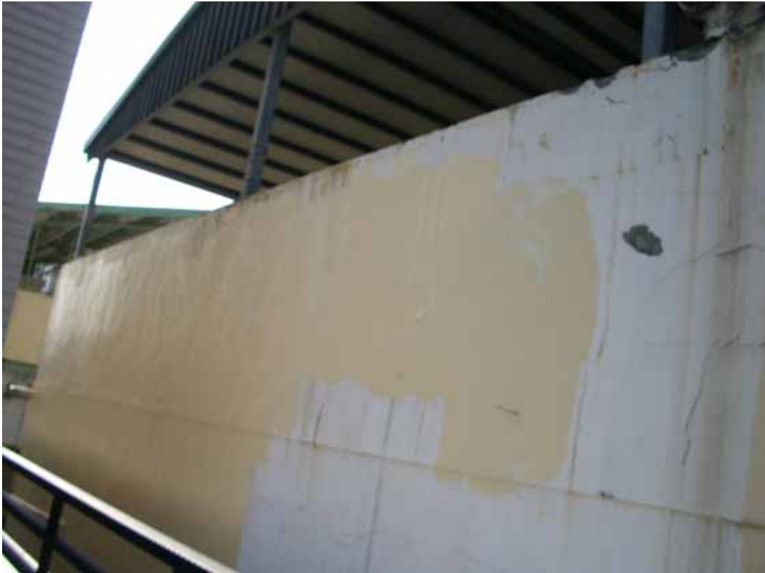
照片 2：現場防水塗刷作業處所
