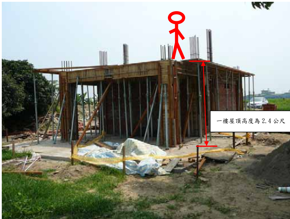
照片 1：罹災者站立於一樓屋頂西南角隅，距地面高度 2.4 公尺
