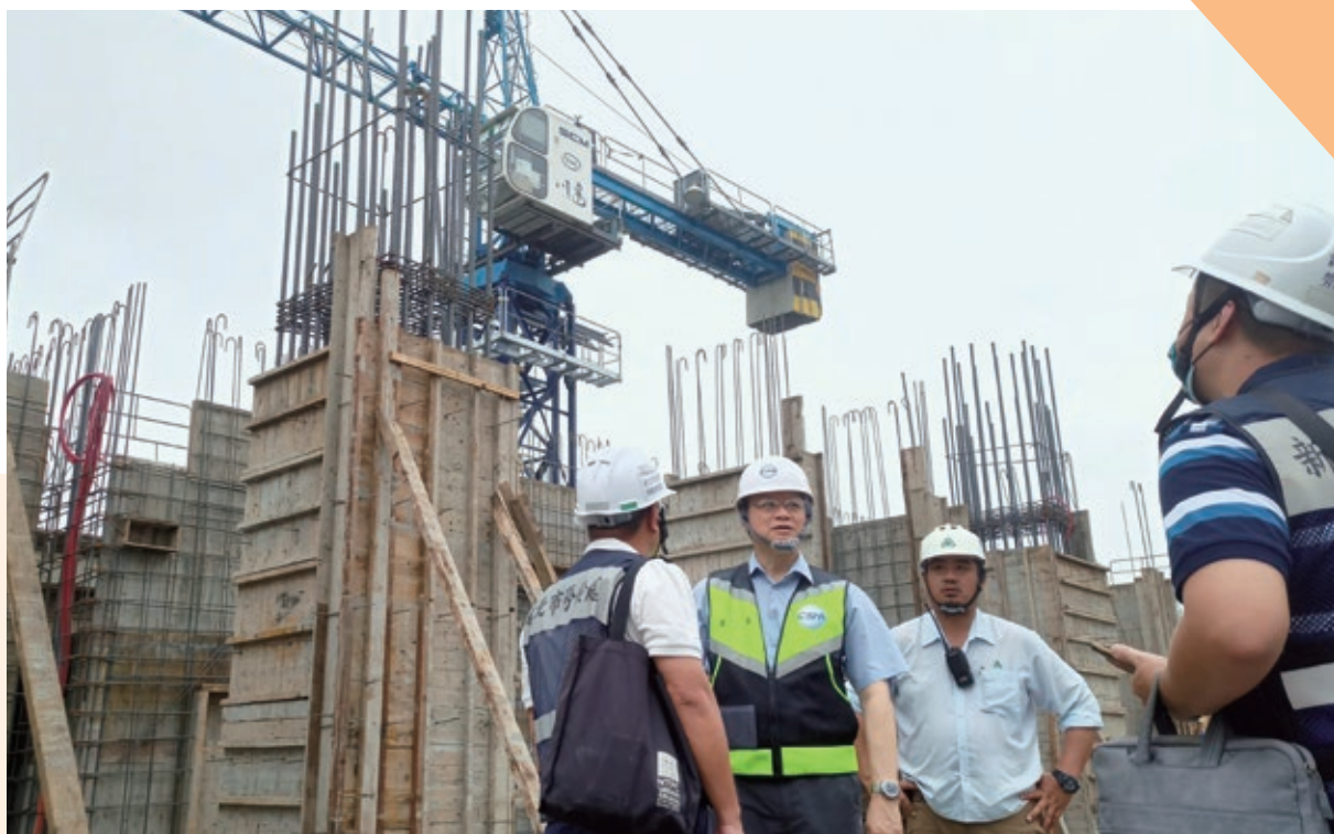
◎ 鄒子廉署長與新北市政府勞動檢查處李進欽副處長率檢查員前往新北市建築工地實施勞動檢查
