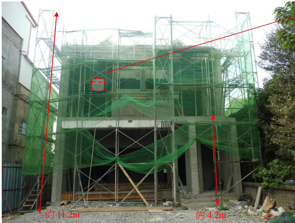
附照 1：外牆施工架高約 11.2 公尺，2 樓樓板(高約 4.2 公尺)開口部分未設置護欄。
