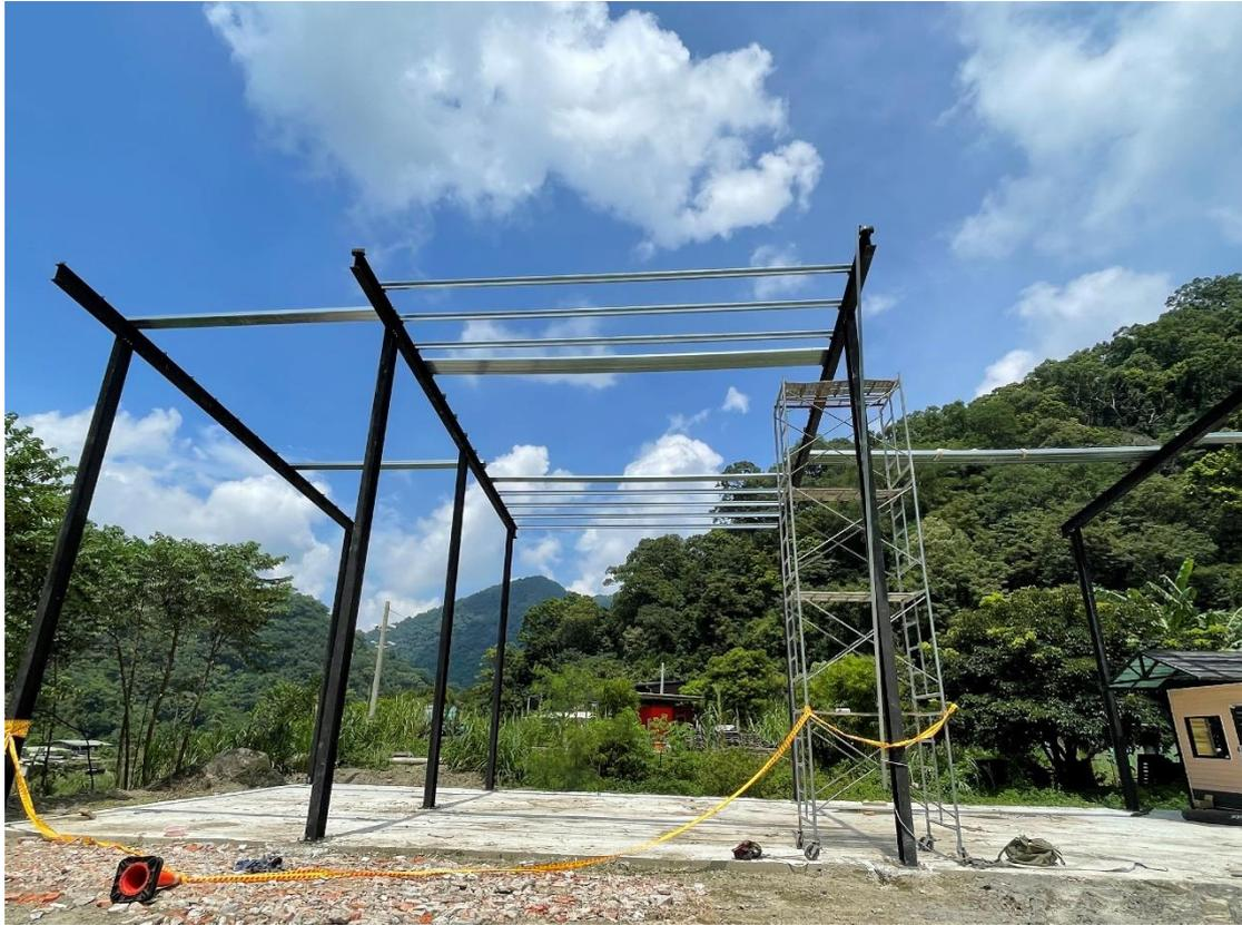
本案為鋼構建築物，高度 8.3 公尺，梁柱為 H 型鋼，小梁為 C 型鋼。事發位置為 H 型鋼主梁端部。
