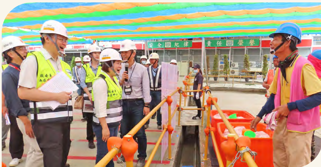
許銘春部長視察營造工地及發表高氣溫戶外作業熱危害預警行動資訊網，並提醒與關心勞工熱危害預防措施
