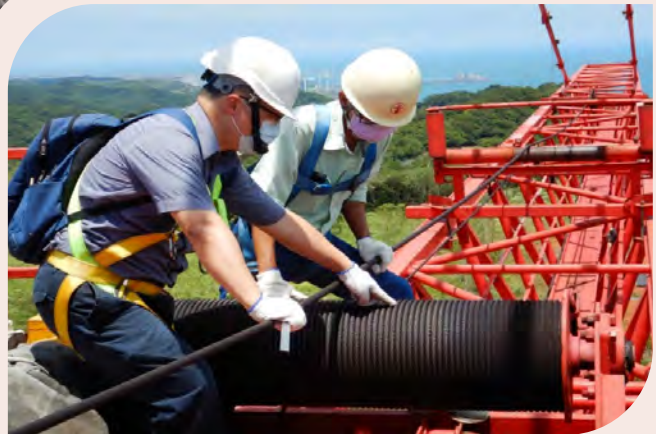
檢查員至塔吊伸臂處檢查確認鋼索狀況
