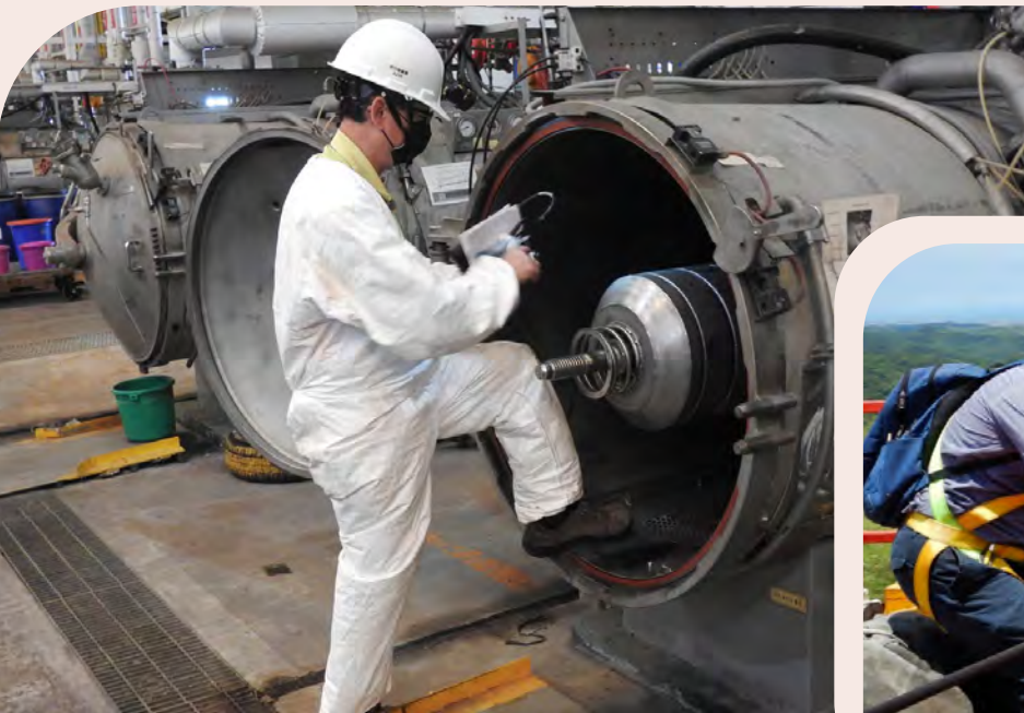
對高壓氣體特定設備實施內部檢查
