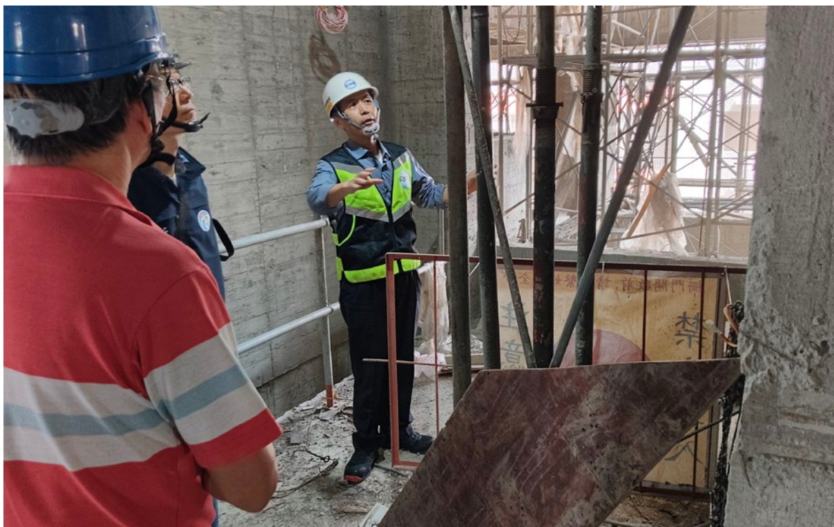
◎ 職安署林毓堂署長率隊實施營造工地勞動檢查
