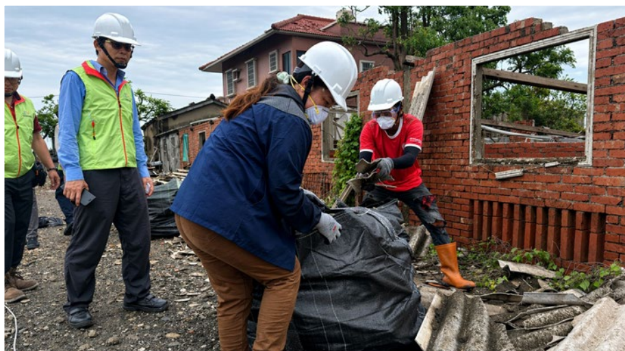
◎ 輔導團深入災區辦理石綿拆除作業危害預防輔導及提供諮詢
