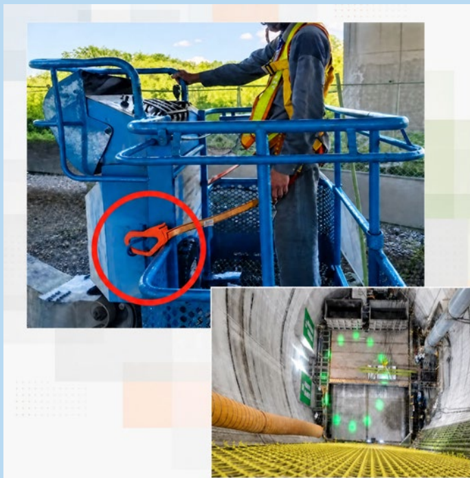
◎ 背負式安全帶掛勾及吊掛作業吊掛範圍安全可視化
