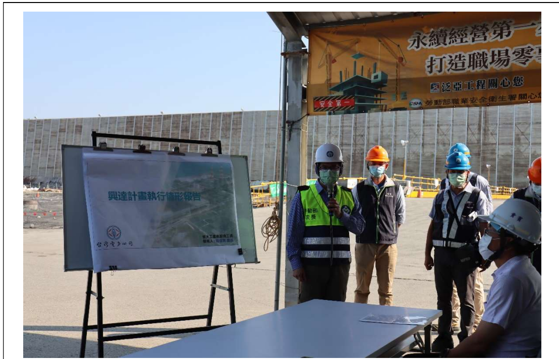
王尚志次長至興達電廠燃氣機組更新改建計畫工程，於現場說明聯合檢查目的
