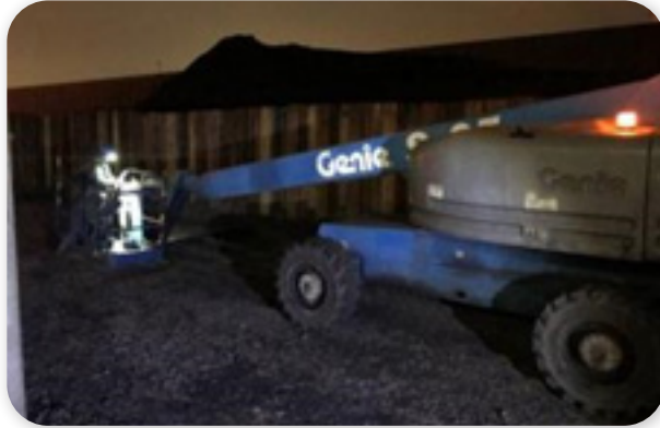
使用高空作業車載升檢測師至檢測管線所在高度
