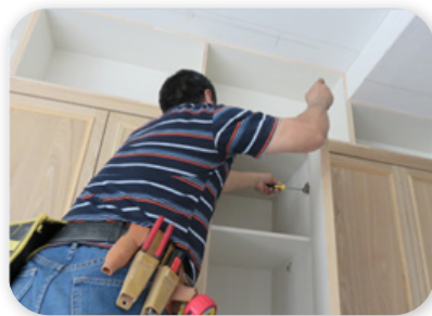
一手固定、一手持電鑽鎖門片
