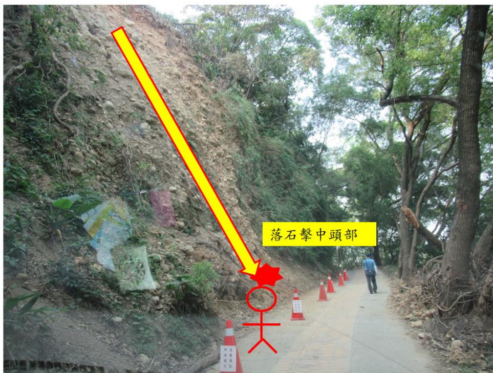
照片:事故點B，金員遭約從高度20公尺滑落直徑約10公分之落石擊中頭部，致創傷性腦傷
