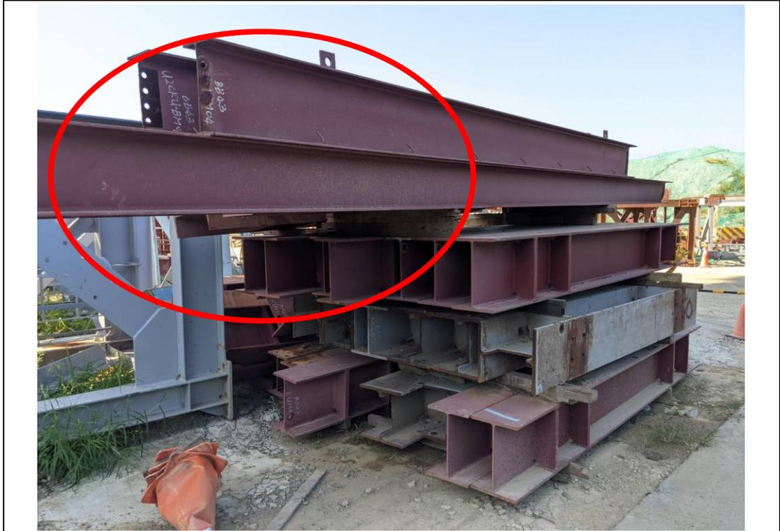
對於鋼構料件之堆放，未採取繩索網綁、擋樁、限制高度等防止倒崩塌之必要設施
