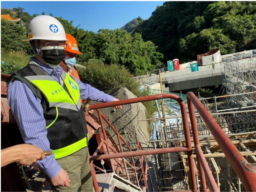
王尚志次長檢視機房施工架及模板支撐搭設情形
