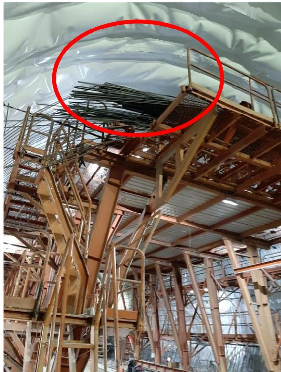
鋼筋工作架工作臺開口部分(高度約 6.7 公尺)護欄遭拆除未復原
