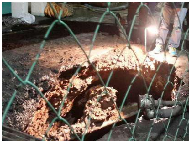
照片 2-1 崩塌土石掩埋現場位置示意圖
