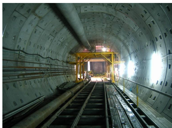
照片 1-3 潛盾工法施工情形
