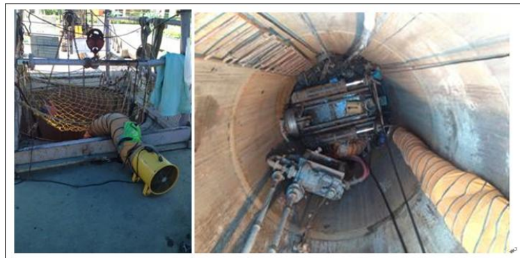
照片 2-2 推進作業工作井
