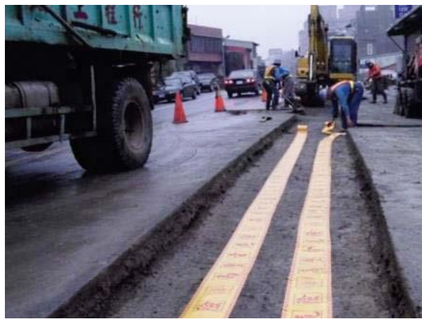
照片 4-10 警示帶鋪設施工情形
