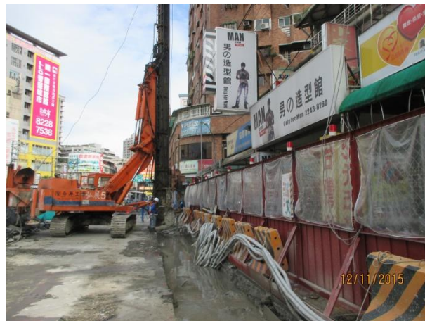
照片 4-5 建物保護地盤改良作業
