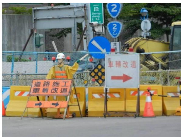
照片 4-7 設置阻絕設施、引導標誌及電動旗手
