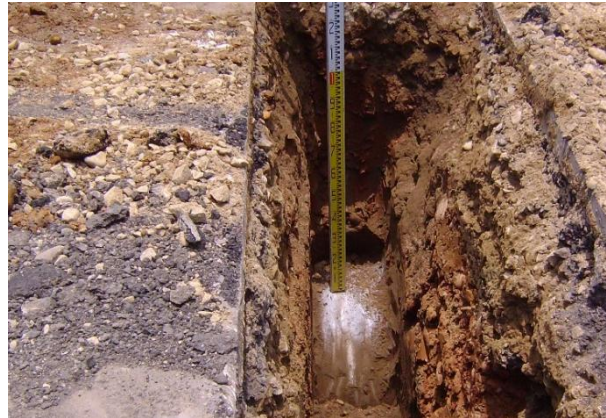
照片 4-1 試挖作業情形
