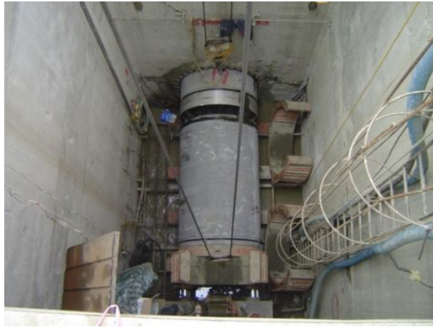
照片 1-4 推管工法施工情形
