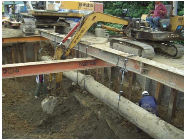
照片 4-3 管線懸吊保護作業情形
