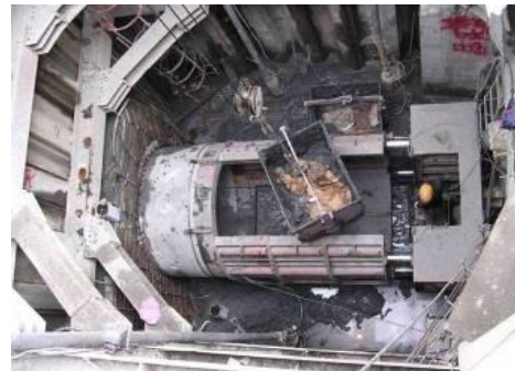
(4)鋼板樁工作井
