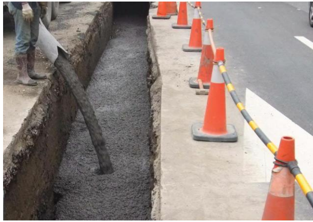
照片 4-9 管溝以 CLSM 回填作業情形
