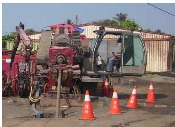
照片 1-2 水平導向鑽掘工法施工情形
