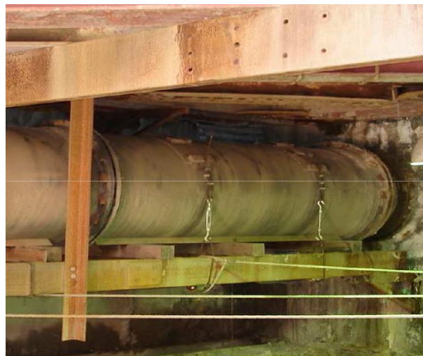
照片 4-4 管線支撐保護作業情形
