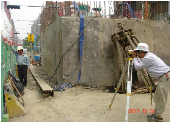
照片 4-6 地表沉陷監測作業
