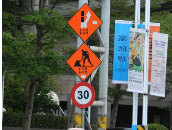
照片 4-8 設置施工改道及速限標誌
