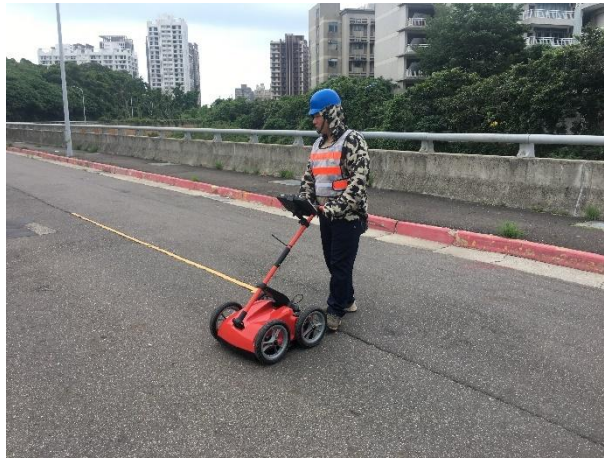
照片 4-2 透地雷達作業情形
